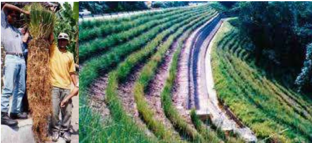
Anexo 2.3. Ejemplo de bioingeniería con arbusto (vetiver) en taludes de materiales sueltos.
