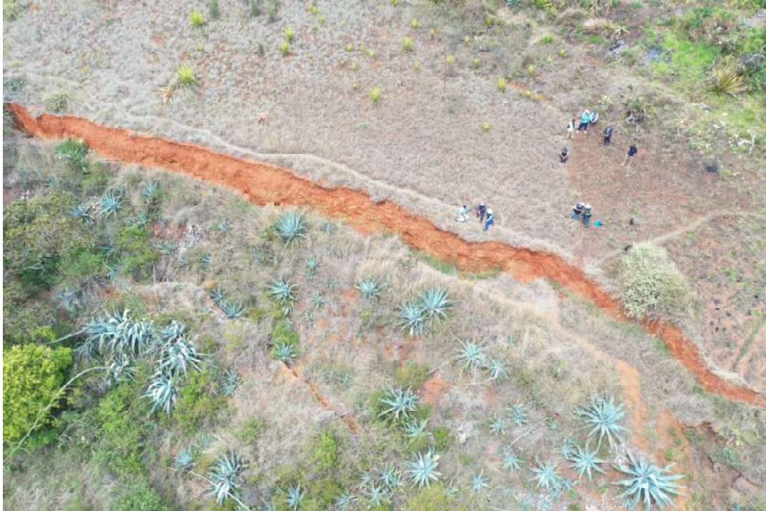
Fotografía 2. Vista área donde se muestra el escarpe principal en la corona del deslizamiento en el sector Iscopata. Presenta un salto de hasta 4 m de desnivel. Metros más abajo, se observa el escarpe secundario.
