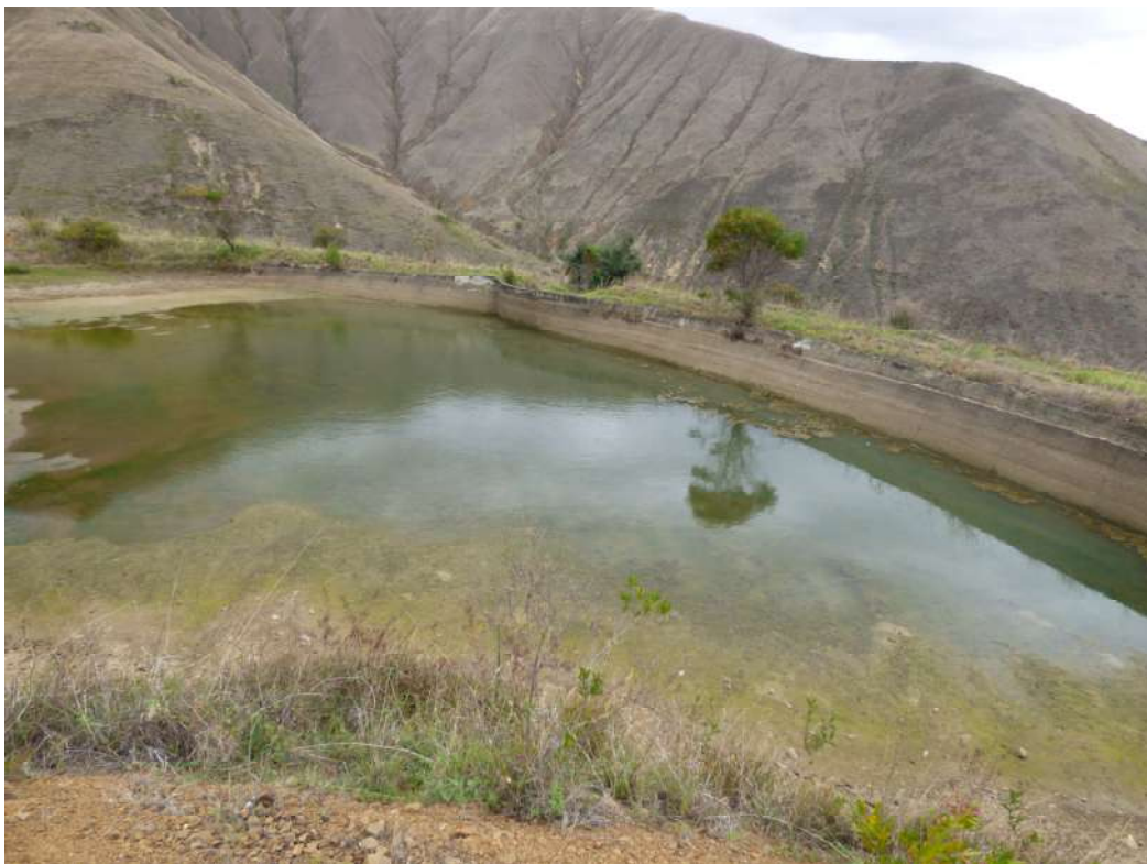
Fotografía 8. Laguna artificial represada ubicada a 1.4 kilómetros del deslizamiento activo que sirve de almacenamiento de agua, el cual es canalizada hacia los cultivos, a través de canales sin revestir que sobresaturan los terrenos inestables (357650E; 8897544N).
