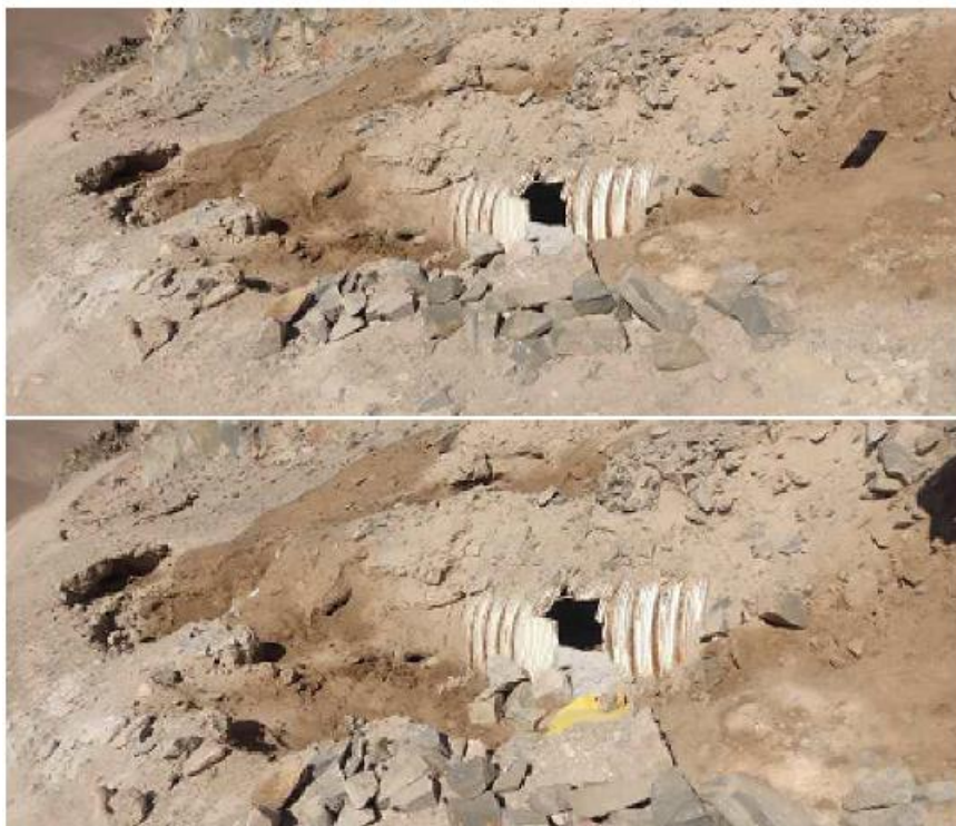
Fuente: Equipo técnico de Evaluación de Riesgos
