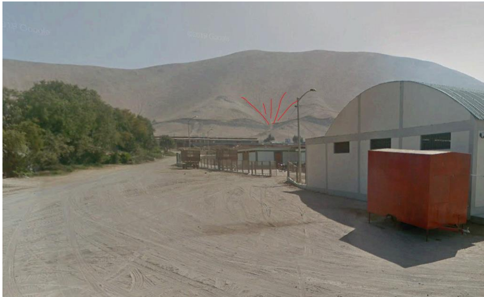
Fuente: Equipo técnico de Evaluación de Riesgos.
