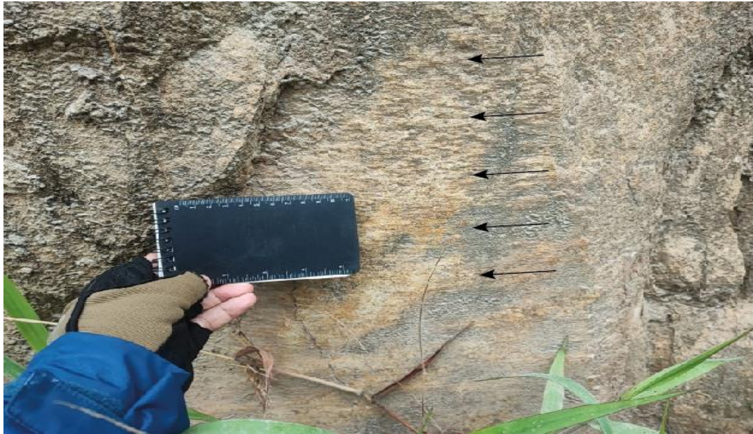
Figura N° 13: Vista de acercamiento en plano de falla con presencia de estrías. (763513/ 8542195).
