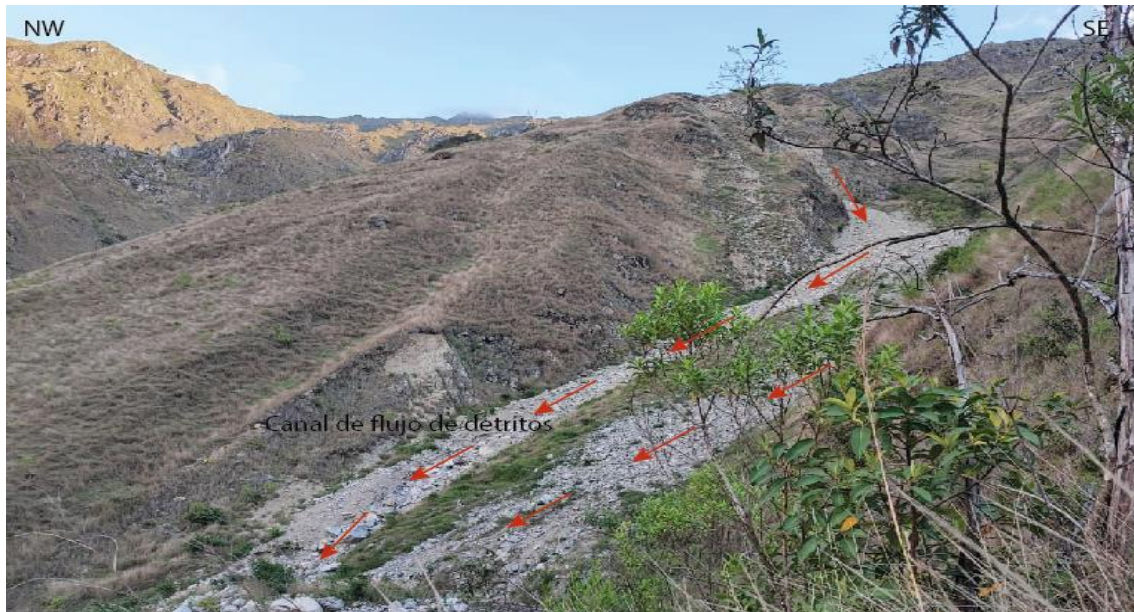
Figura N° 8: Vista de canal de flujo de detritos.
