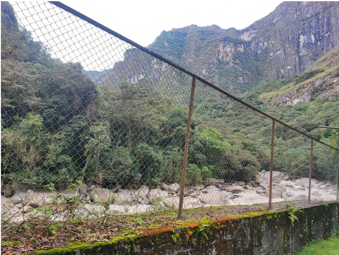
Figura N° 67: Muro de concreto con cerco de enmallado metálico.
