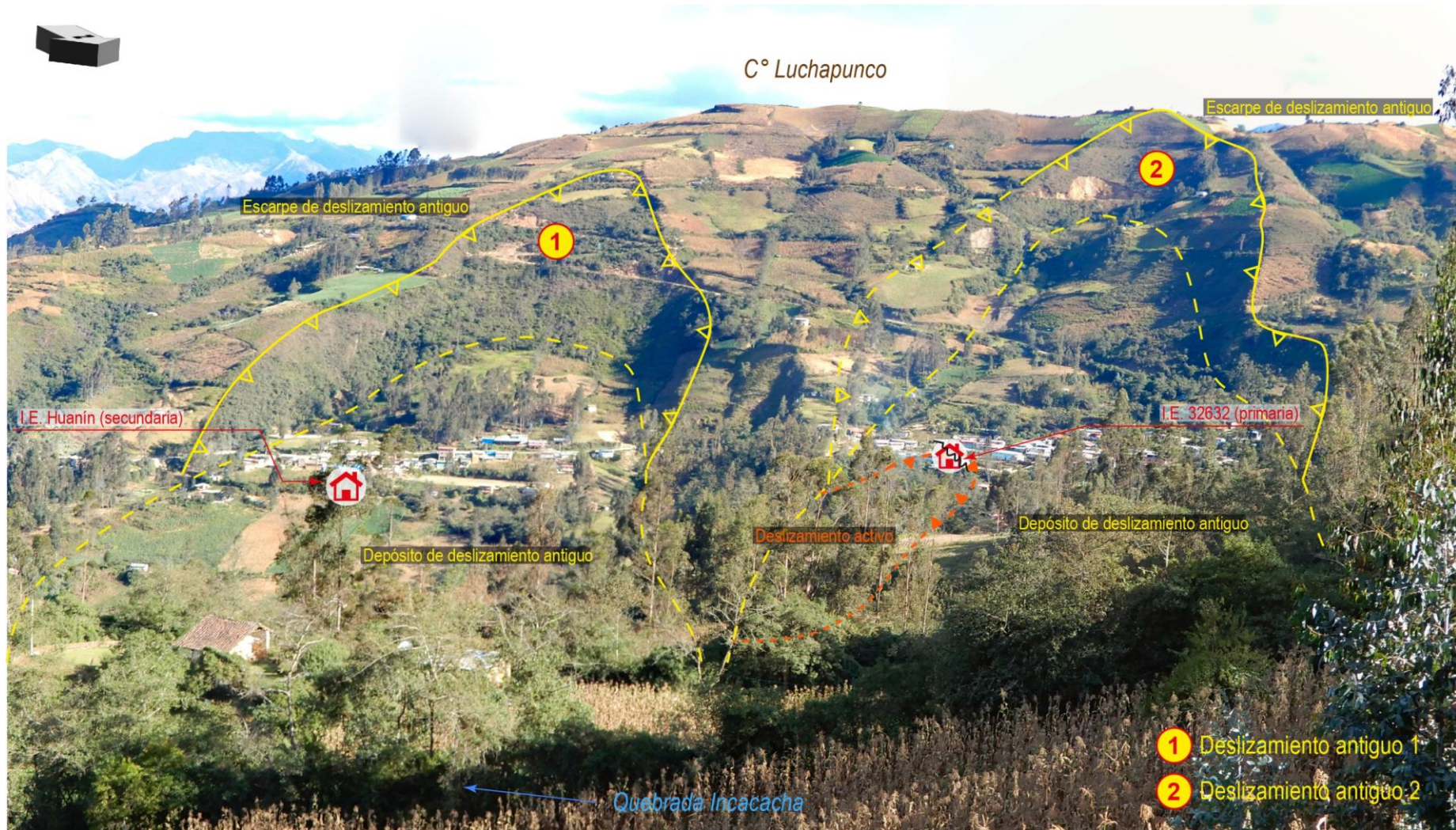
Figura 8. Procesos de eventos antiguos identificados en el sector Huanín. Nótese la población asentada sobre los depósitos de antiguos deslizamientos. Vista mirando al sur. Asimismo, se observa la I.E N32632 nivel primario se encuentra afectado por grietas de un deslizamiento activo.
