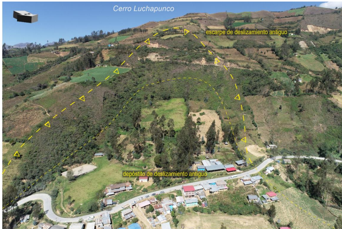
Figura 9. Deslizamiento antiguo 1 instalado en la ladera norte del cerro Luchapunco en el sector Huanín. Nótese la población asentada en el depósito antiguo.
