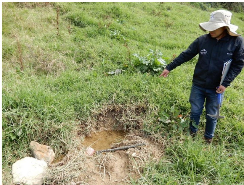
Fotografía 11. Surgencias de agua ubicados en el cuerpo principal del depósito del antiguo deslizamiento 1. Estos terrenos se hallan saturados que podrían intensificarse en épocas de precipitación y su relación con posibles reactivaciones por deslizamientos (386,136.69E 8,905,854.59N m).
