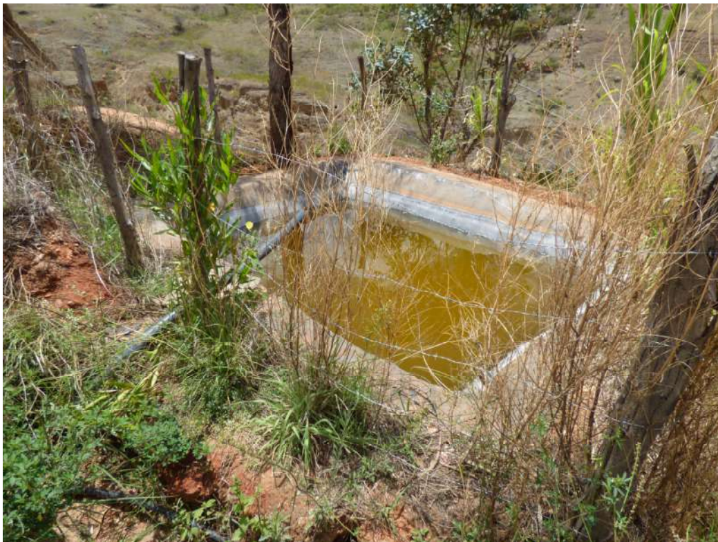
Fotografía 12. Reservorio artesanal de 4 m x 2 m póbrememente revestido para el almacenamiento de agua, ocasionan sobresaturación del suelo. Se ubica a 3 m de escarpe principal del deslizamiento (D2).
