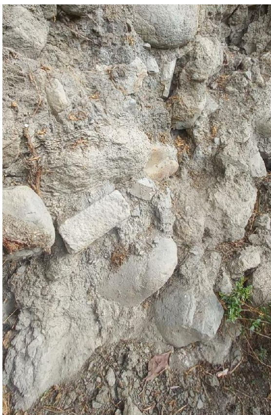
Figura 21. Material aluvional de baja plasticidad
