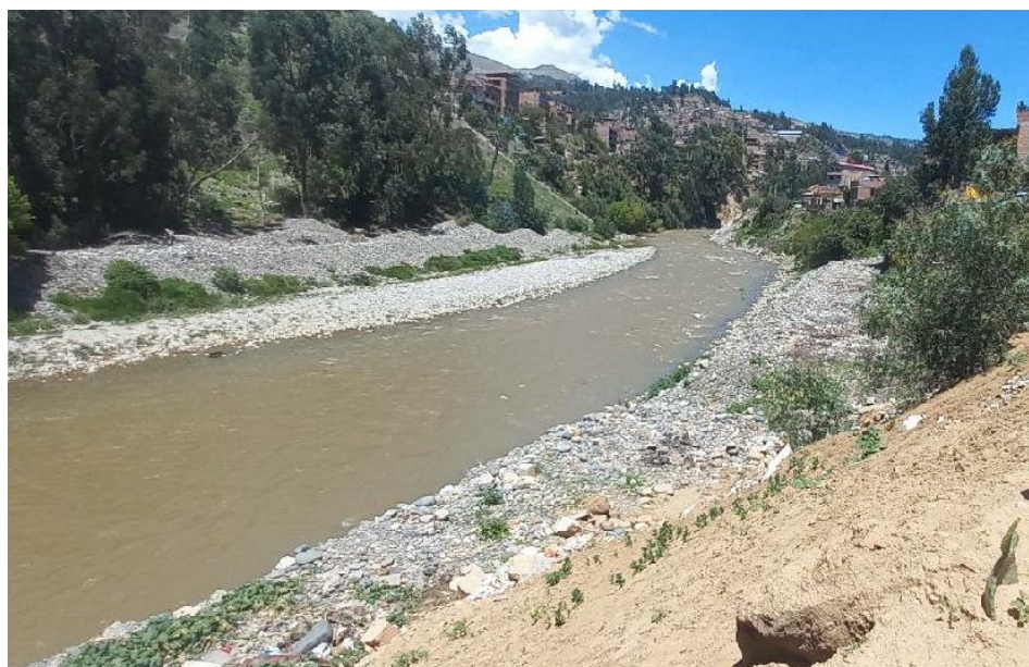
Figura 19. Cauce del río Santa.
