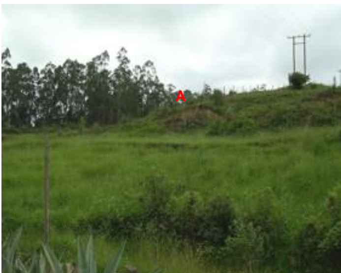
Fotografía 11: Vista de las escarpas con saltos del orden de 1 m (A), que ha producido asentamientos en el terreno.
