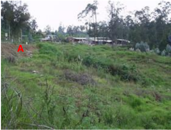
Fotografía 1: Vista del salto principal de movimiento complejo (A)
