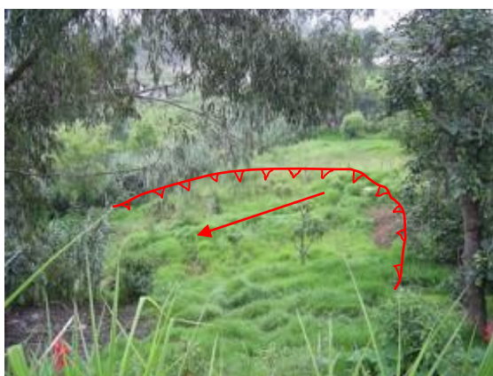
Fotografía 16: Deslizamientos hacia la cara libre de la quebrada, sector de El Carrizal, que afecto tubería de desagüe.
