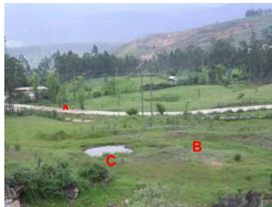
Fotografía 10: Vista ladera abajo donde se puede apreciar el tramo de carretera afectado (A), el terreno irregular (B) y la presencia de bofedales (C).
