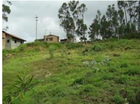
Fotografía 2: Escarpa del deslizamiento-flujo, vista ladera arriba.
