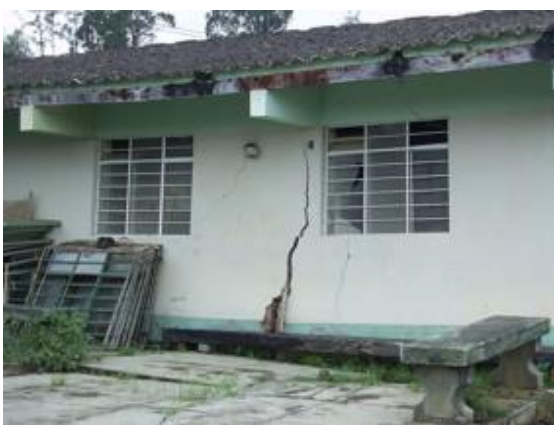
Fotografía 12: Estado actual de las instalaciones del hospital del IPSS.
