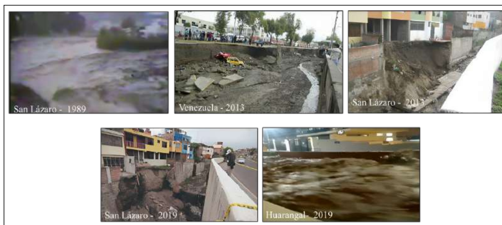
Figura 4.3 Daños causados por lahares en las quebradas San Lázaro y Huarangal.
