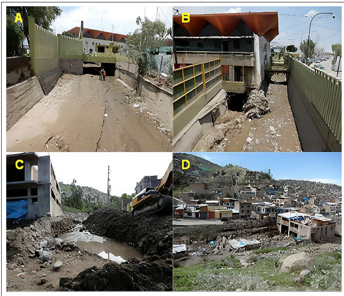
Figura 4.4 A) Sedimentos y bloques dejados por el lahar. B) Cauce de la quebrada Los Incas reducido hasta 4 m de ancho. C) Huaico empozado dentro de la quebrada, cancha de fútbol lleno de barro y basura D) sedimentos dejados por el lahar dentro de las viviendas.
