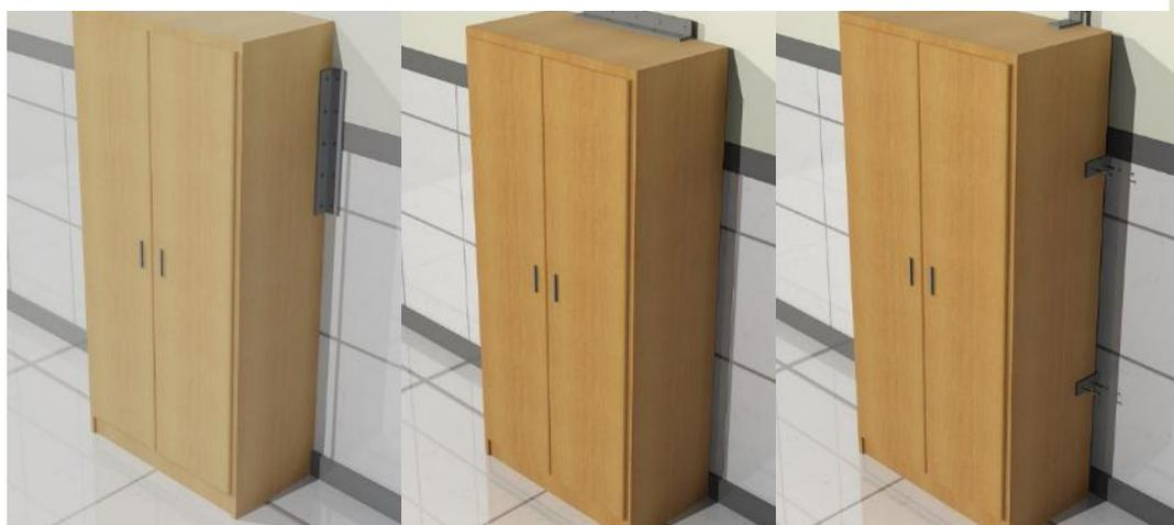
**Figura 20:** Muebles y armarios deben estar fijados y asegurados afin de evitar caídas que afecten al personal de salud o que obstruyan salidas o corredores de evacuación.
