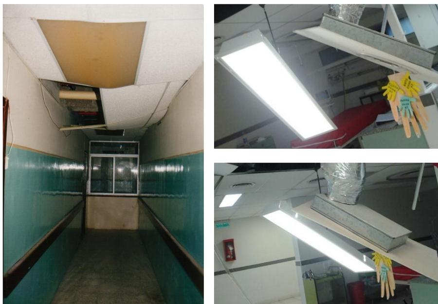
**Figura 6:** Falsos cielos rasos se desprenden por deficiencia en anclajes ante movimientos sísmicos
