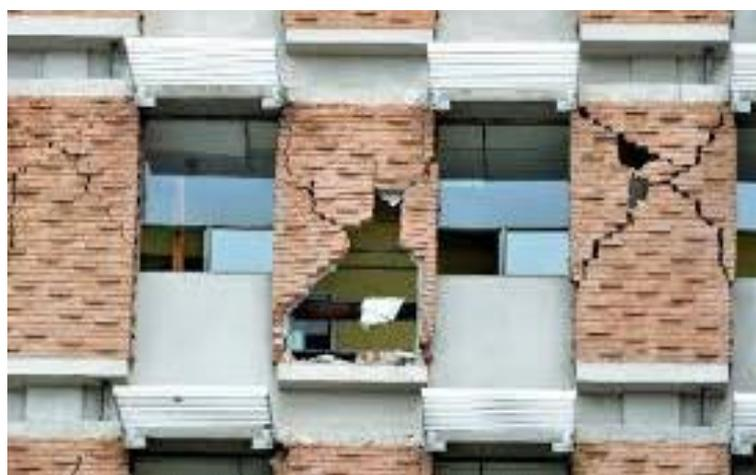
**Figura 5:** Baldosas en fachadas, que se desprenden por efecto de sismos intensos
