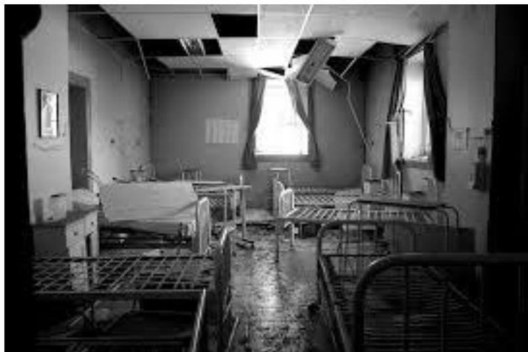
**Figura 10:** luminarias no sujetadas adecuadamente en techo ante movimientos sísmos, se caen e incrementan el peso del falso cielo raso provocando colapso del sistema.
