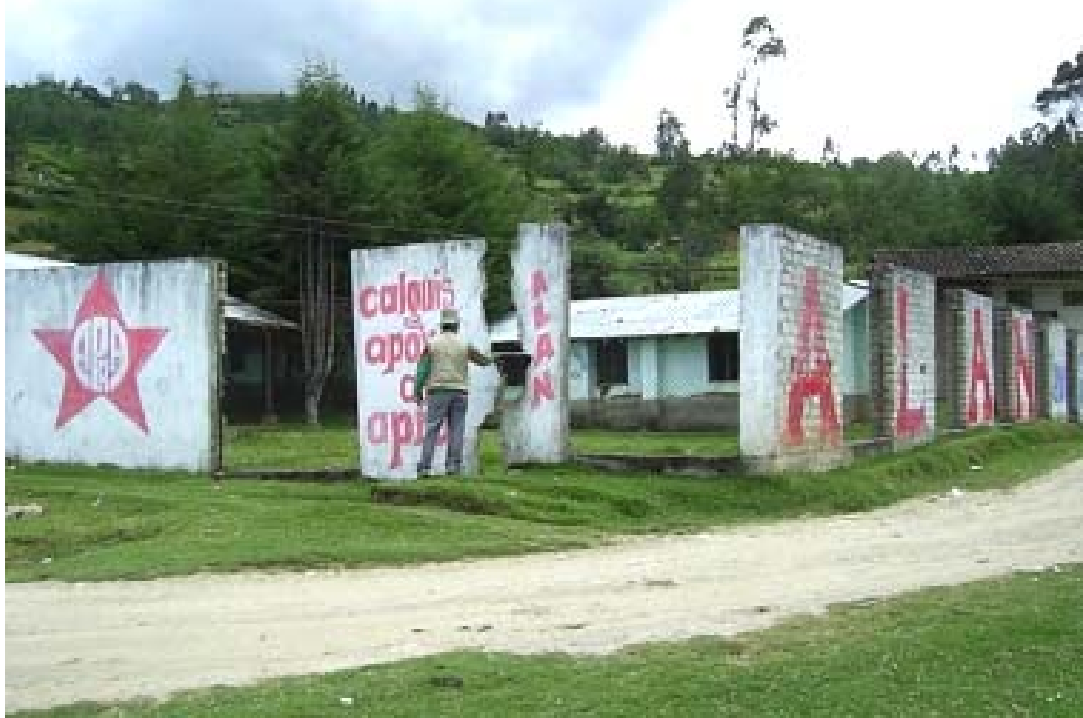
Vista del estado en que quedo la posta medica del poblado de Calquis que fue afectado por el deslizamiento-flujo anterior, San Miguel de Pallaquez.
