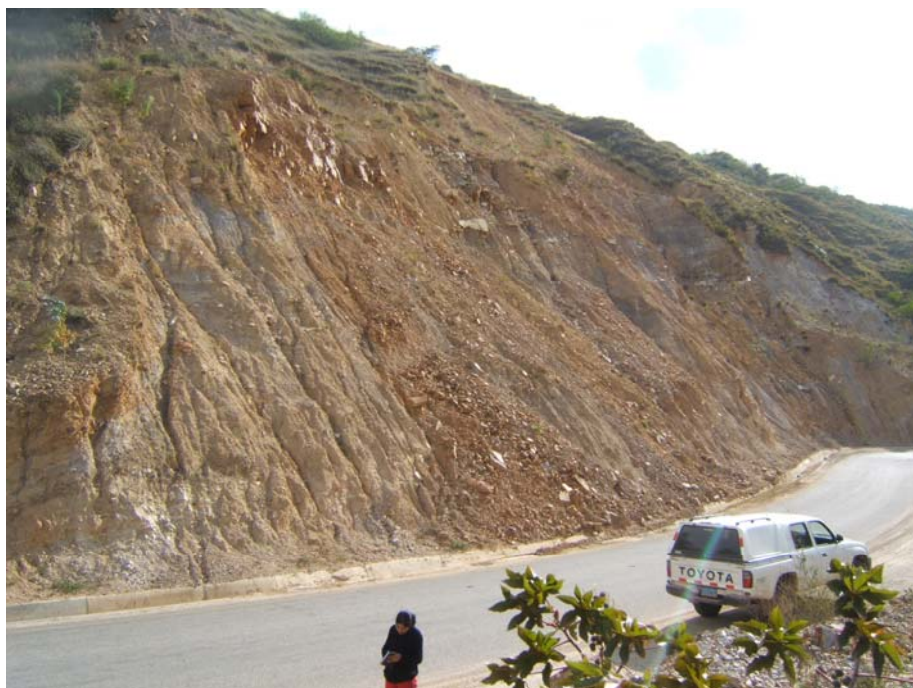
Sector de Chulucana, tramo de la carretera entre Cajamarca y San Marcos afectado por deslizamientos y derrumbes en los taludes de corte.
