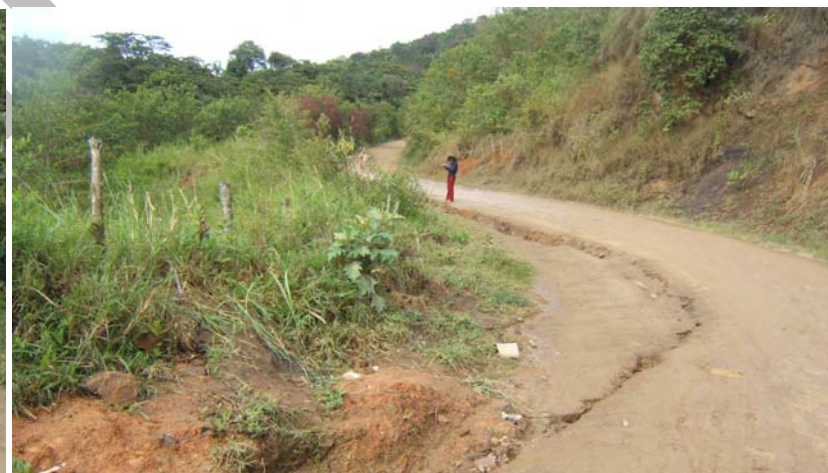
Asentamientos en la plataforma de carretera entre San Ignacio y Namballe originados por deslizamientos de tierras.
