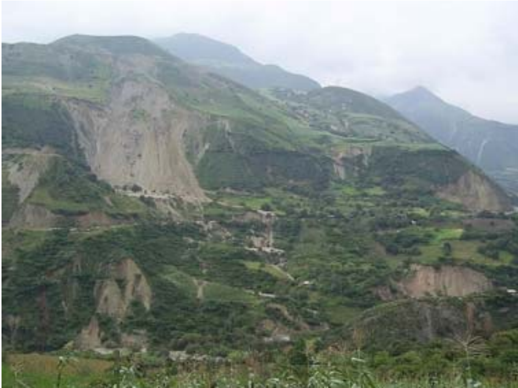
Km. 129+000 de la carretera ha Cajamarca, deslizamientos activos producen la pérdida de terrenos de cultivo y carretera.
