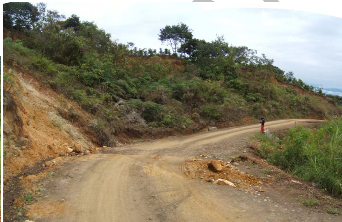
Tramo de la carretera entre San José de Lourdes y Los Llanos (Km. 4 + 900), afectado por un deslizamiento de tierras. Nótese los asentamientos en la plataforma y las escarpas en el talud inferior (izq.).
