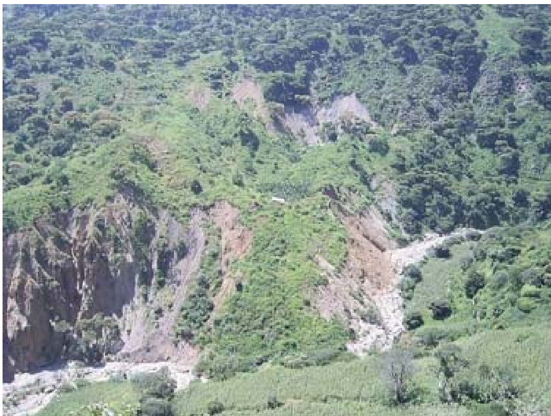
Deslizamientos en la margen derecha del río Huertas, erosión al pie puede represar el río.
