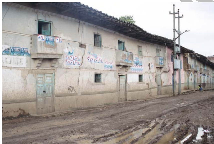
Sector de Huambos. Agrietamientos en las viviendas, colegio y plaza de toros. Proceso de deslizamiento activo que afecta área urbana.
