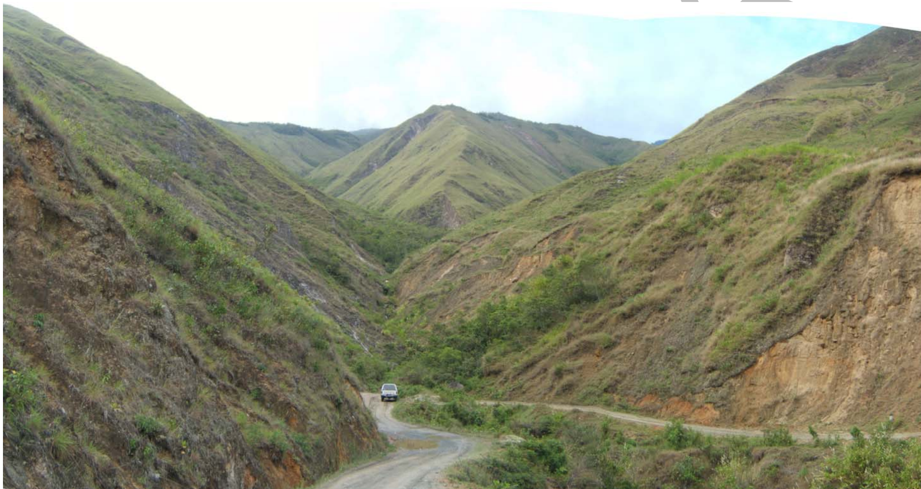
Sector Alisal, afectado por derrumbes y deslizamientos en las laderas que comprometen tramo de carretera entre Tamborapa y Tabaconas.
