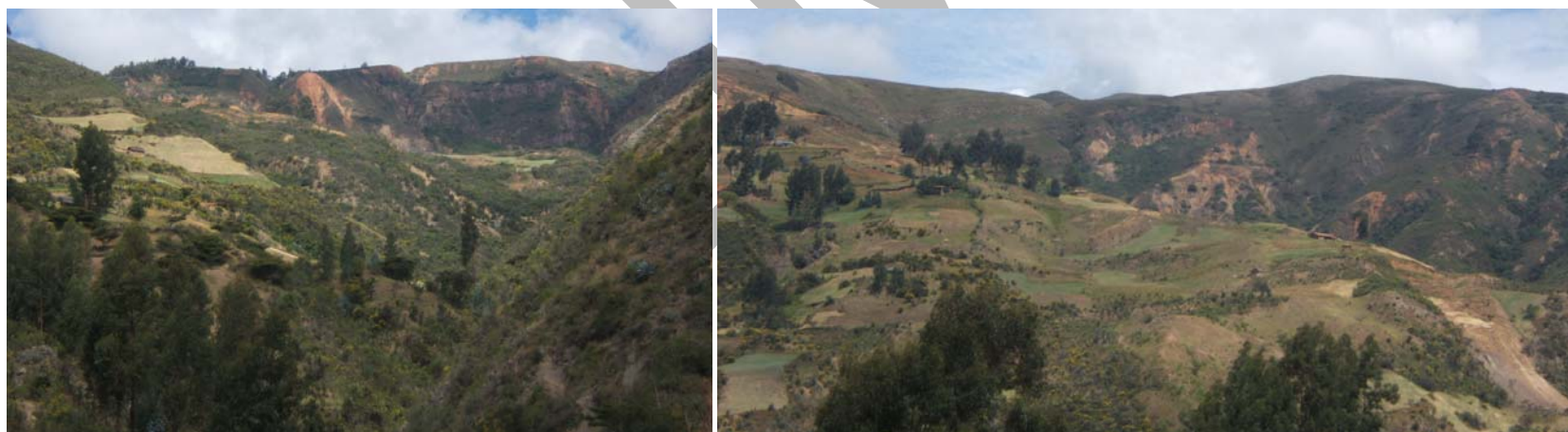
Microcuenca de la quebrada Araqueda, donde se presentan problemas de derrumbes, deslizamientos, huaycos y erosión fluvial. Afectan principalmente áreas de cultivo y carretera entre Chuquibamba, Araqueda y Algamarca.
