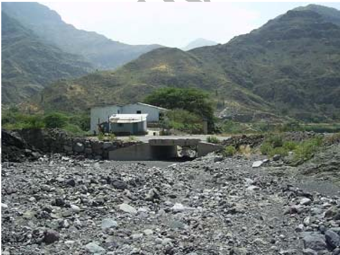
Quebrada Nazario, aguas abajo, se puede apreciar el material suelto en el cauce, Yonan, Cajamarca.
