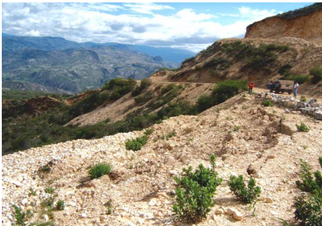
Agrietamientos y saltos del deslizamiento en el sector de Tayapampa (Distrito de Chancay Baños, Provincia de Santa Cruz).
