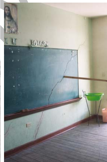
Sector de Huambos. Agrietamientos en las viviendas, colegio y plaza de toros. Proceso de deslizamiento activo que afecta área urbana.
