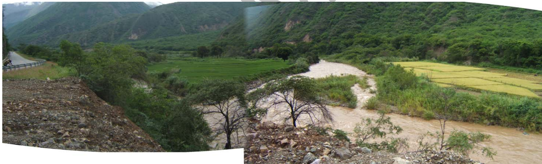
Zona Crítica por derrumbes y caída de rocas en los taludes de carretera, así como huaycos en ambas márgenes del río Huancabamba.
