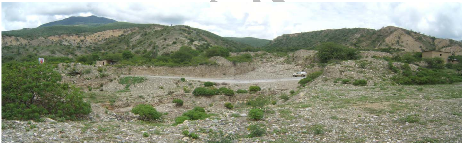
Huaycos en las quebradas Chuquil, Jahuay y Palo Blanco que frecuentemente afectan tramos de la carretera Pucará-Jaén.
