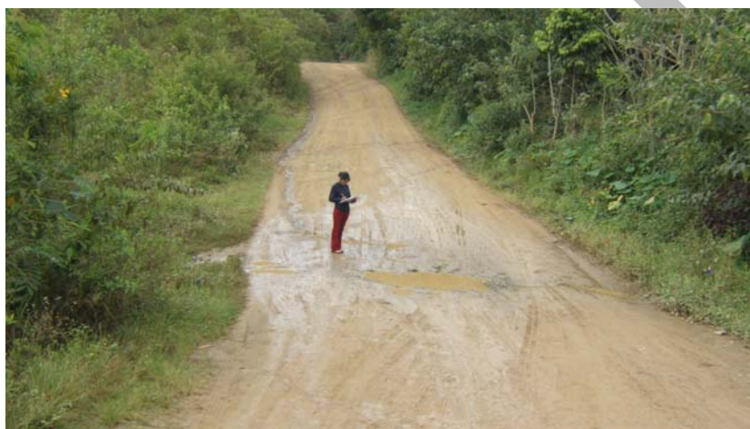
Asentamientos en la plataforma de carretera entre San Ignacio y Namballe originados por deslizamientos de tierras.
