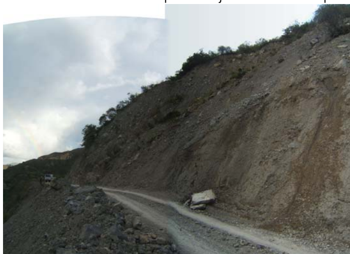
Valle del río Grande que muestra un tramo de la carretera entre Celendín y Llanguat, afectado por derrumbes y caída de rocas en los taludes.
