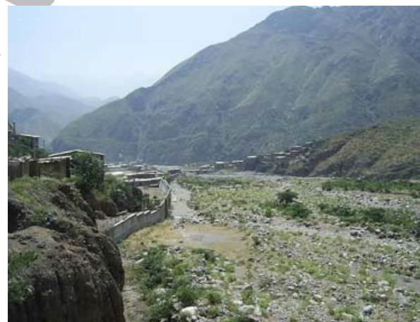
Quebrada Monte Grande, discurren huaycos de gran magnitud que cortan tramos de carretera a Cajamarca Km. 44+000
