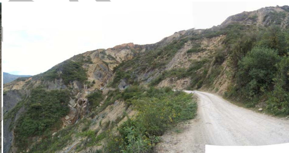
Valle del río Grande que muestra un tramo de la carretera entre Celendín y Llanguat, afectado por derrumbes y caída de rocas en los taludes.
