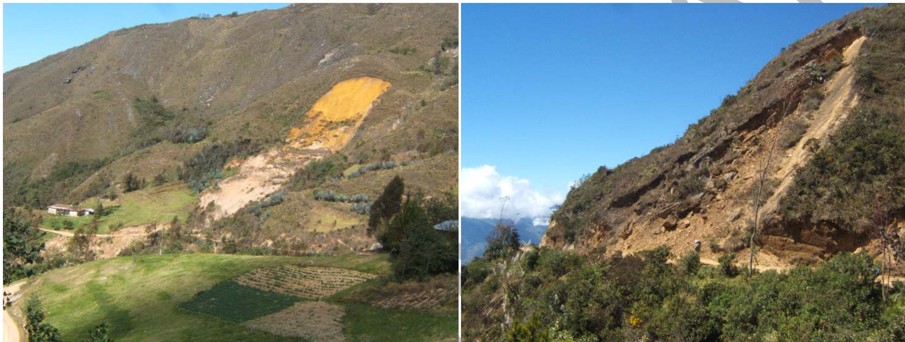
Deslizamientos traslacionales en la quebrada del sector El Porvenir, que afectan tramos de la carretera entre Conga y La Púcara.
