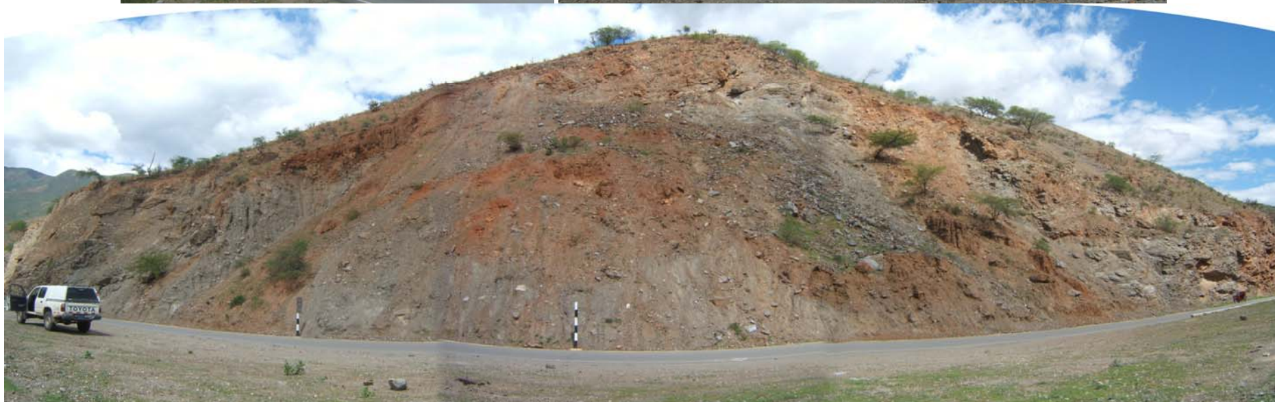
Amplio sector entre las quebradas Huabal y Tasajeras donde los taludes de corte con rocas muy alteradas muestran procesos de erosión de laderas, derrumbes, caída de rocas y deslizamientos, huaycos canalizados en las quebradas.
