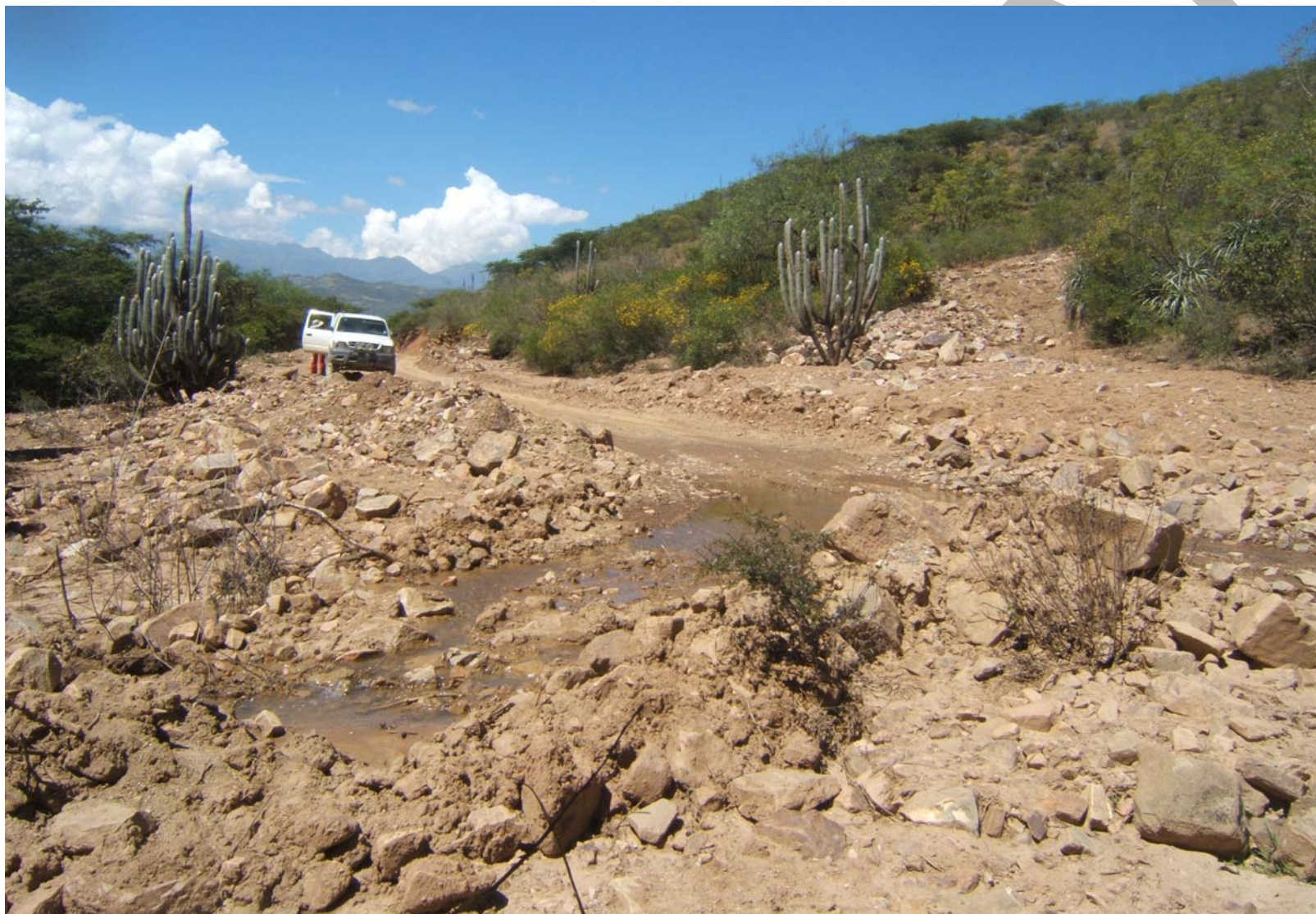
Depósito de huayco que afectó un sector de la carretera Tabacal-Cachachi.
