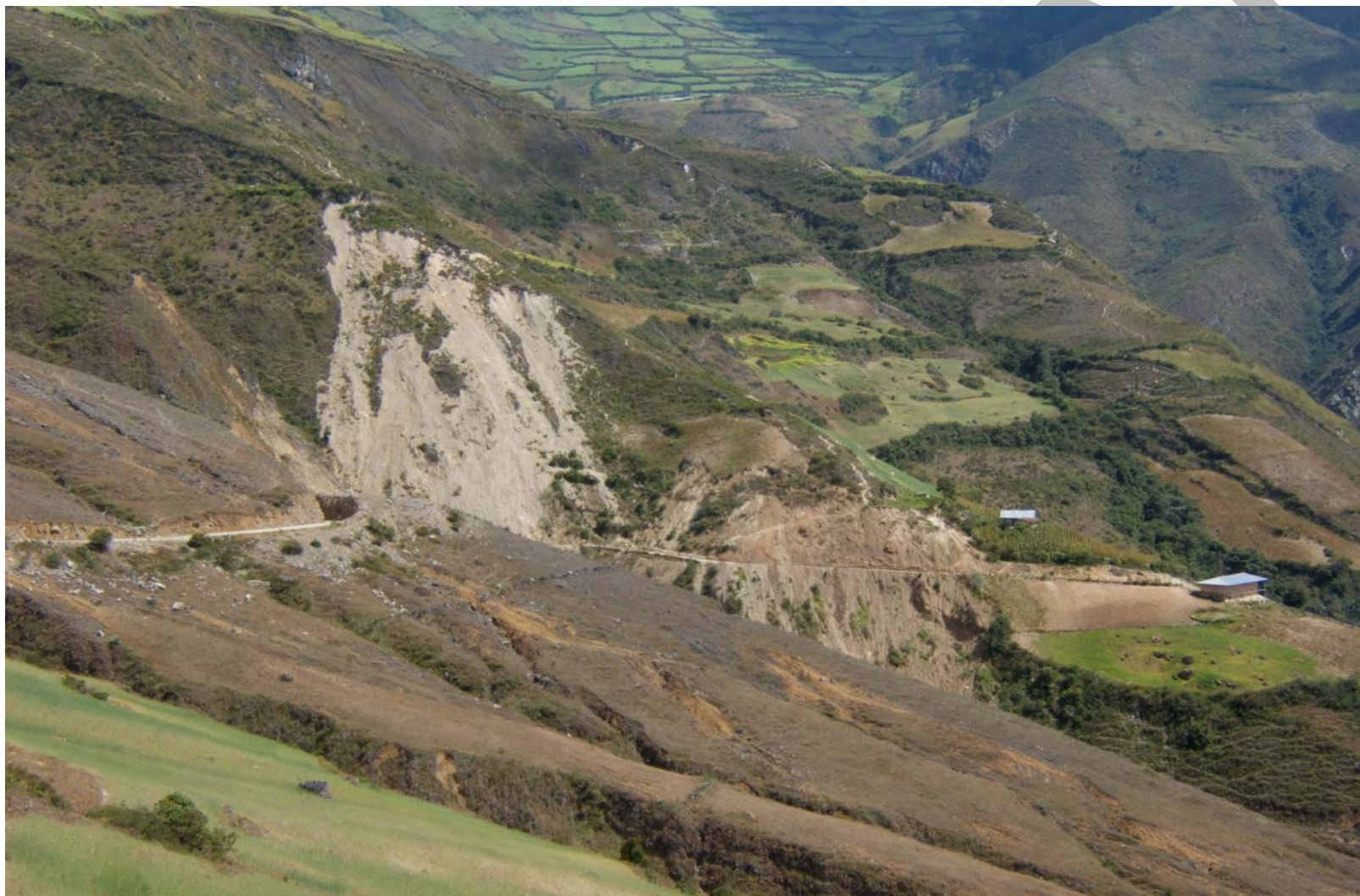
Deslizamiento traslacional que afecta tramo de la carretera de acceso a Chumuch.
