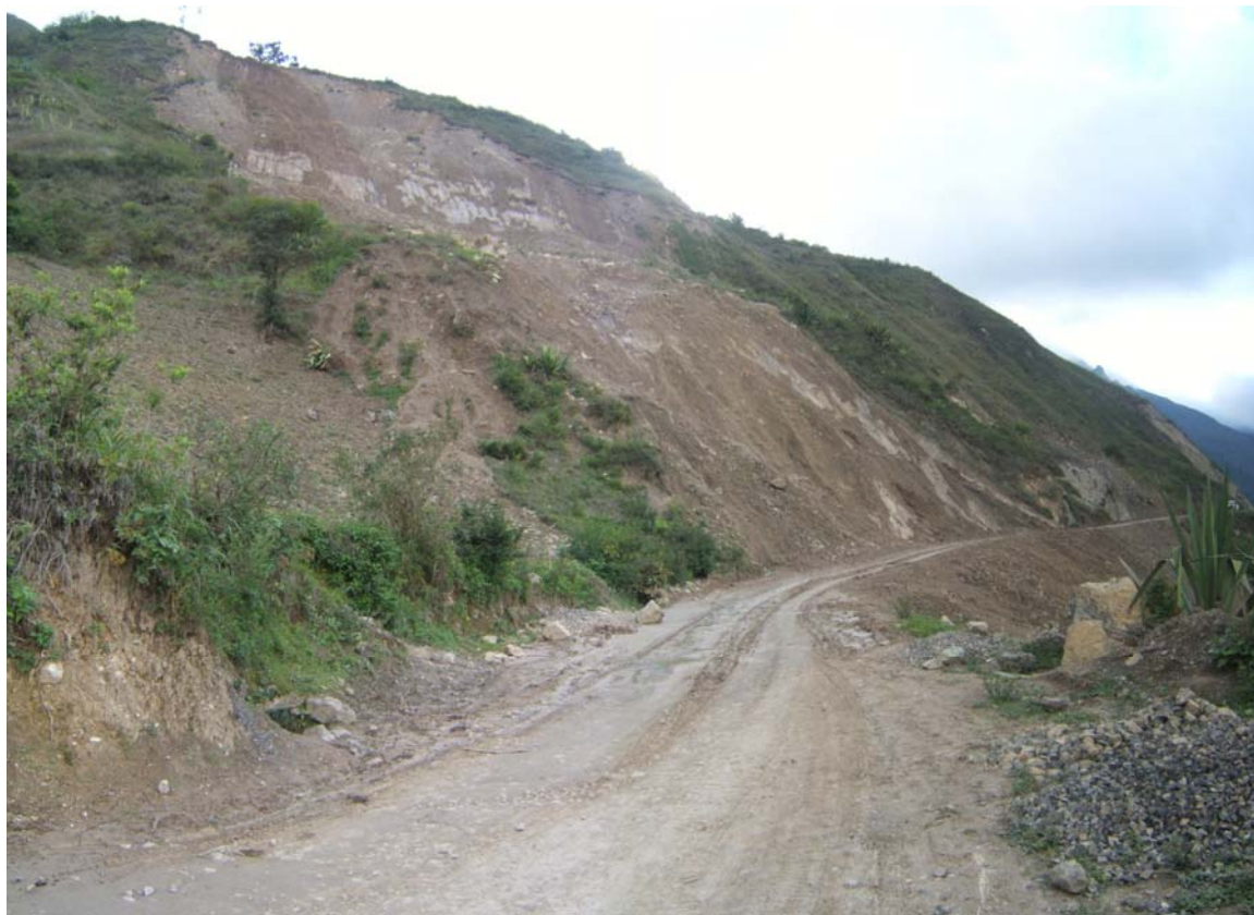
Deslizamientos traslacionales en el Sector de El Pollo, cerca de Paccha, afectan periódicamente tramo de carretera de acceso a Paccha y Chadín.
