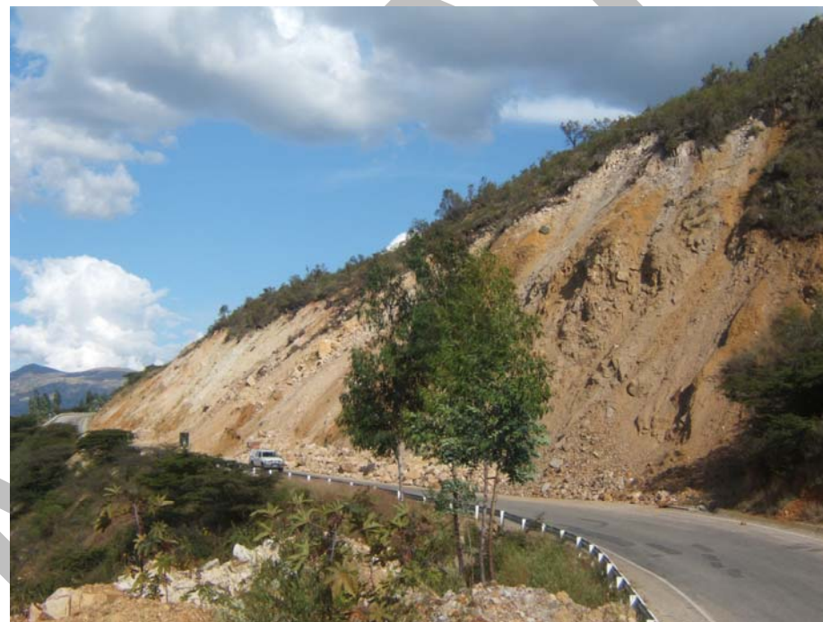
Sector de Chulucana, tramo de la carretera entre Cajamarca y San Marcos afectado por deslizamientos y derrumbes en los taludes de corte.
