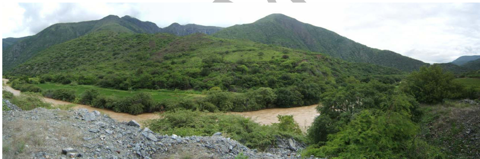
Cerro Olimpo, área susceptible a caída de rocas, derrumbes y vuelcos en los taludes de corte de carretera. En la vista inferior gran depósito antiguo de avalancha de rocas.
