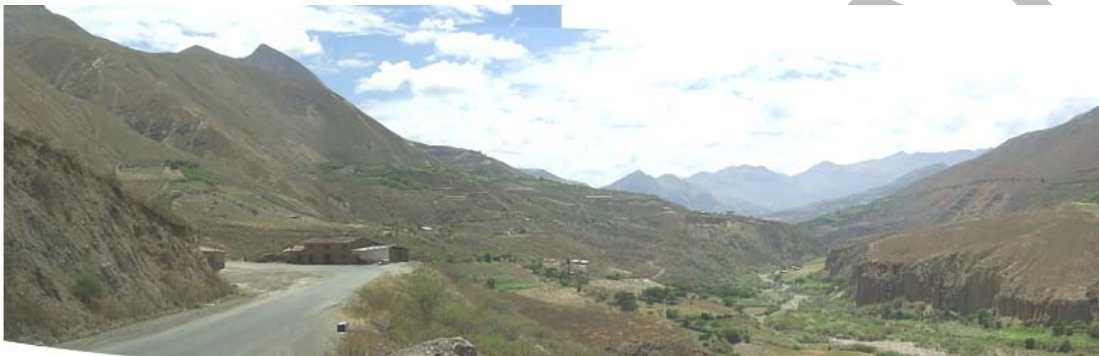
Vista panorámica del sector de Huana Huana, carretera atraviesa un deslizamiento antiguo reactivado, pérdida de plataforma de carretera.
