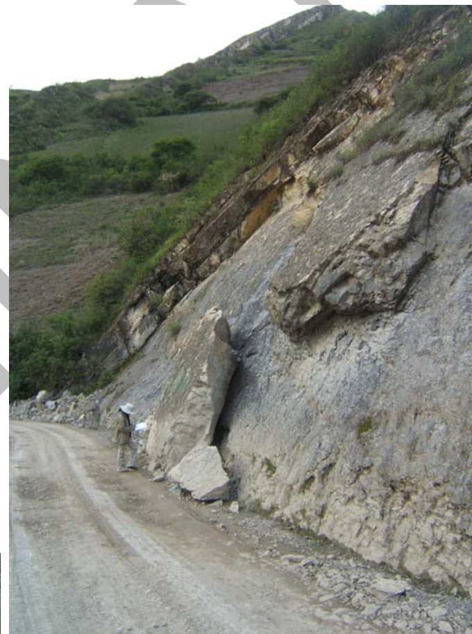
Deslizamientos traslacionales en el Sector de El Pollo, cerca de Paccha, afectan periódicamente tramo de carretera de acceso a Paccha y Chadín.
