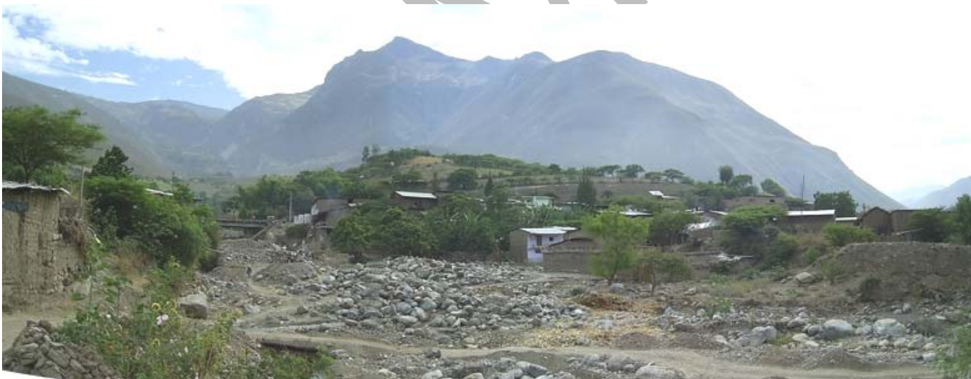
Vista panorámica del sector de Huana Huana, carretera atraviesa un deslizamiento antiguo reactivado, pérdida de plataforma de carretera.
