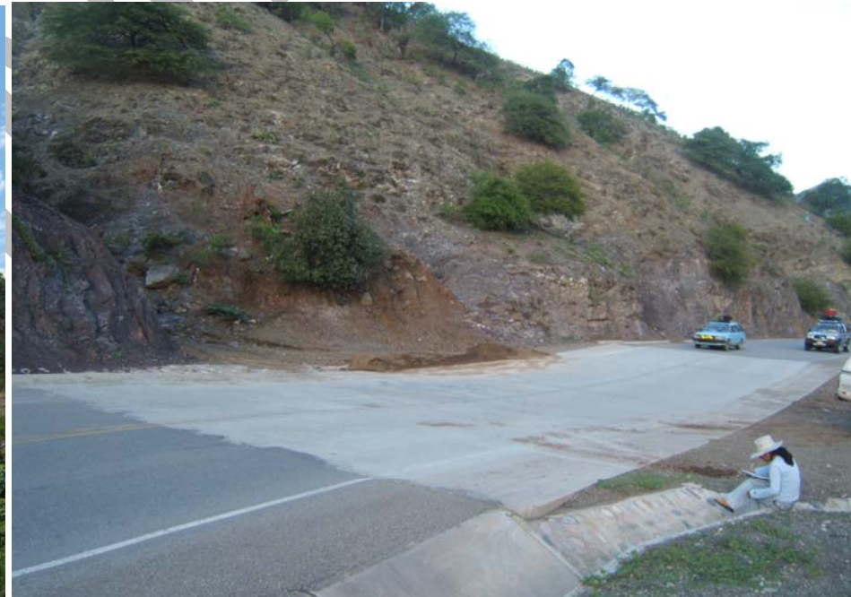
Sector entre Tuntupampa y Pampa Verde. Zona crítica con taludes de corte afectados por derrumbes, vuelcos y huaycos estacionales.
