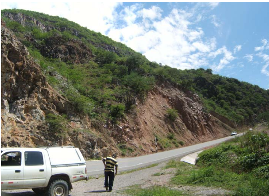
Sector entre Tuntupampa y Pampa Verde. Zona crítica con taludes de corte afectados por derrumbes, vuelcos y huaycos estacionales.
