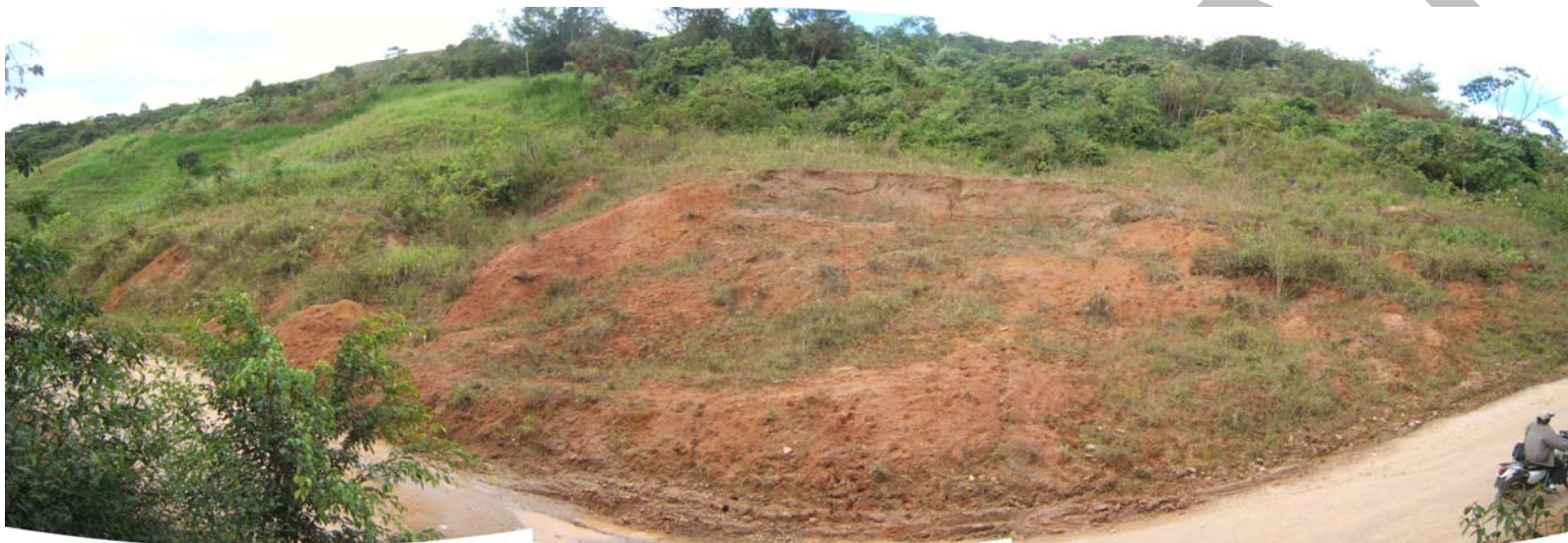
Deslizamiento rotacional activo que afecta tramo de la carretera de acceso a San Ignacio.
