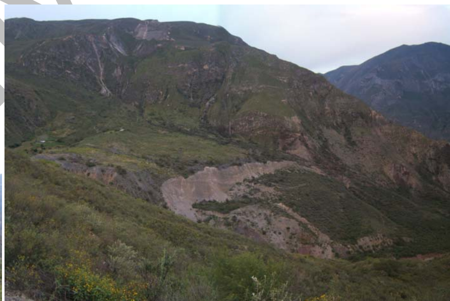
Vista de los valle del río Grande (foto superior), y quebrada Santa Catalina (fotos inferiores), que muestra escarpas de deslizamientos antiguos y recientes, que comprometen tramos de la carretera entre Celendín y Chalán.
