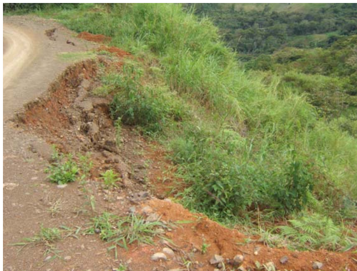
Tramo de la carretera entre San José de Lourdes y Los Llanos (Km. 4 + 900), afectado por un deslizamiento de tierras. Nótese los asentamientos en la plataforma y las escarpas en el talud inferior (izq.).
