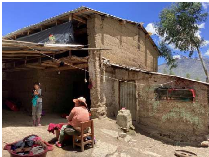
Foto N° 17: Vista de las características constructivas de las viviendas del Sector Hiushin
