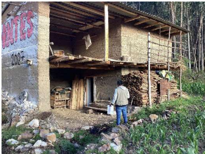
Foto N° 09: Vista de las características constructivas de las viviendas del Sector Nuevo Progreso
