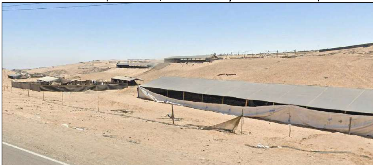
Gráfico N° 28. Vista del área de intervención del proyecto, ubicada fuera de la faja marginal de la quebrada del Diablo. Se observa terreno de pendiente suave, sin evidencias de flujo de detritos ni afectación por escorrentía
