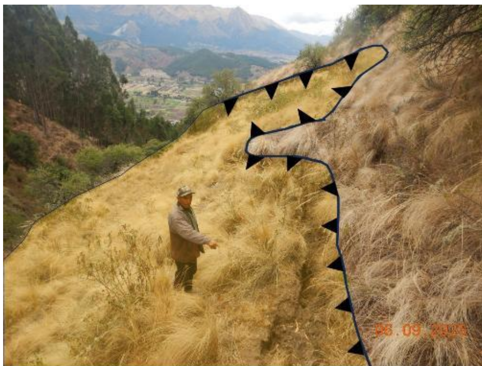
Figura 9: Deslizamiento rotacional en el sector Negro K'aka.
