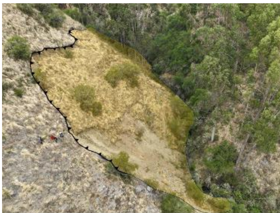
Figura 10: Vista del deslizamiento que alcanza parte del cauce de la quebrada Miskiuno en el sector de Negro K'aka.
