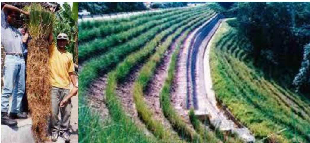
Anexo 2.3. Ejemplo de bioingeniería con arbusto (vetiver) en taludes de materiales sueltos.
