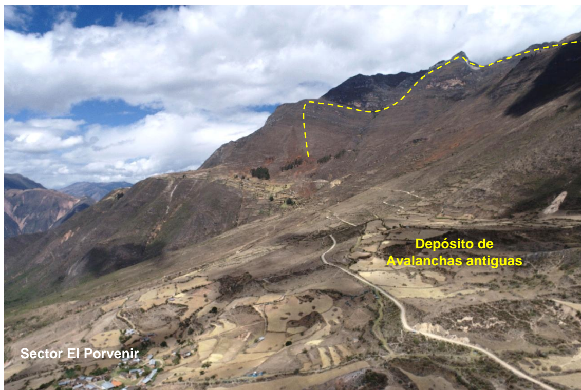
Fotografía 5. Depósito de avalanchas antiguas alojados en la ladera media de los cerros Puquio y Pilanco, sobre este depósito se asentó la población de El Porvenir, donde actualmente representa actividad geodinámica activa. Vista mirando al sur.
