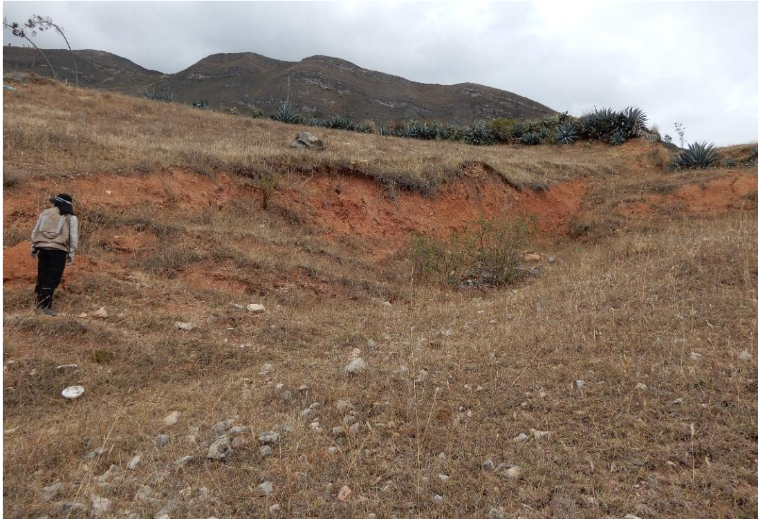
Fotografía 8. Escarpe principal ubicado en el flanco derecho del deslizamiento activo. Nótese, el salto de 0.8 a 1.2 m con respecto a la vertical. Vista mirando al oeste.
