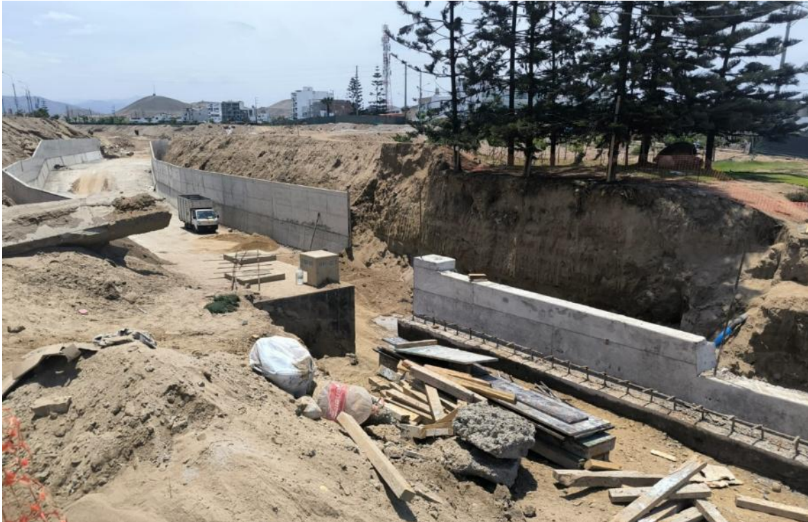
Fotografía 7. Trabajos de encauzamiento de la quebrada. Imagen tomada en febrero 2026. Vista hacia el SE.
