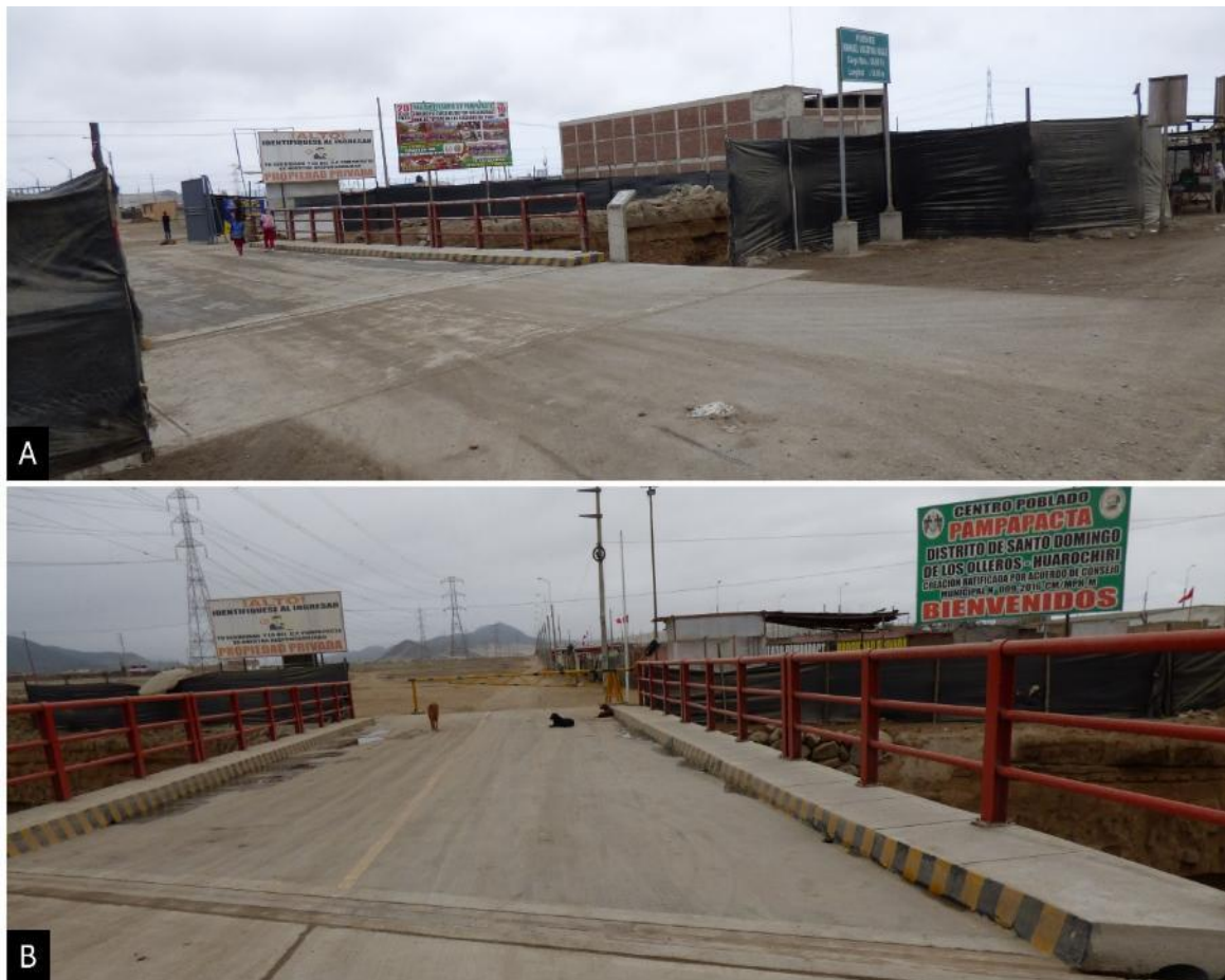
Figura 18. A. Puente “Manuel Valdivia Valle”, (altura de 10.4 m y una longitud de 18 m). B. puente “Tulipanes” (ancho de 17.7 m y longitud de 11 m).
