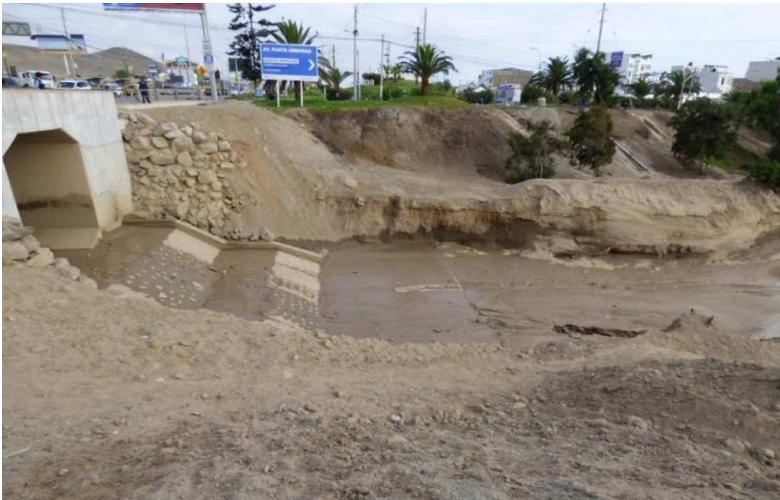
Fotografía 4. Flujo de febrero del 2025. Se observa el paso del flujo a través de la estructura de concreto armado y plataforma escalonada, el depósito de mayor proporción se observa al termino de dicha plataforma.
