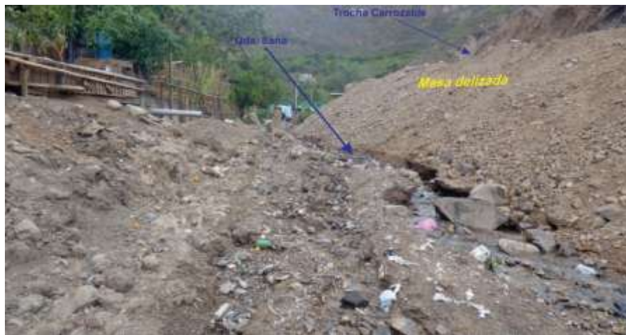
Foto 4. Se muestra la masa deslizada por efecto del deslizamiento.
