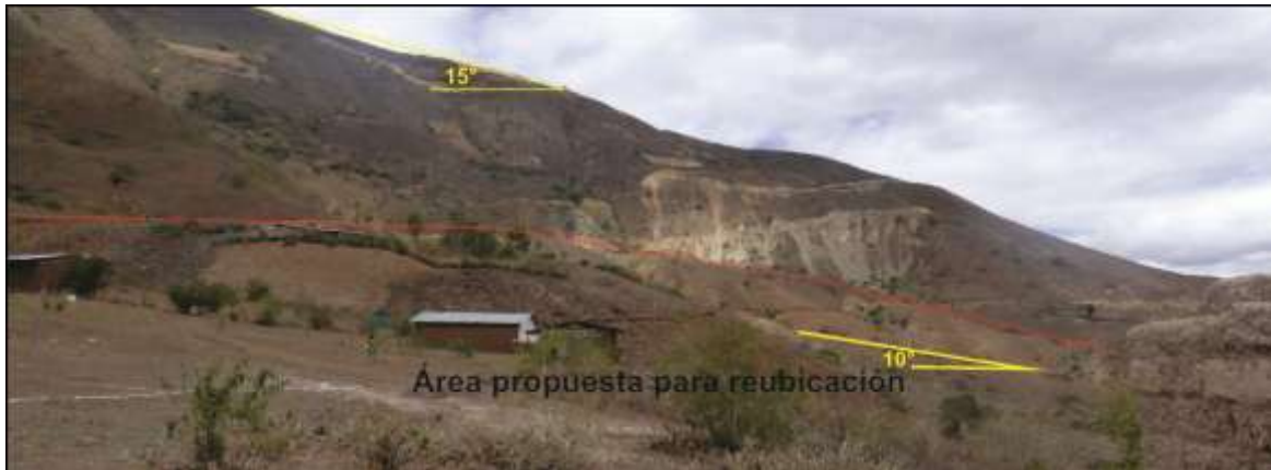
Foto 25. Parte del área de reubicación limitada con línea roja y las pendientes del terreno.
