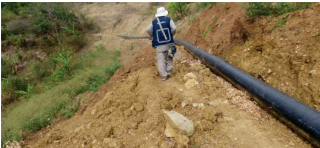
Foto 16. Tubería de agua para regadío, ubicada sobre el cuerpo del deslizamiento antiguo.
