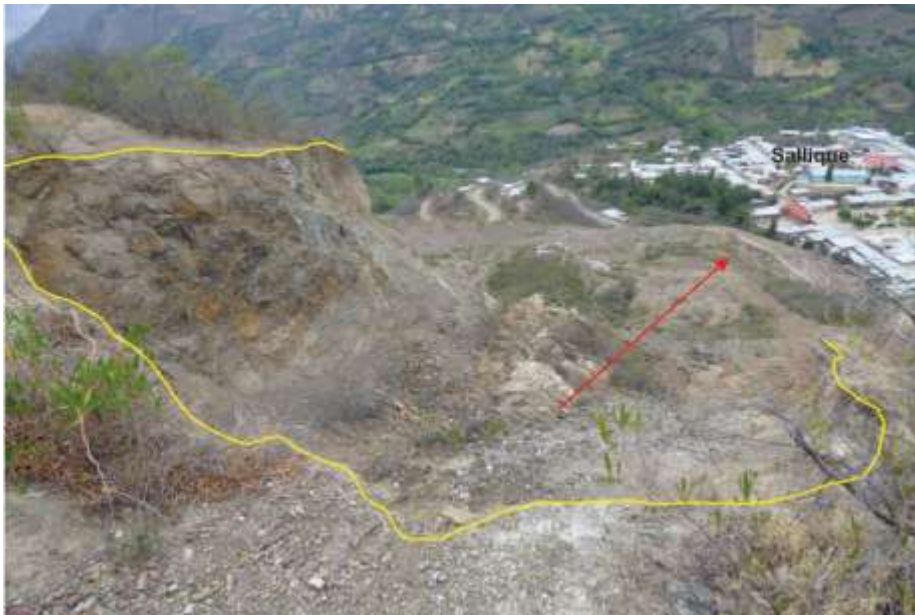
Foto 5. Se aprecia parte de la escarpa principal del deslizamiento de Sallique (1).
