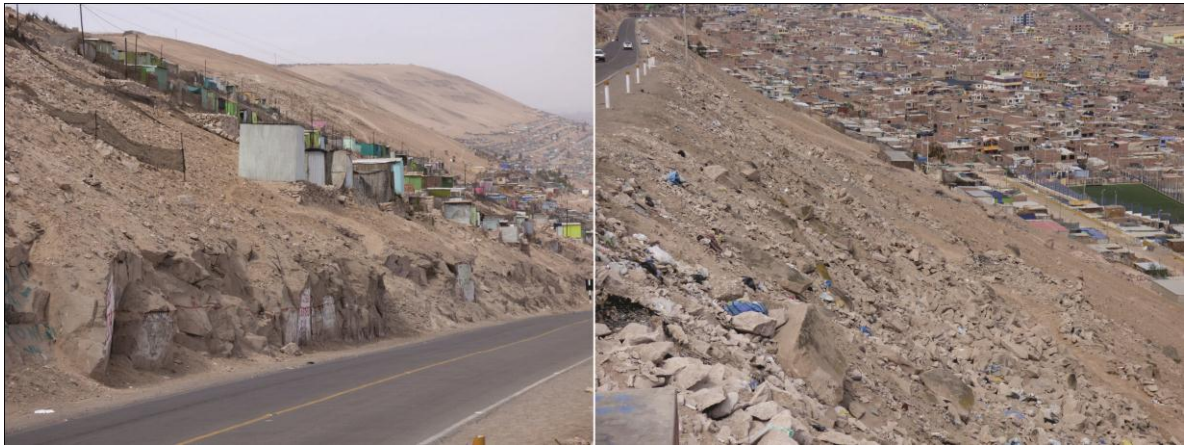
Foto 5. Caída de rocas en la Asociación de Vivienda Villa Intiorko, en caso de sismos las pircas y los bloques suspendidos en las laderas del cerro Intiorko pueden ceder y afectar a las viviendas que se encuentran en la parte inferior.
