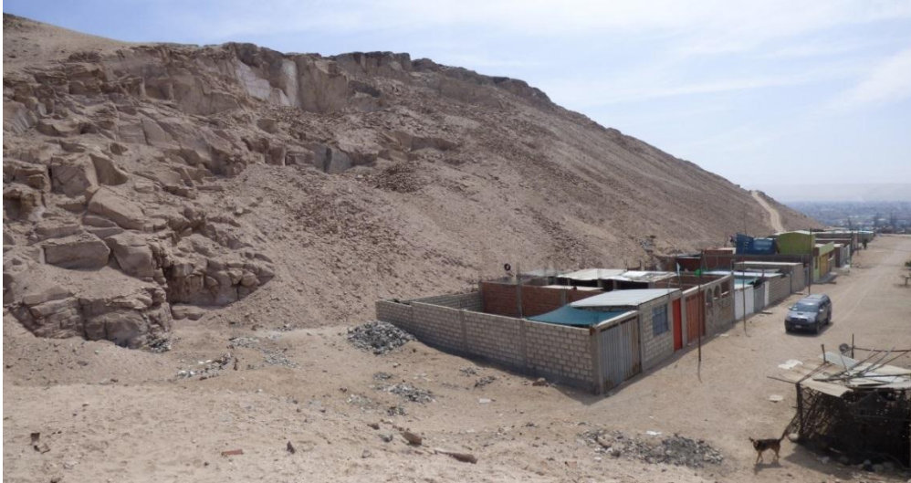
Foto 10. Caída de rocas y derrumbes en forma de canchales de detritos arriba de viviendas de la Asociación de Vivienda La Florida, en la margen izquierda de la quebrada del Diablo.
