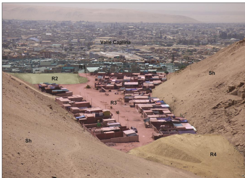
Foto 3. Asociación de Vivienda La Florida, donde se diferenciaron hasta cuatro niveles de rellenos (R1, R2, R3 y R4). Las viviendas fueron edificadas sobre estos depósitos y en pleno cauce de la quebrada Del Diablo; sobre el R4 se encuentra el antiguo botadero municipal de la ciudad de Tacna, en ambos márgenes de la quebrada se aprecia las tobas de la Formación Huaylillas (Sh).
