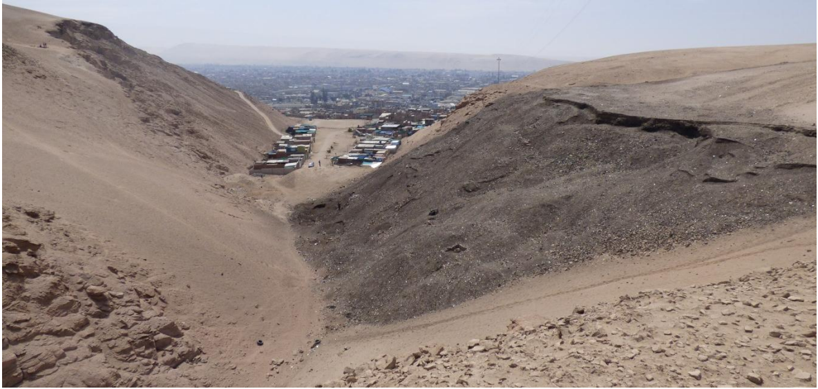
Foto 6. Vista Panorámica de la quebrada Del Diablo, la Asociación de Vivienda La Florida, se encuentra sobre el cauce, en la margen izquierda presenta derrumbes y en la margen derecha, el antiguo botadero municipal de la ciudad de Tacna.
