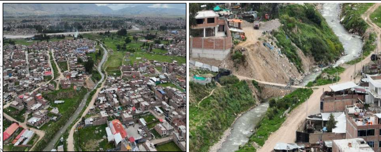
Punto crítico N° 24. Sector: Puente, exposición por erosión ante la falta de protección física (Defensa ribereña)
