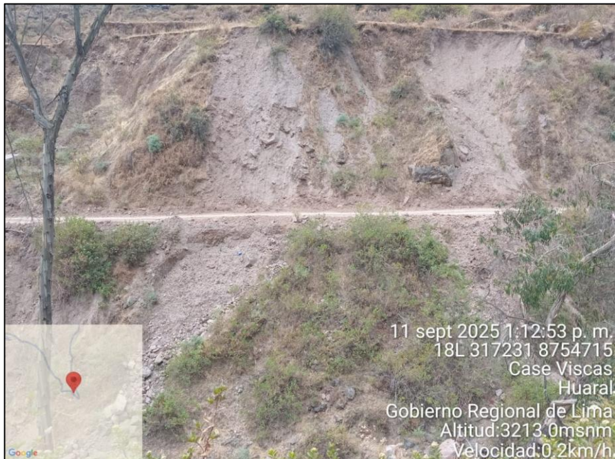
Figura 31. Vista panorámica de la zona crítica - Quebrada Shishin.
