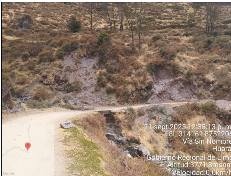
Figura 27. Vista panorámica de la zona crítica - Quebrada Chuncurmayo.
