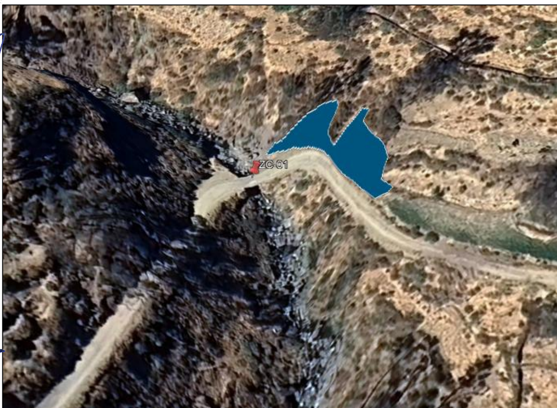
Figura 26. Zona crítica por deslizamiento en la Quebrada Chuncurmayo.
