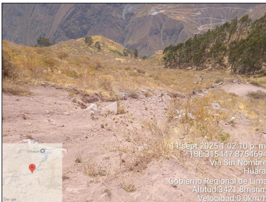
Figura 29. Vista panorámica de la zona crítica - Sector Cochán.
