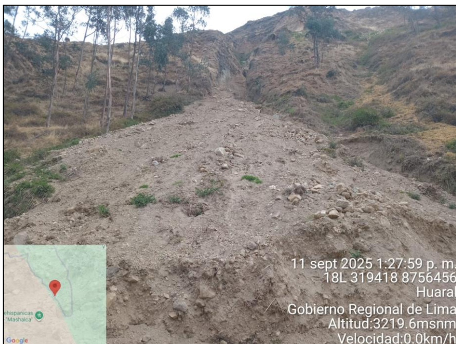
Figura 33. Vista panorámica de la zona crítica - Quebrada Chilamayo.
