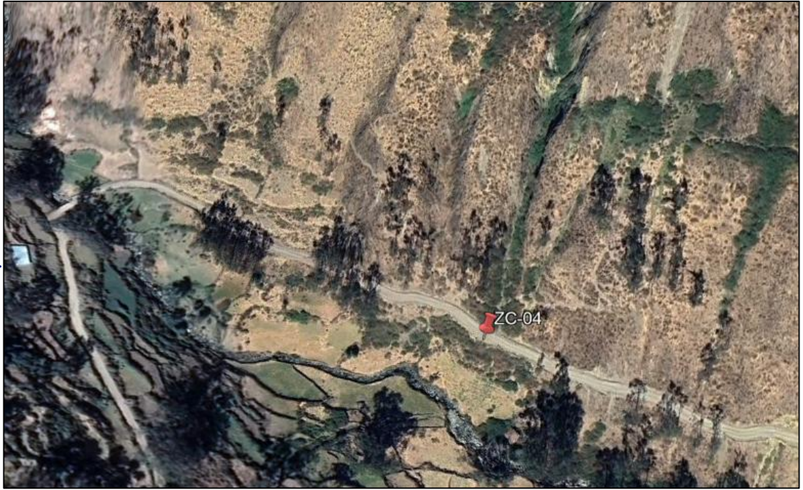
Figura 32. Zona crítica por flujo de detritos (huaico) en la Quebrada Chilamayo.
