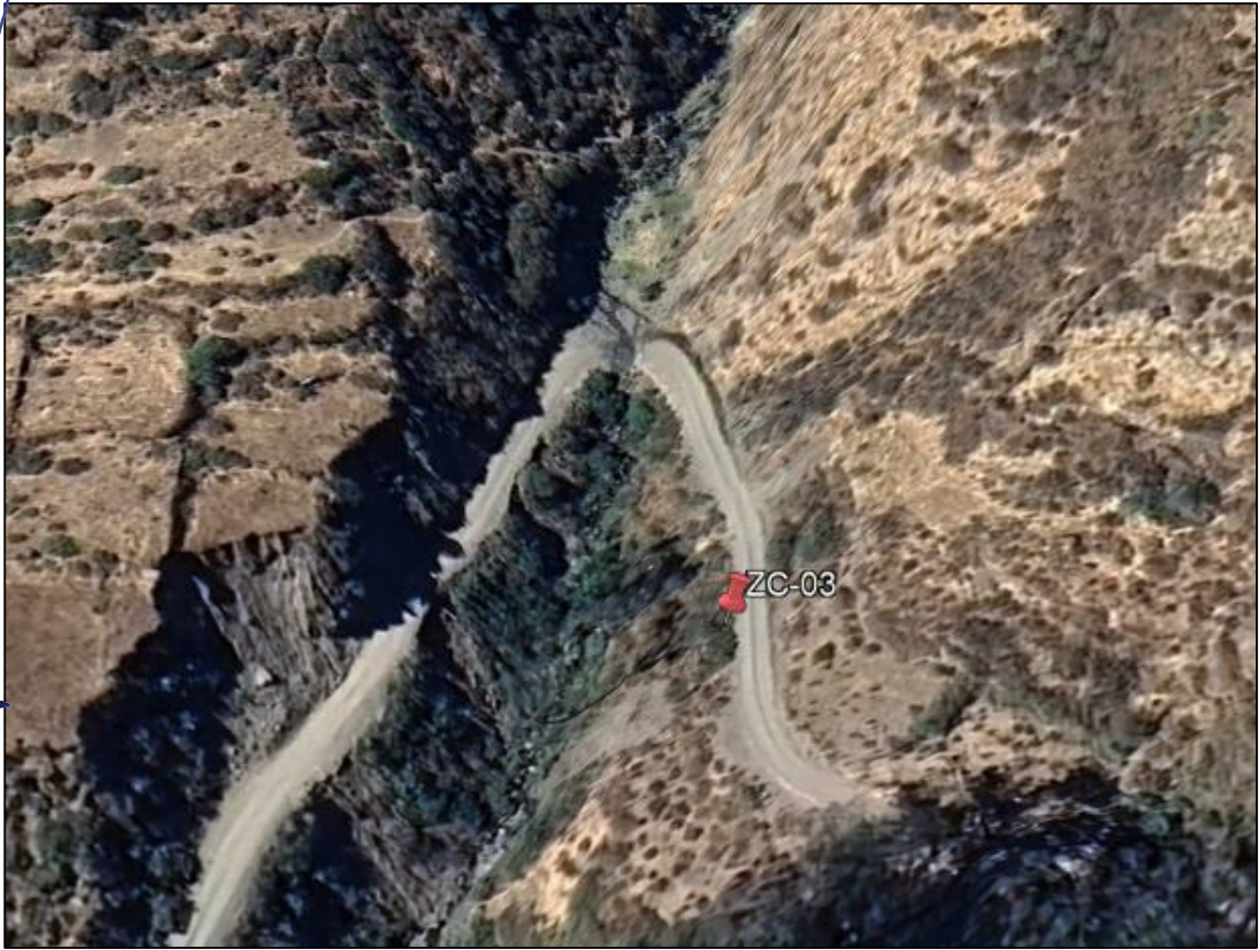
Figura 30. Zona crítica por flujo de detritos (huaico) en la Quebrada Shishin.
