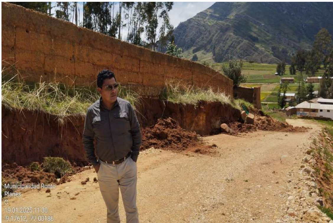
Recorriendo los caminos para verificar los deslizamientos en las vías
