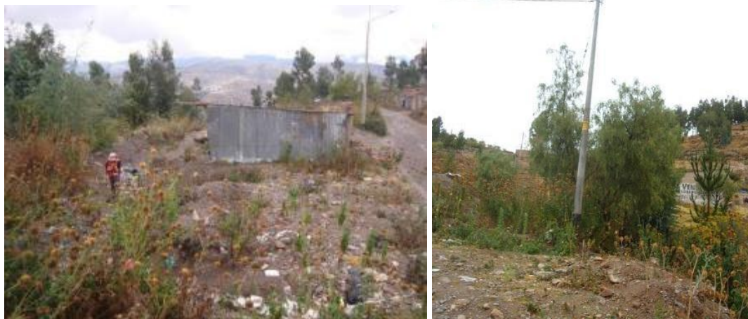
Foto 27. Vista de vivienda y poste próximo a la quebrada en el sector San Juan De La Picota.
