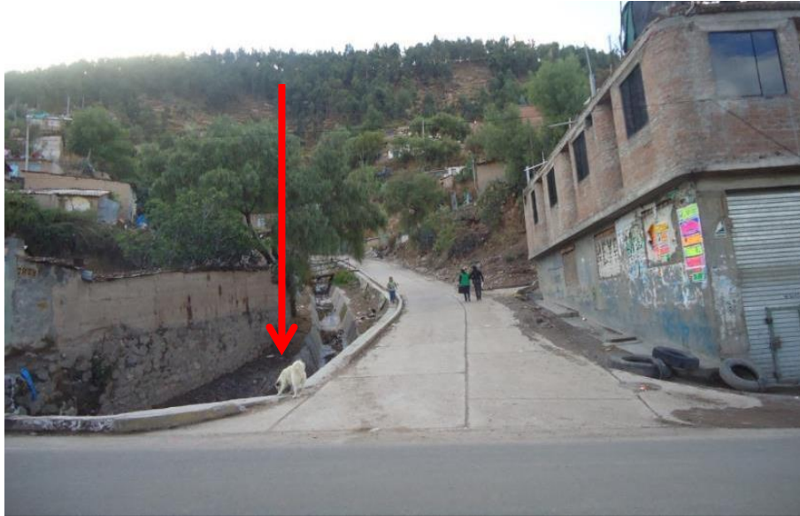
Foto 33. Canalización de la quebrada, en el sector Pistotambo.
