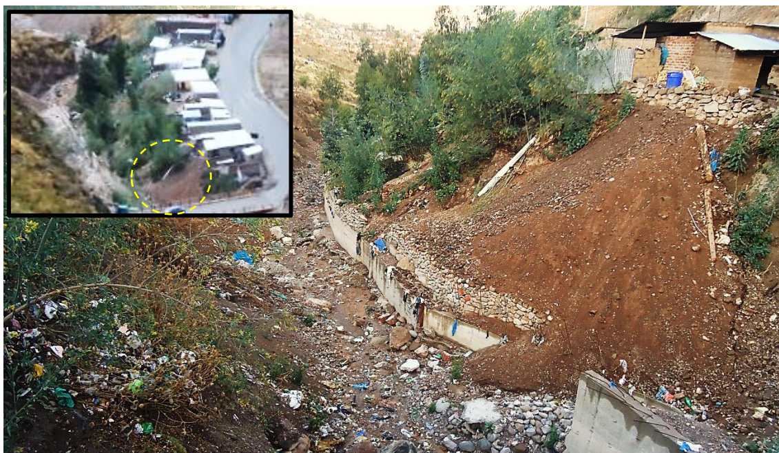
Foto 36. Vista de la quebrada junto al puente Mollopata.
