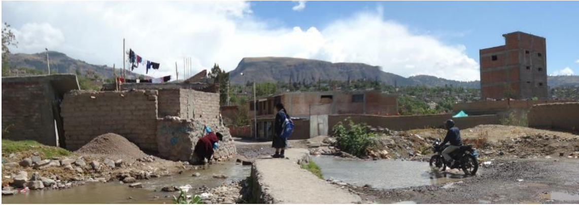
Foto 16. Estrechamiento de la quebrada Chaquihuayco en el distrito San Juan Bautista (UTM: 585430 E 8542930 N).
