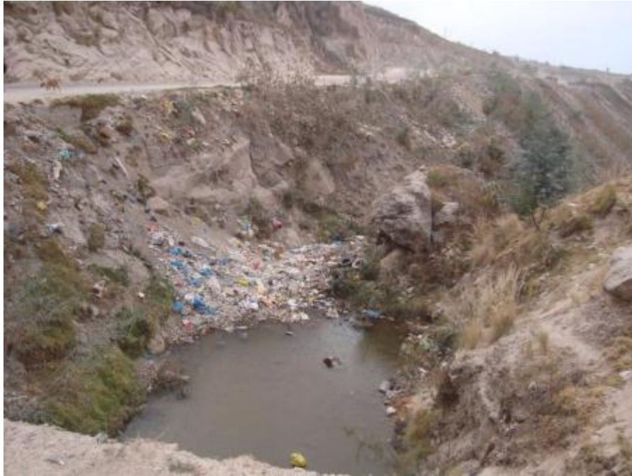
Foto 10. Vista aguas arriba del puente Yanama. La ocupación de las laderas de la quebrada por parte de la población con árboles y cultivos variados, así como el arrojado de desmonte, han ocasionado el estrechamiento de esta. En este sector el suelo está compuesto principalmente por arenas, gravas y limos poco consolidados con bloques de roca.
