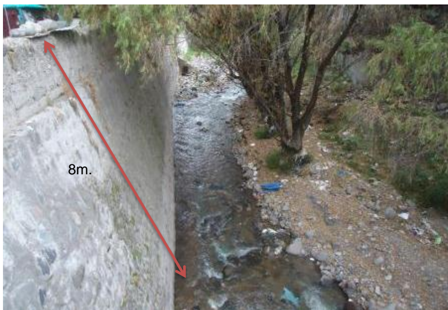
Foto 22. Muro de contención del puente San Sebastián.
