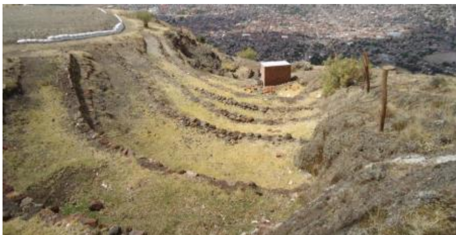
Foto 41. Banqueteo realizado en una de las quebradas del cerro La Picota.
