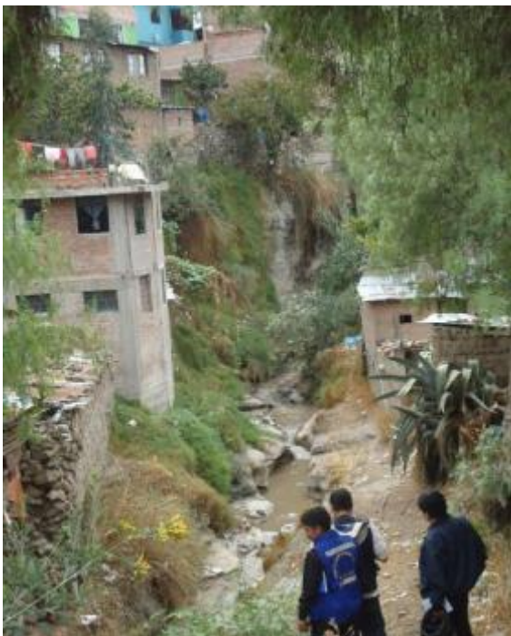
Foto 20. Vista aguas abajo del puente Apurímac, se observan viviendas ubicadas en el cauce de la quebrada Chaquihuayco. No tienen medidas estructurales para proteger sus predios frente a futuras avenidas o movimientos en masa.
