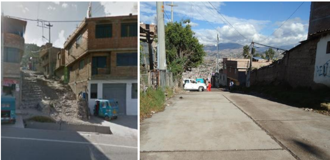
Foto 32. Sector Pueblo Libre, vía Los Libertadores, donde la quebrada ha sido completamente urbanizada y su cauce se ha convertido en vía pública, a) aguas arriba, b) aguas abajo.
