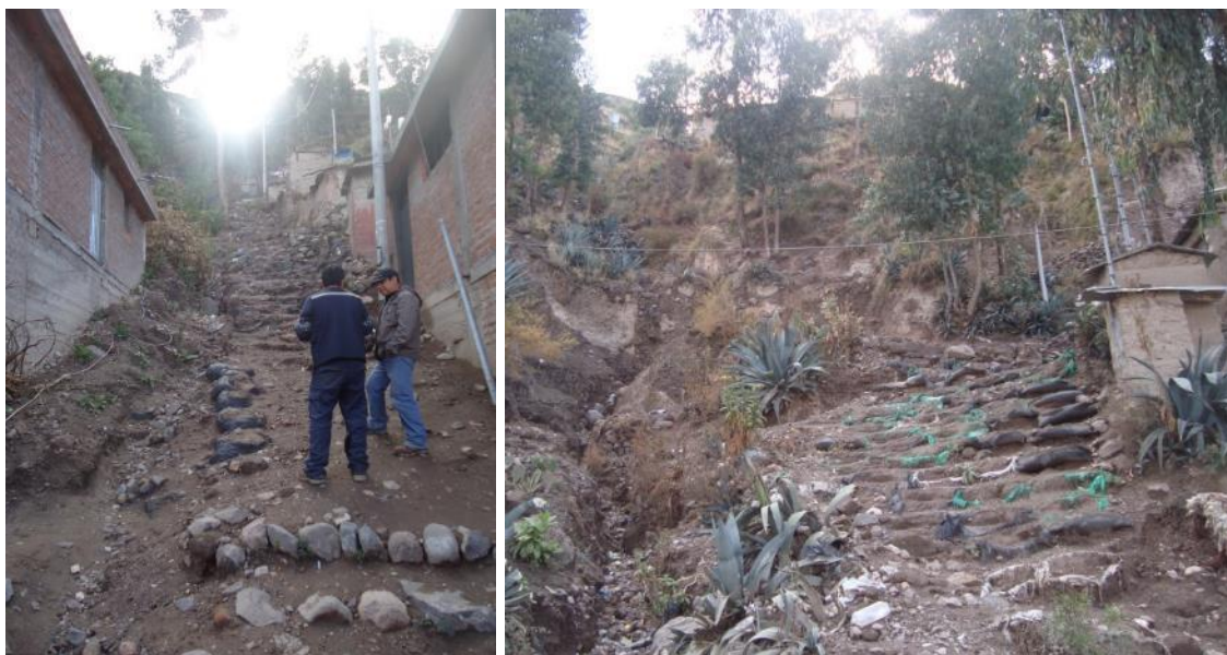
Foto 28. Vistas del sector Mi Perú donde se han colocado sacos de arena para proteger estas de la erosión.
