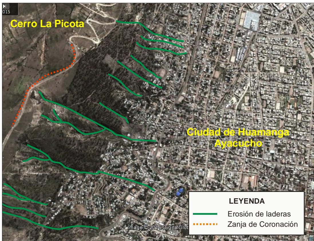
Figura 07. Erosión de laderas en el cerro La Picota, se observa que la zona urbana a cubierto la parte baja de la mayoría de las quebradas.
