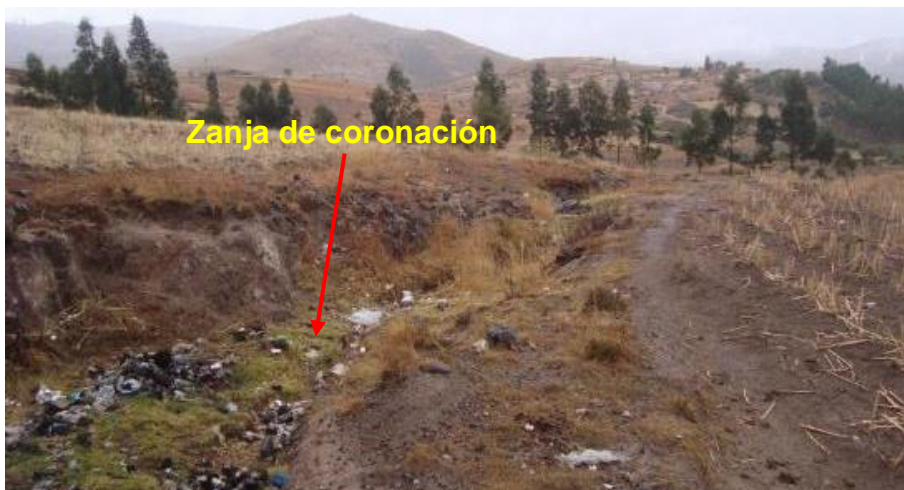
Foto 26. Vista de la zanja de coronación realizada sobre el cerro La Picota.
