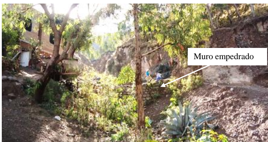
Foto 40. Muro empedrado de 50 cm de ancho colocado perpendicular a la quebrada para retener material arrastrado por las lluvias en el cerro La Picota.
