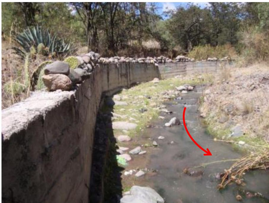
Foto 13. Vista de muros de concreto de 1,5 m de alto protegiendo solo a la margen derecha de la quebrada con una longitud de 50 m; sus bases están expuestas en algunos tramos debido a la erosión.
