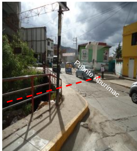
Foto 19. Construcción de grifo no permite la vista de la quebrada.
