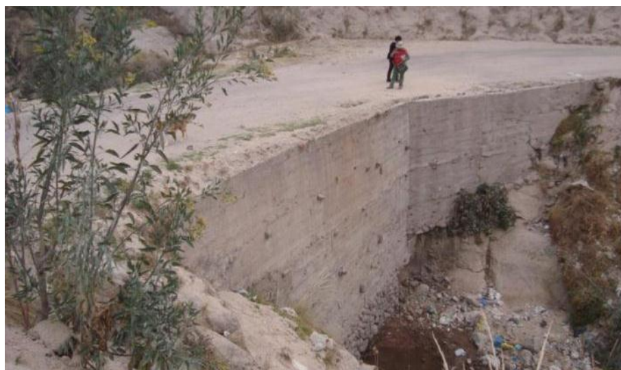
Foto 11. Vista aguas abajo del puente Yanama, mostrando un caudal de agua muy limitado.
