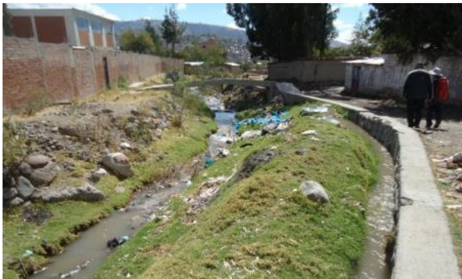
Foto 15. Vista del ingreso al colegio Fe y Alegría, mostrando cúmulos de basura y desmorte hacia la quebrada.
