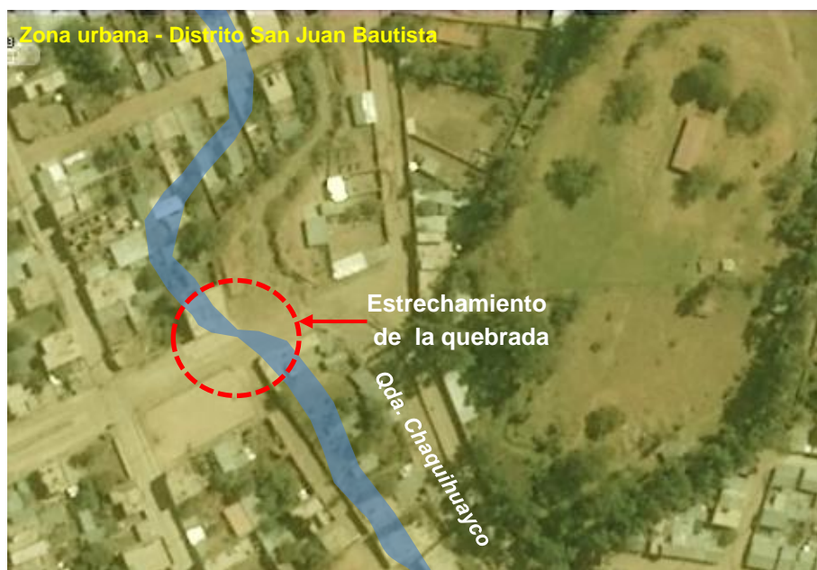
Figura 4. Imagen satelital donde se aprecia el estrechamiento de la quebrada por la construcción de viviendas dentro del lecho de la misma. No presenta obra de drenaje adecuada (puente o badén) para el tránsito que podría originar se inunden las viviendas aledañas en épocas de crecidas.
