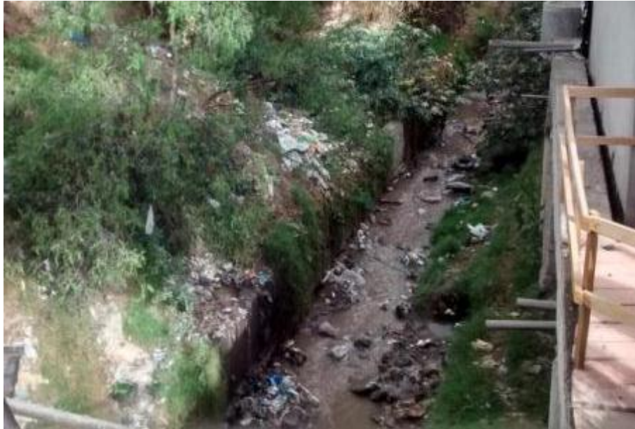
Foto 3. Vista de conexiones de desagüe que vierten hacia la quebrada Chaquihuayco.
