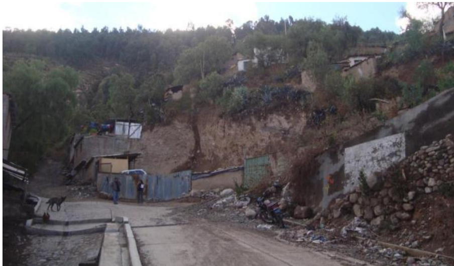
Foto 34. Vista del extremo superior de la canalización de la quebrada en el sector Pistotambo.
