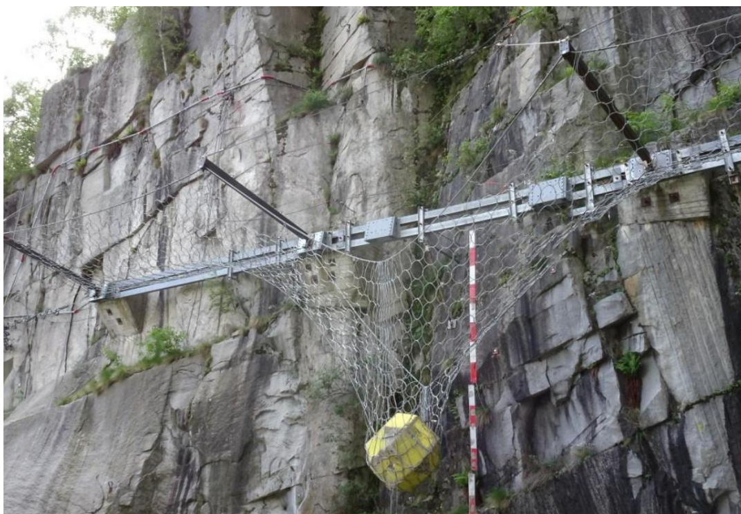
Ilustración 12 Modelo de Barreras Dinámicas
