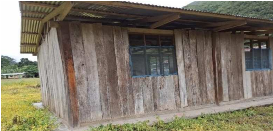
Fotografía N° 1. Vivienda con material de construcción tipo madera y calamina estos son los predomina del distrito
