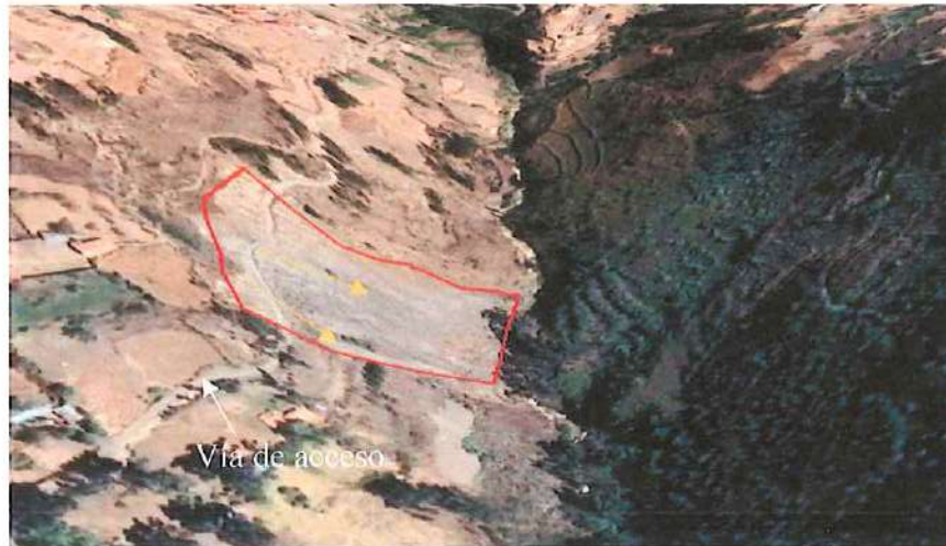
Grafica 29 Deslizamiento en Shushumia
