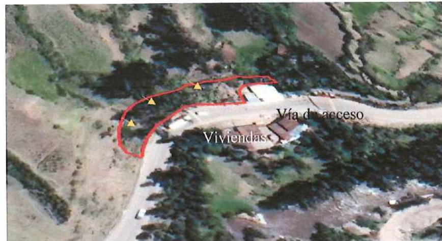
Grafica 32 Deslizamiento Sur de baños
