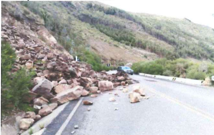
Jircahuayi 2 vista del deslizamiento
