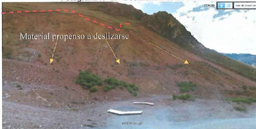
Fotografía N° 9. Deslizamiento en Tambillo
