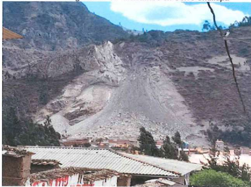
Fotografía N° 3. Derrumbe en Cerro Shállapa
