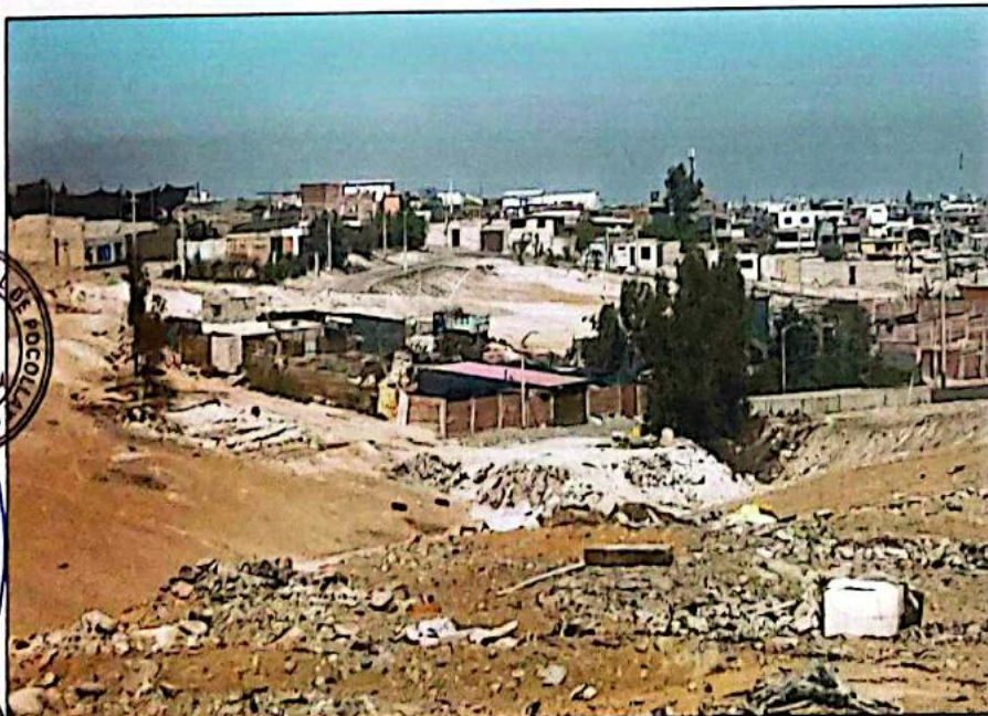
Viviendas ubicadas en zona de peligro muy alto por sismo
