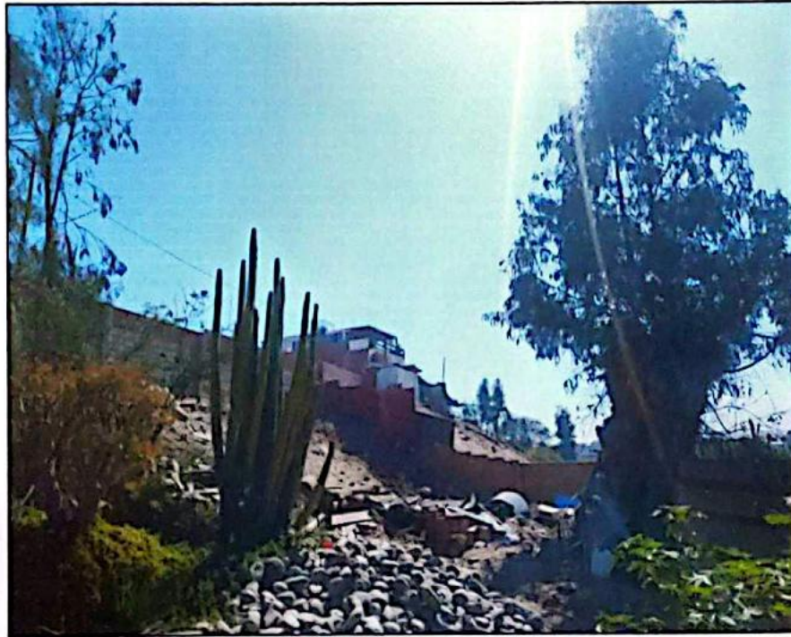
Vivienda ubicada en zona de deslizamiento
