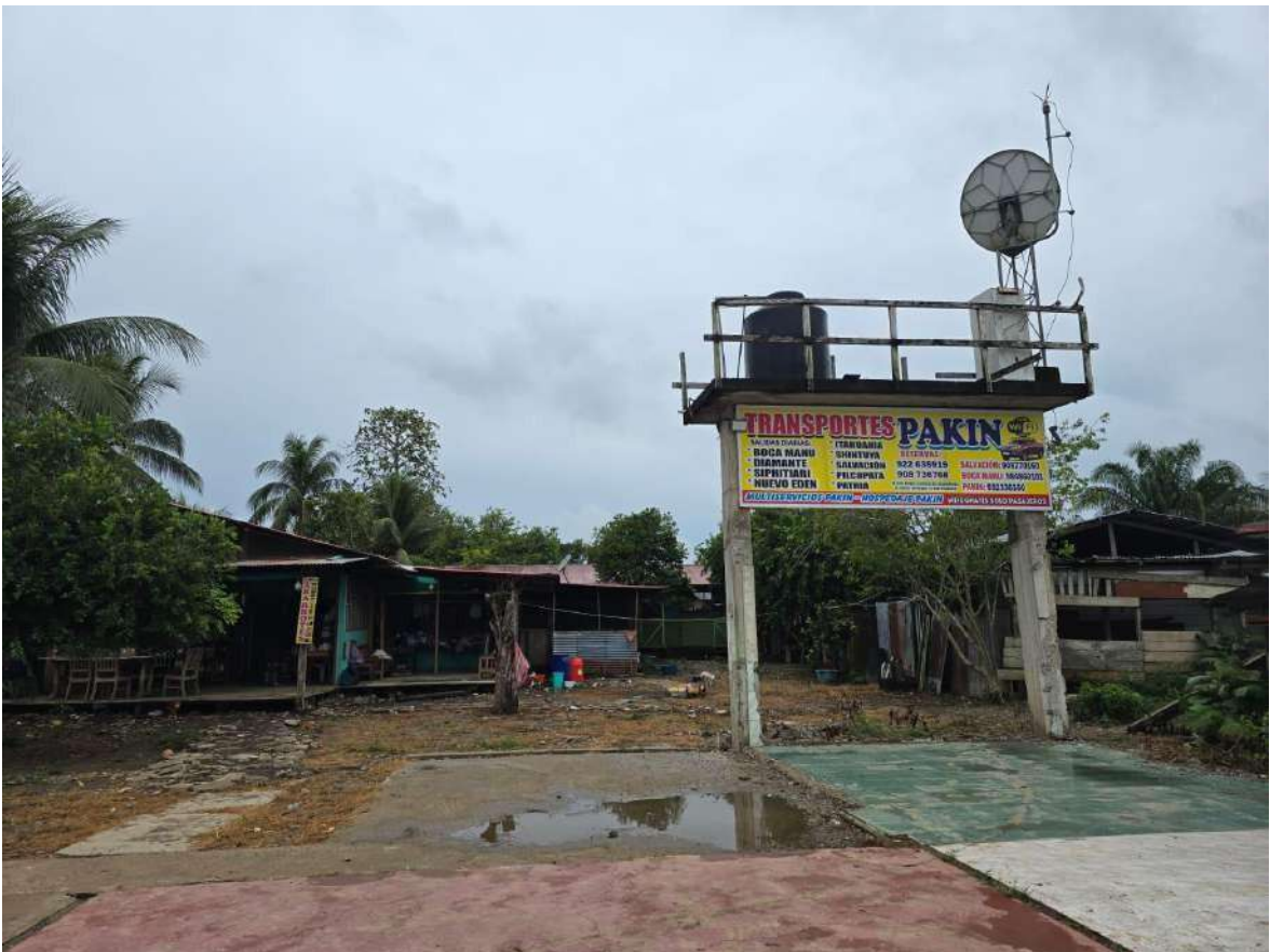
Desborde de río en el centro poblado Boca Manu, Puerto Azul.
