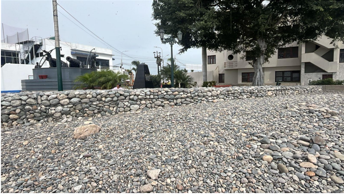
FIGURA 23: GAVIONES EN PLAZA TORRE DE LA MERCED
