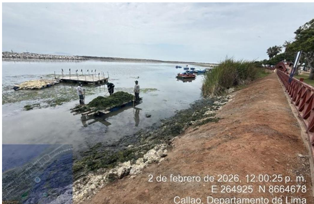
FIGURA 27: ACTIVIDAD DE EXTRACCIÓN DE ALGAS MEDIANTE USO DE PLATAFORMAS FLOTANTES MÓVILES
