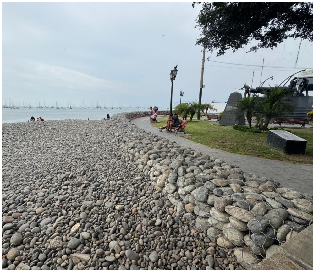
FIGURA 22: GAVIONES EN PLAZA TORRE DE LA MERCED
