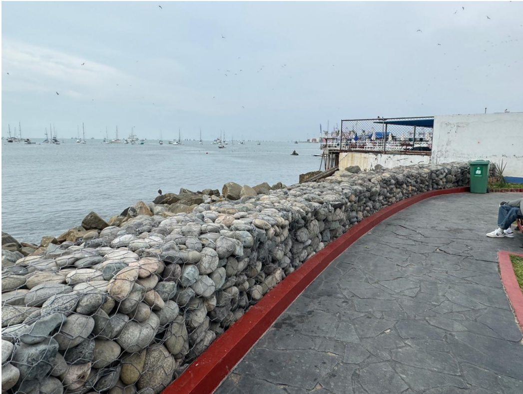
FIGURA 21: GAVIONES EN PLAZA TORRE DE LA MERCED
