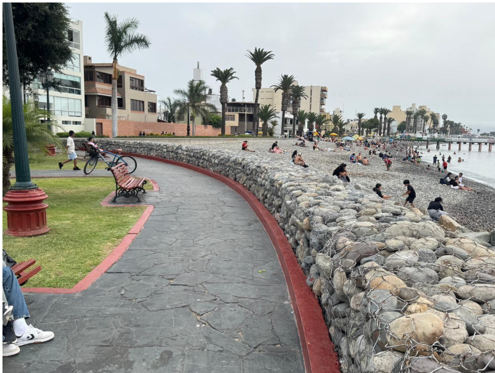
FIGURA 20: GAVIONES EN PLAZA TORRE DE LA MERCED
