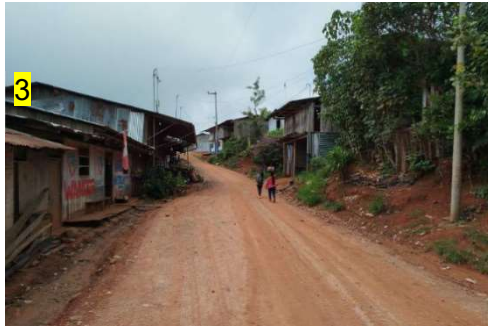
Figura N°10: Vista del sistema de drenaje existente en Jr. Alto Andino Cdra. 02 y Jr. Lamas Cdra. 01
