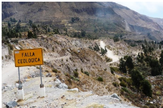
Figura 4: Deslizamientos y hundimientos que afectan el pueblo de Maca y la carretera Maca-Cabanaconde (Mariño y Macedo, 2015)
