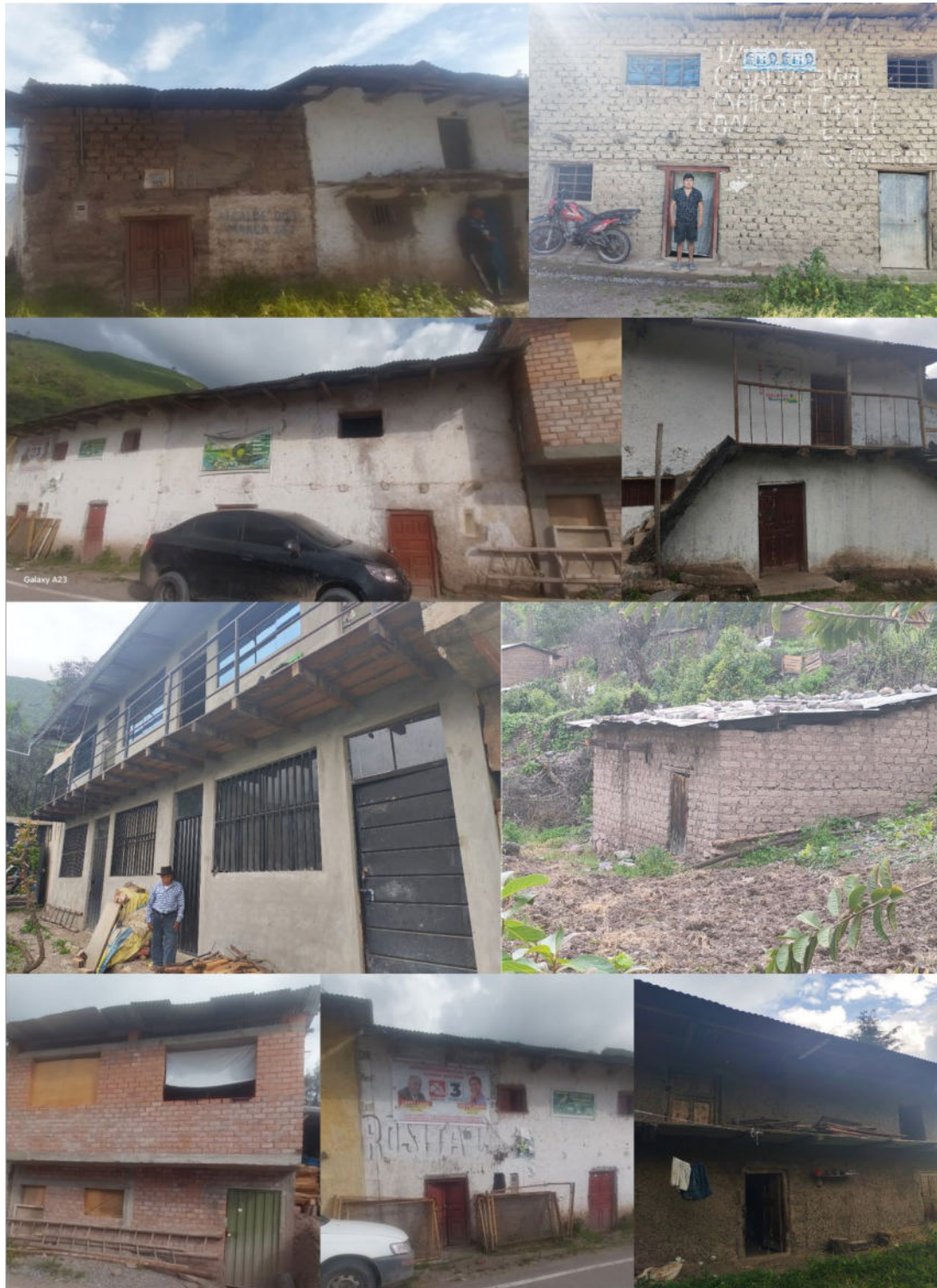
Foto 4: Edificaciones con estado de conservación bueno, regular y malo.
