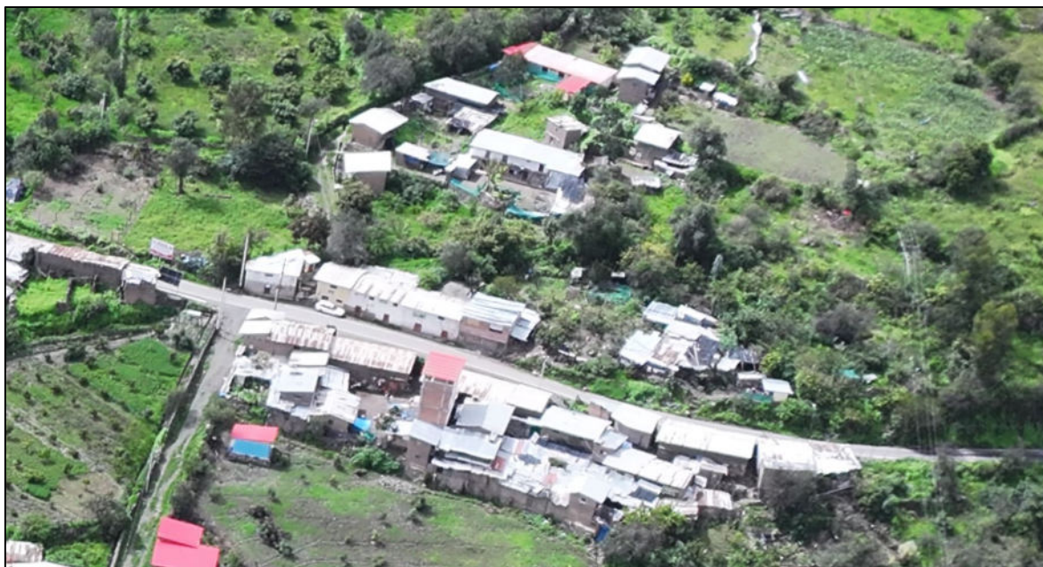
Foto 3: Vista de las viviendas construidas en adobe.
