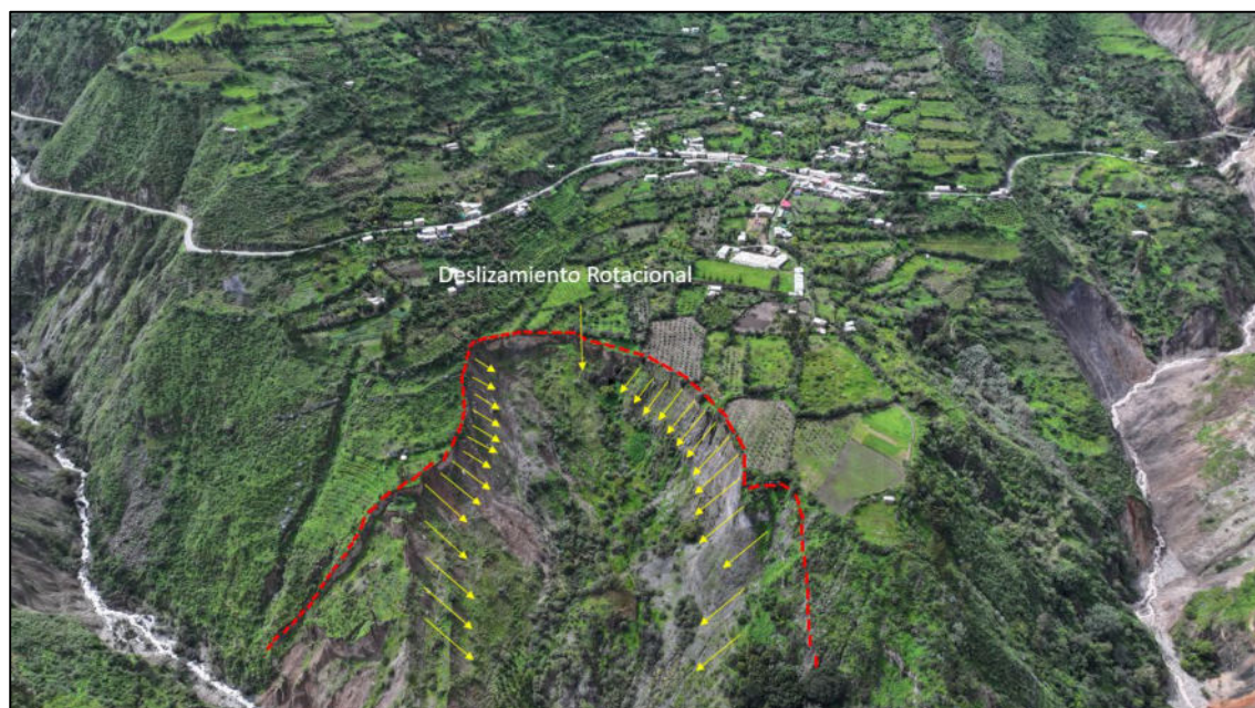
Foto 5: Deslizamiento rotacional en depósito coluvio-aluvial..
