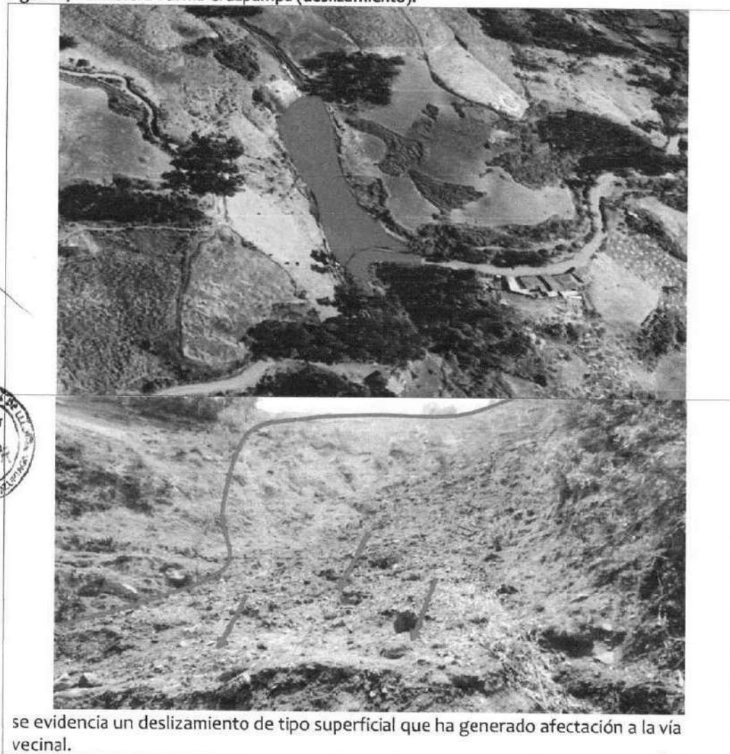
Figura 27. Carretera Yurma-Cruzpampa (deslizamiento).
