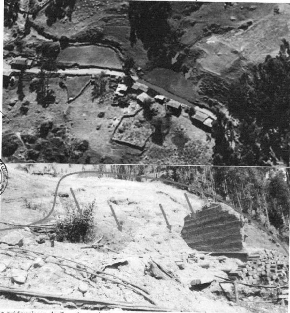
Figura 32. Carretera Salapampa-Ingenio (deslizamiento rotacional).
