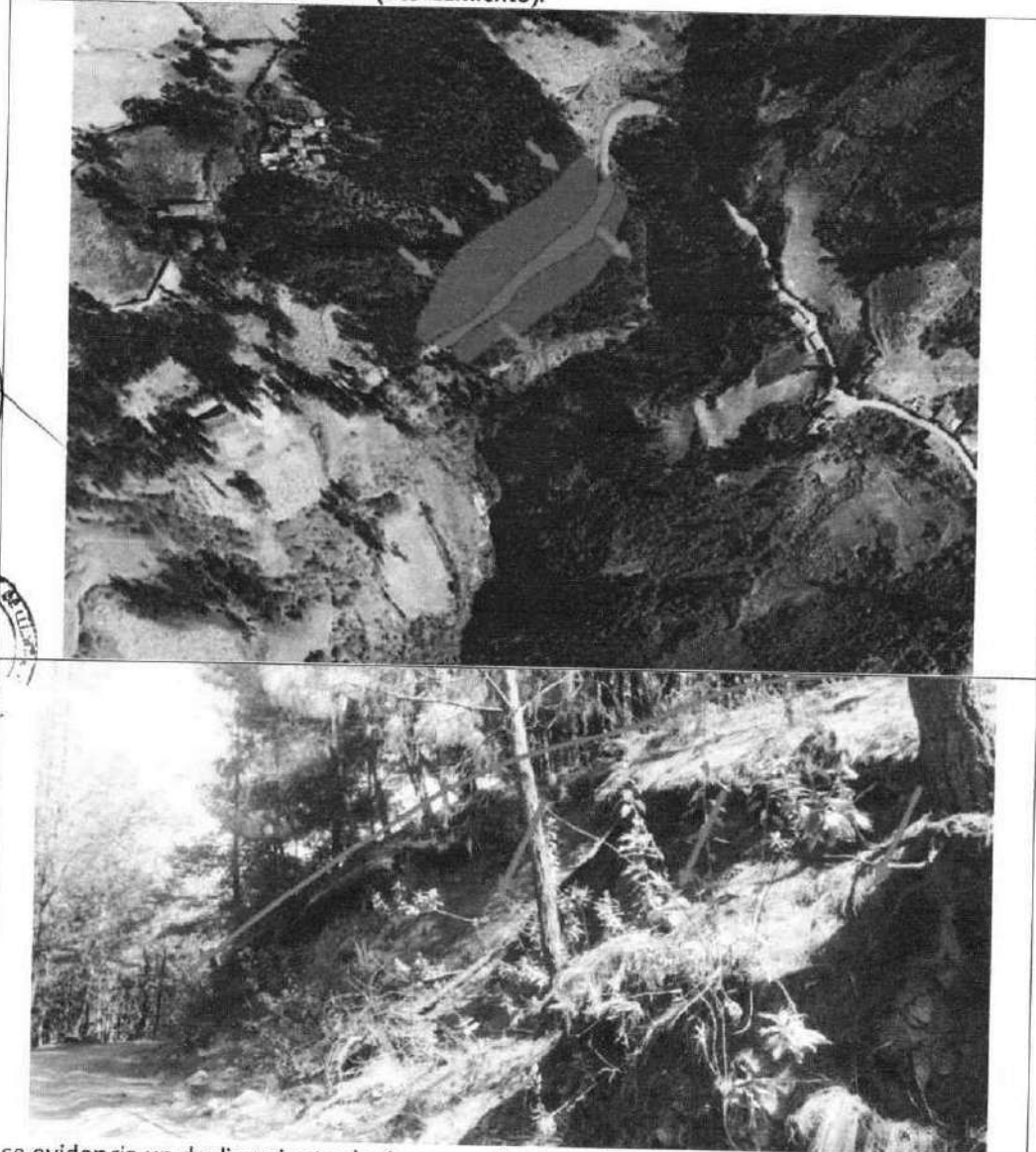
Figura 30. Carretera Shoca-Culluna (deslizamiento).
