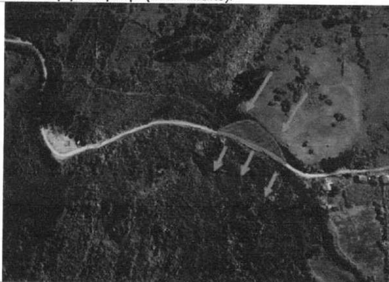
Figura 25. Carretera Rirpaj-Huaripampa (deslizamiento).
