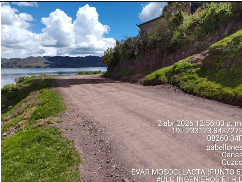
Foto 22 Vista del estado bueno de la carretera en la progresiva 1+000
