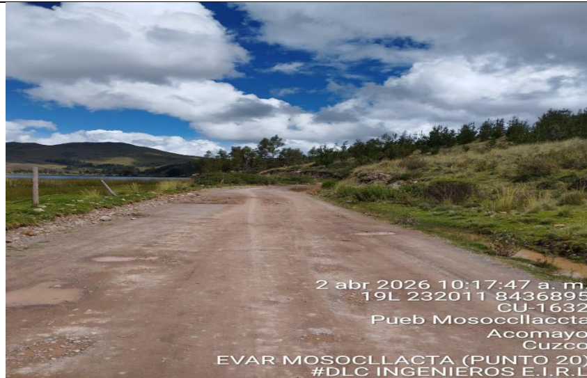
Foto 27 Vista panorámica del ancho de la carretera en la progresiva 3+100
