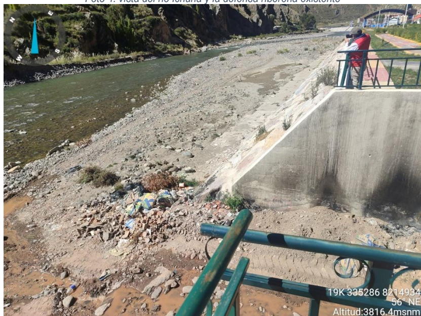
Foto 4: vista del rio Ichuñá y la defensa ribereña existente
