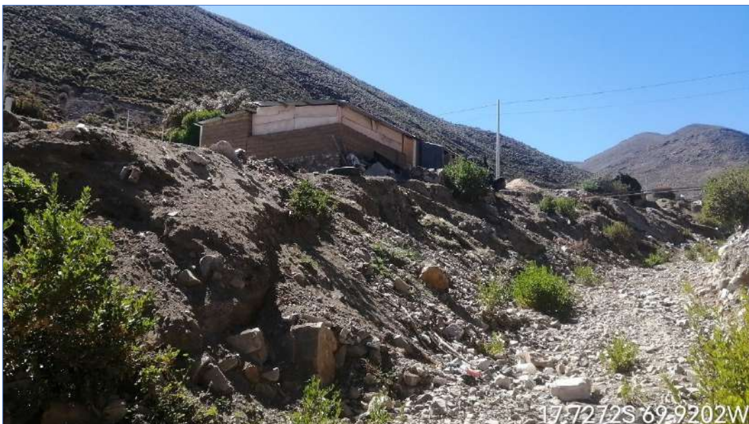
Fotografía 5 – Vista de cauce de Qda Ataspaca, se observan predios colindantes
