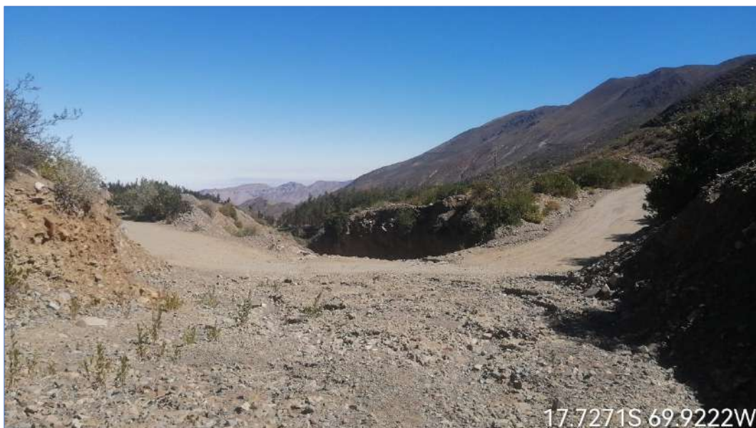
Fotografía 12 – Vista de cauce de Qda Ataspaca, se observa TA-601, vía principal de acceso que cruza la quebrada
