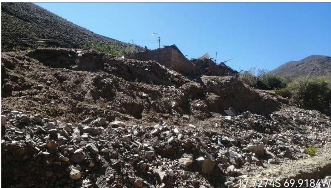
Fotografía 9 – Vista de cauce de Qda Ataspaca, se observan predios colindantes
