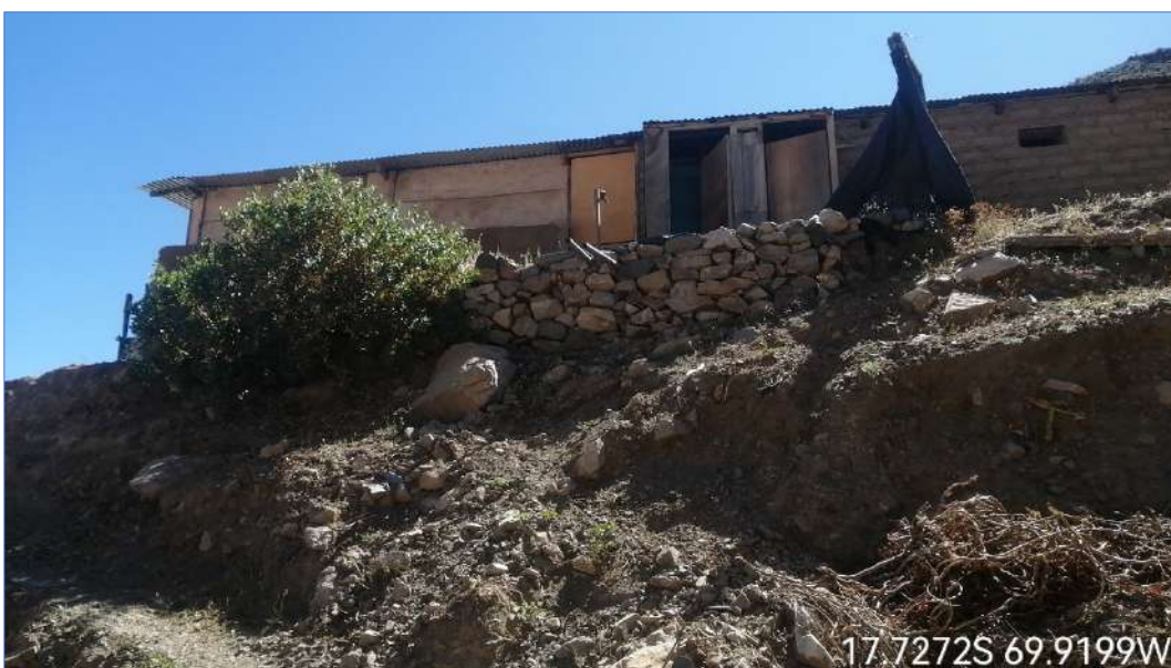
Fotografía 6 – Vista de cauce de Qda Ataspaca, se observan predios colindantes
