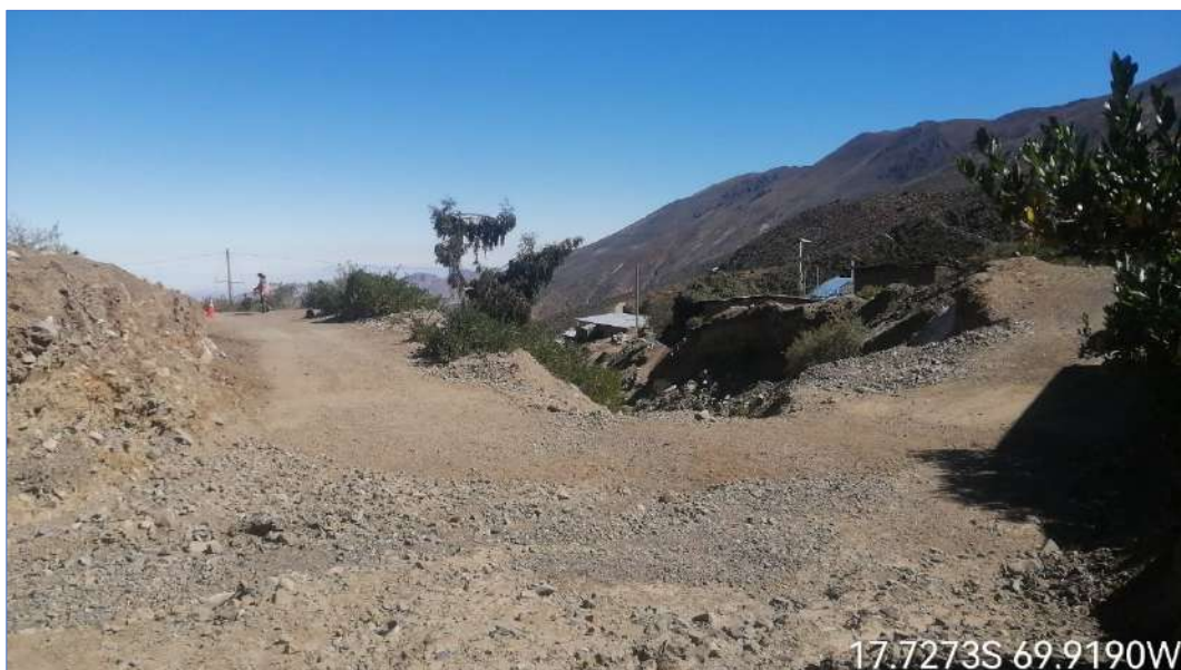
Fotografía 13 – Vista de cauce de Qda Ataspaca, se observa vía intermedia que cruza la Qda Ataspaca en dirección a cancha deportiva
