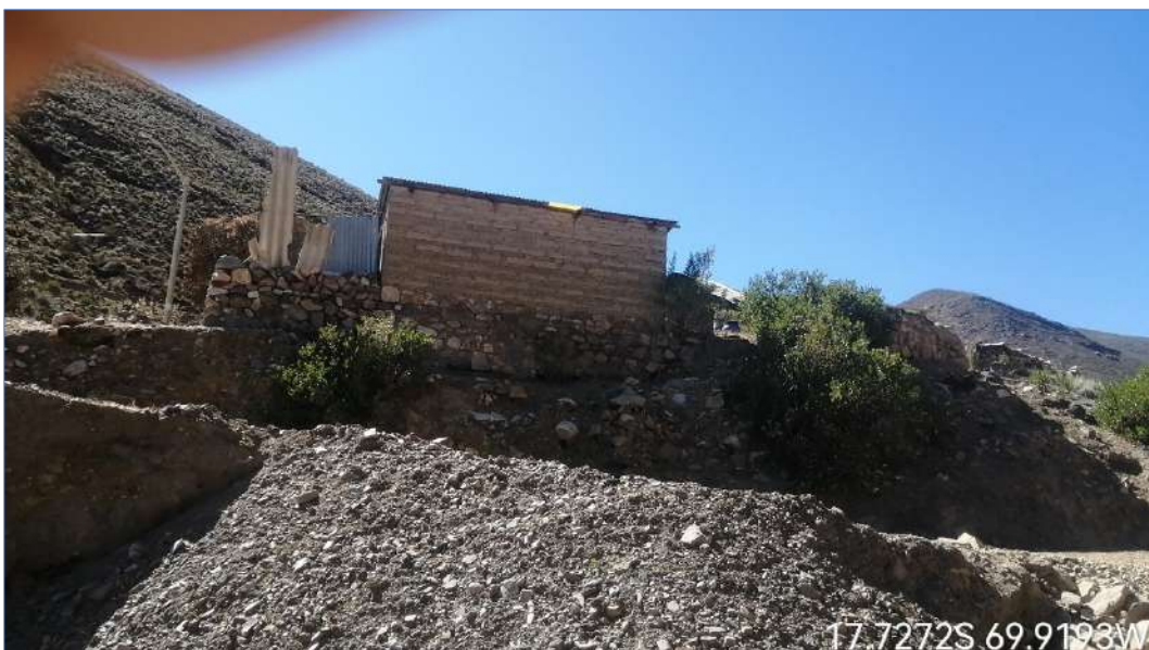
Fotografía 8 – Vista de cauce de Qda Ataspaca, se observan predios colindantes sobre pircas de piedra
