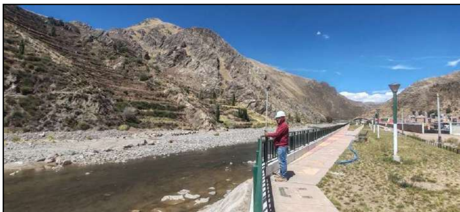
Figura N° 2.7-1 Defensa ribereña de protección
