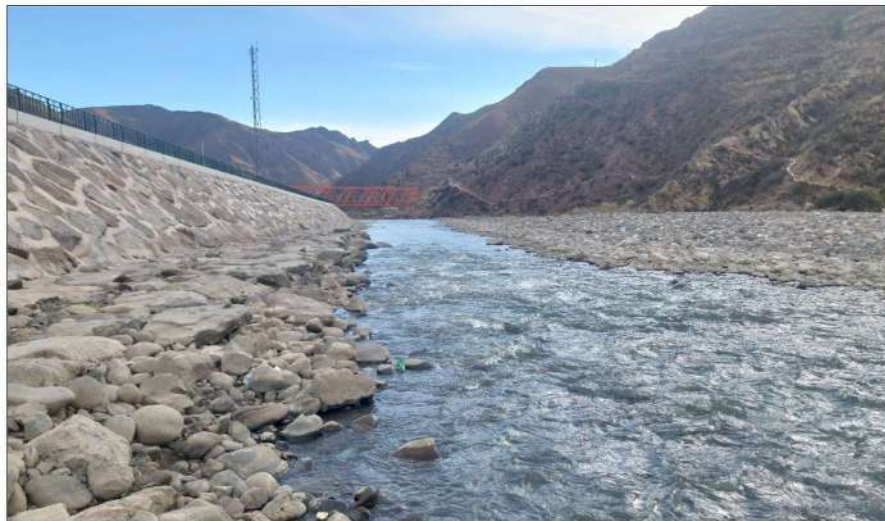
Figura N° 2.7-2 Tramo medio del río Ichuña con defensa ribereña en margen izquierda
