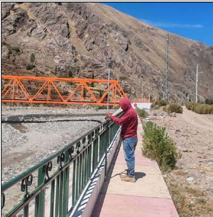
Imagen 14 descripción Se muestra el levantamiento información "del sardinel del malecón, las barandas, veredas y el terreno natural"
