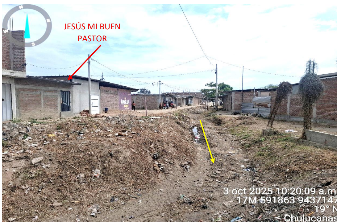
FIGURA 15. DREN AUXILIAR PROVENIENTE DE CALLE 06 (EXTREMO ESTE DEL ÁREA DE ESTUDIO)
