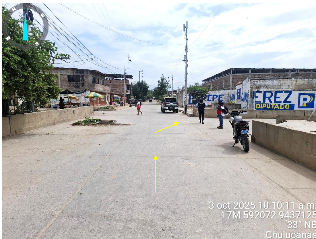
FIGURA 12. AGUAS PLUVIALES PROVENIENTES DEL MERCADO MUNICIPAL A TRAVES DEL JR LAMBAYEQUE, CONTINÚA POR LA CALLE MARÍA AUXILIADORA (ALCANZA ALTITUDES DE 0.90 m EN LAS VIVIENDAS ALEDAÑAS) E INGRESA HACIA DREN SITUADO EN LA CALLE LIBERTAD
