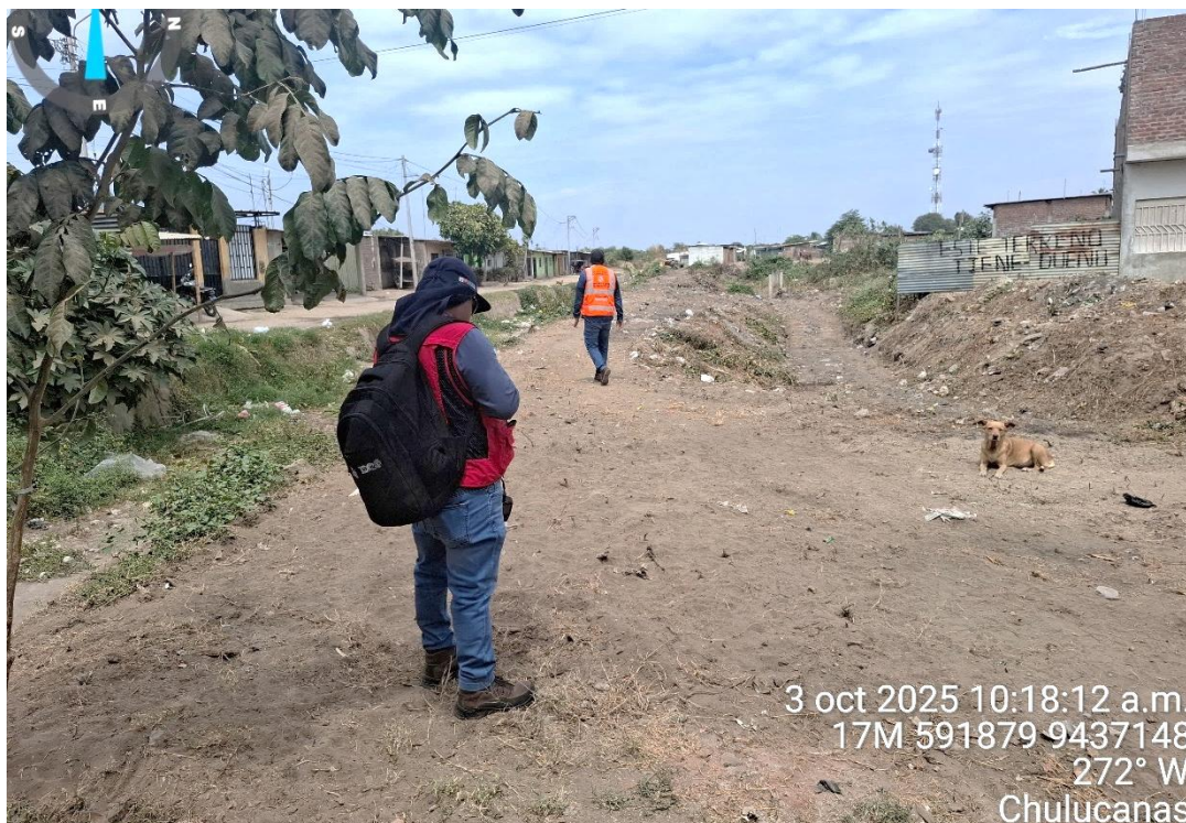
FIGURA 14. VISTA DE DREN LAMBAYEQUE EN LA ZONA IZQUIERDA Y DREN AUXILIAR PARA DRENAN AGUAS DE CALLE 06 EN LA PARTE POSTERIOR DE ÁREA DE ESTUDIO
