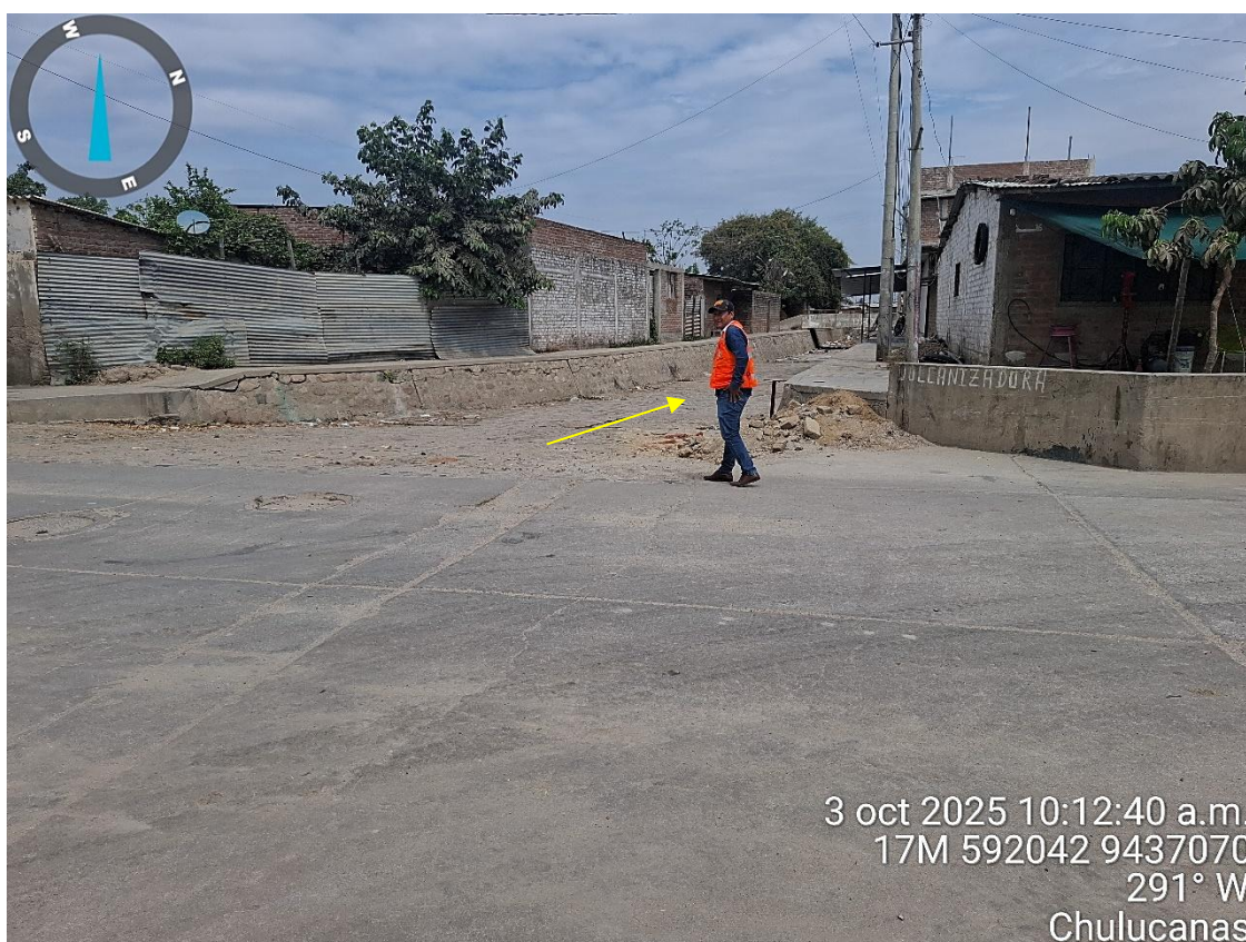
FIGURA 3. CAUCE ALUVIAL (FLECHA AMARILLA) IDENTIFICADO EN LA CALLE LIBERTAD QUE DRENA LAS AGUAS DESDE EL JR. LIBERTAD (INMEDIACIONES DE MERCADO MUNICIPAL), A TRAVÉS DE CANAL DE MAMPOSTERÍA DE 1.20 M DE ALTURA Y 2.10 M DE ANCHO, HASTA EL ÁREA DE ESTUDIO
