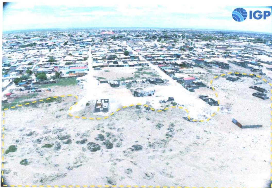
Figura 6.- Unidad geomorfológica duna (polígono amarillo), ubicada en las inmediaciones del A.H. Virgen del Carmen, constituida por depósitos eólicos de arena fina y caracterizada por presentar cobertura vegetal dispersa, la cual contribuye a la estabilización parcial de la superficie arenosa.
