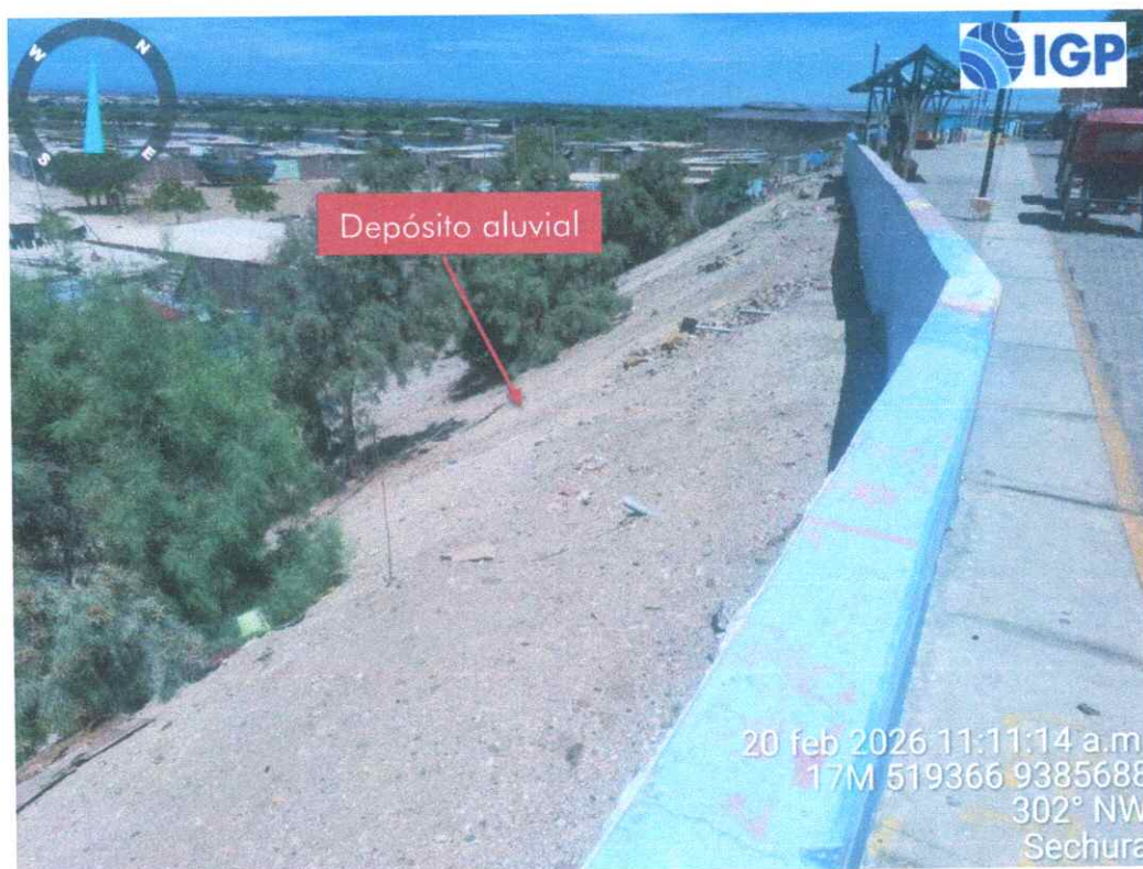
Figura 16.- Depósito aluvial compuesto predominantemente por arenas limosas con gravas aisladas, que conforman la ladera de la terraza aluvial alta, sobre el cual se ha asentado el área urbana de la ciudad de Sechura.
