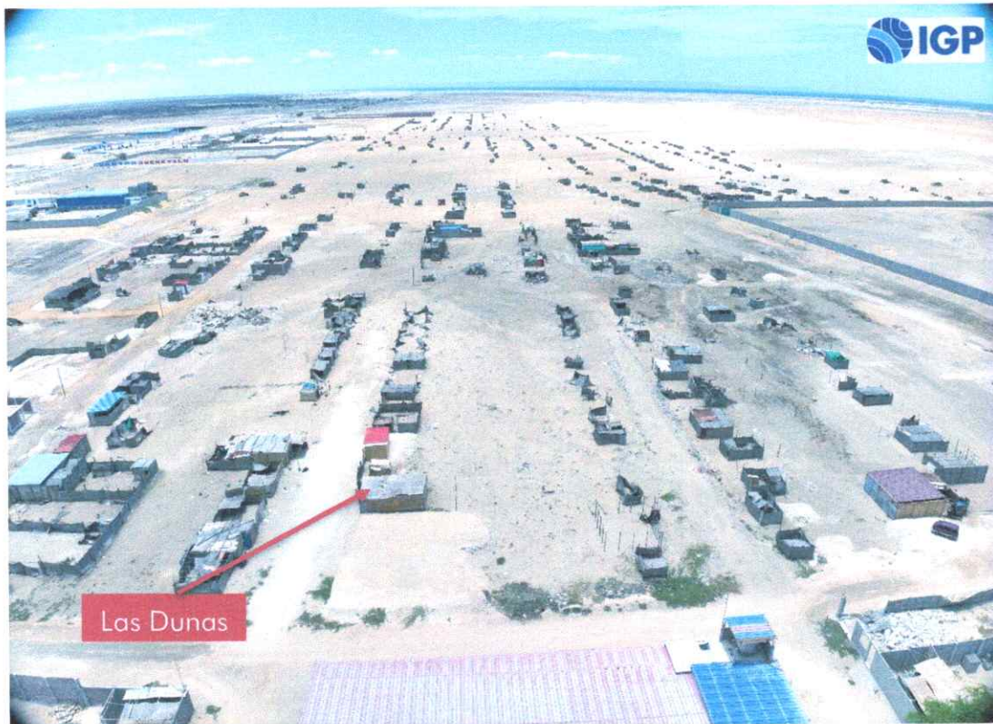
Figura 25.- Sector Las Dunas susceptible a inundaciones pluviales debido a que se asienta sobre zona de depresión
