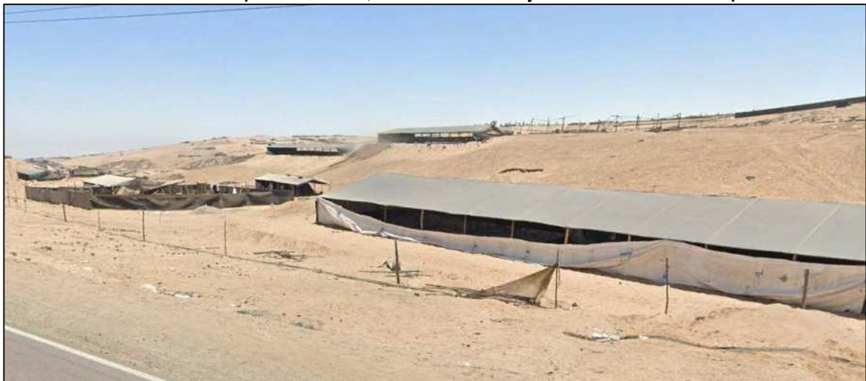
Gráfico N° 24. Vista del área de intervención del proyecto, ubicada fuera de la faja marginal de la quebrada del Diablo. Se observa terreno de pendiente suave, sin evidencias de flujo de detritos ni afectación por escorrentía
