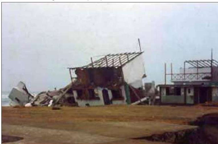
Figura 7. Colapso por socavamiento – Camaná
