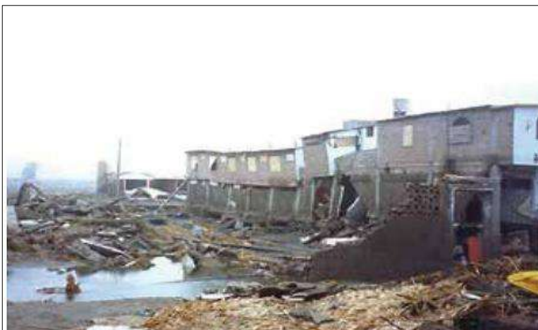
Figura 8. Inundación y colapso de las viviendas por tsunami – Camaná
