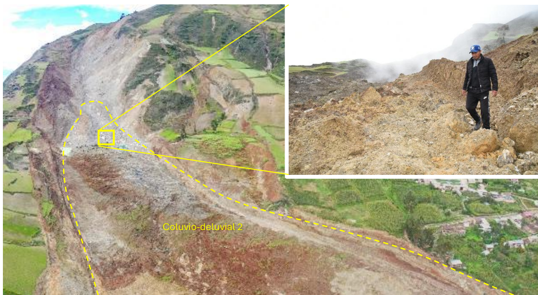
Figura 9. Depósito coluvio-deluvial 2, asociado al deslizamiento-flujo activo de Sisco.
