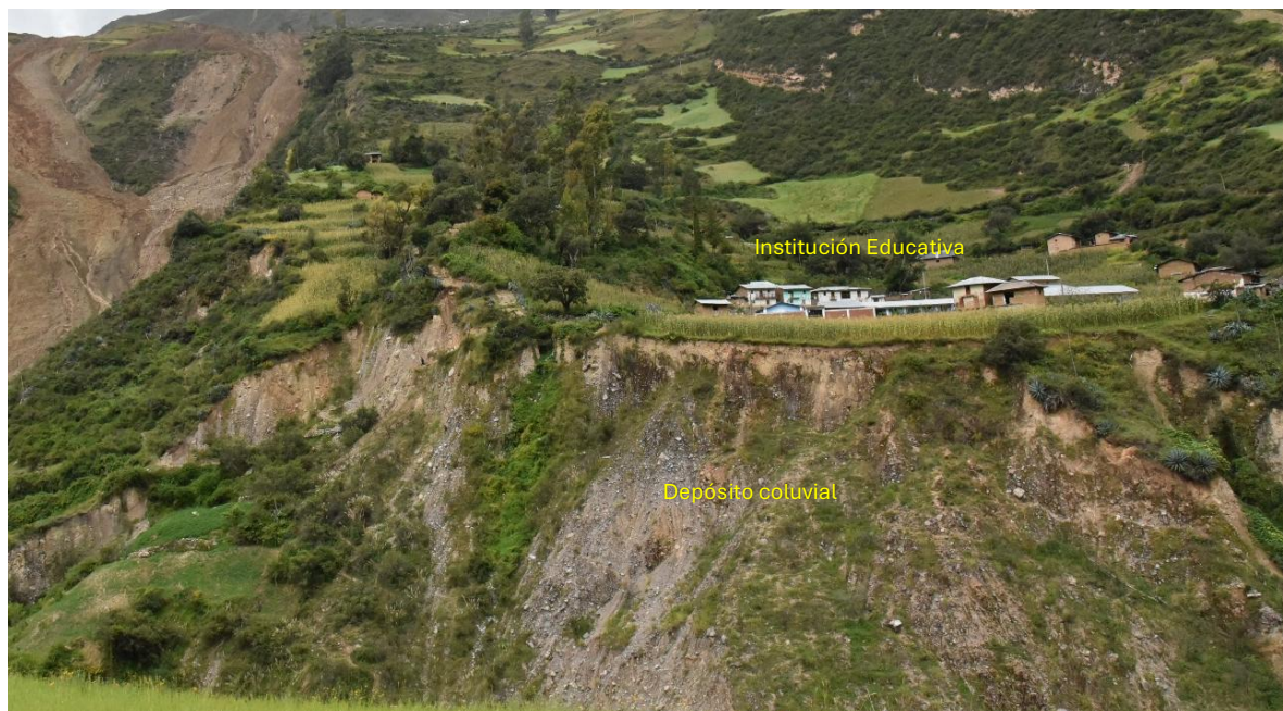
Figura 11. Depósitos coluviales en la margen derecha de la quebrada Sanachgan.
