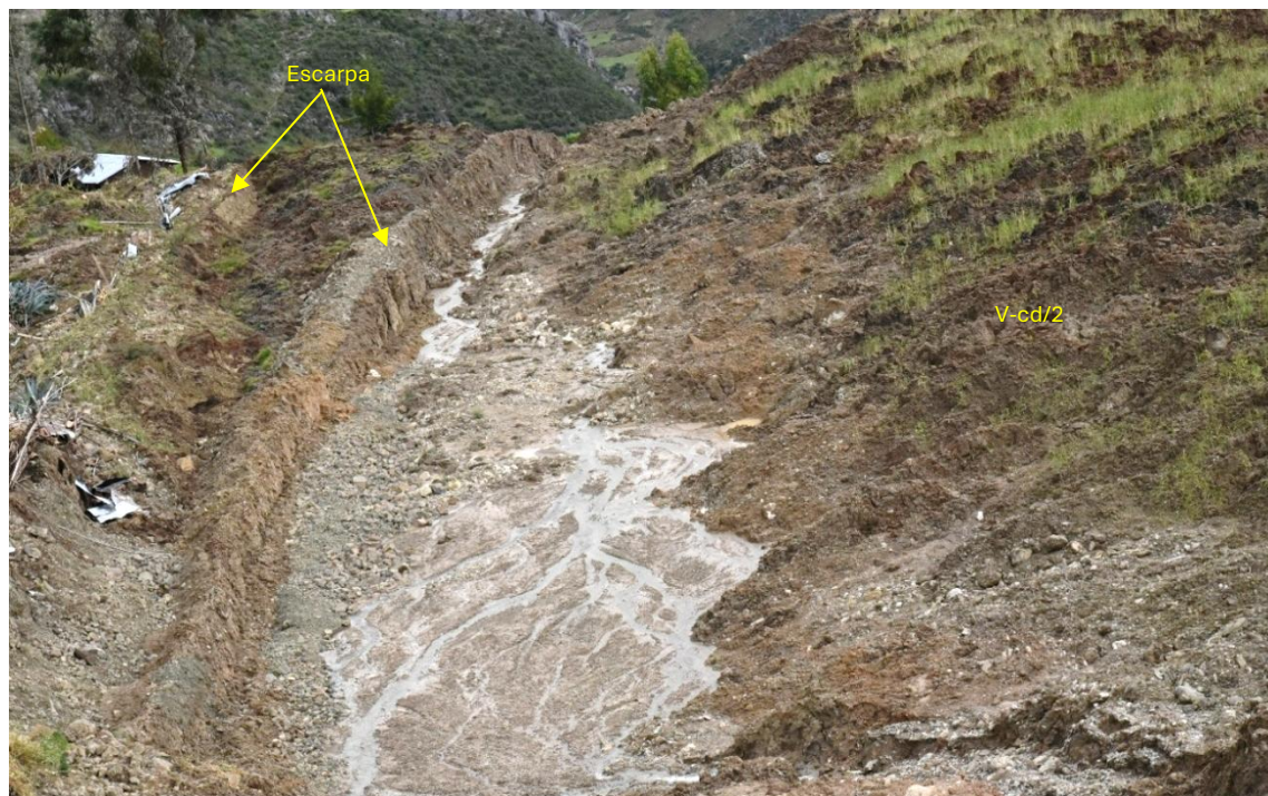
Figura 16. Vista de acercamiento de la subunidad de vertiente coluvio-deluvial 2, conformado por los depósitos del deslizamiento activo. Se observan escarpas longitudinales de hasta 2 m de alto, así como un cause pequeño de agua y una superficie rugosa.
