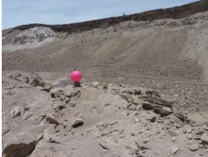
Fotografía 2: Hito anclado sobre la masa deslizada del deslizamiento de Sigwas.
