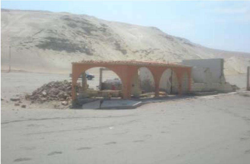
**Fotografía 3.1** Vista de vivienda de material noble destruida por el tsunami, al sur de Camaná.
