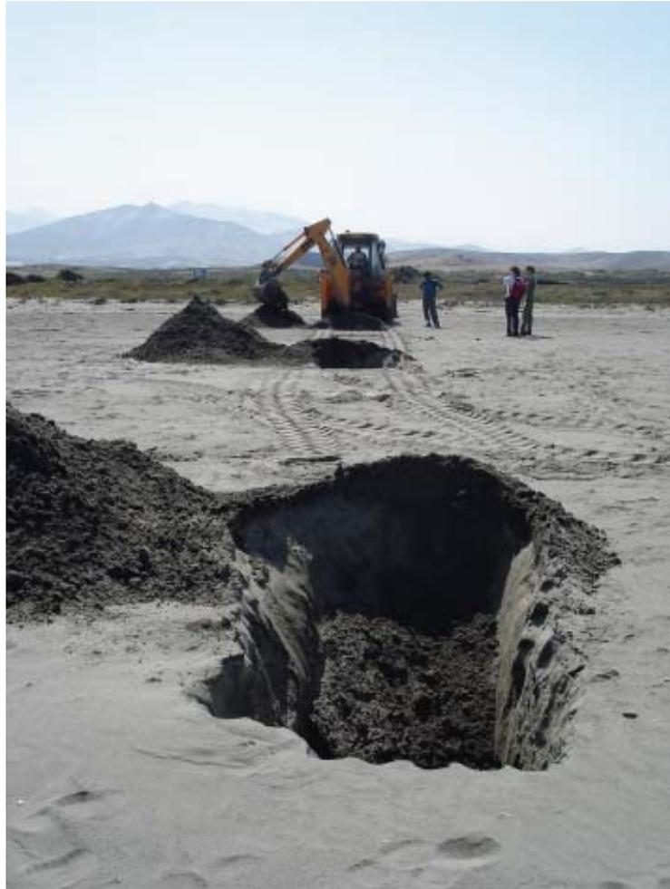
**Fotografía 1.1** Utilización de retroexcavadora para la excavación de trincheras.
