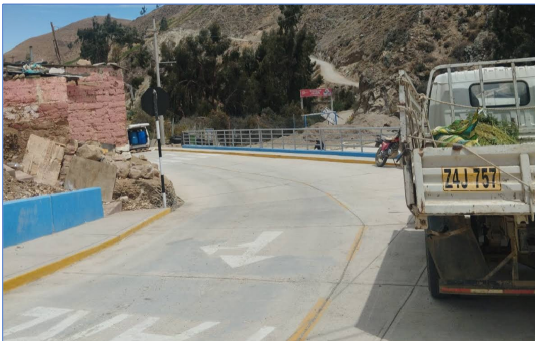
Fotografía 5 – Vista de vía principal TA-602
