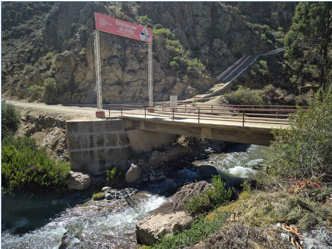
Fotografía 3 – Vista del puente Vilavilani al ingreso del centro poblado Vilavilani, TA-602
