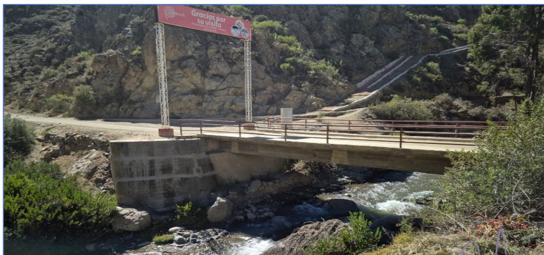
Ilustración 32 Cauce fluvial al ingreso de centro poblado
