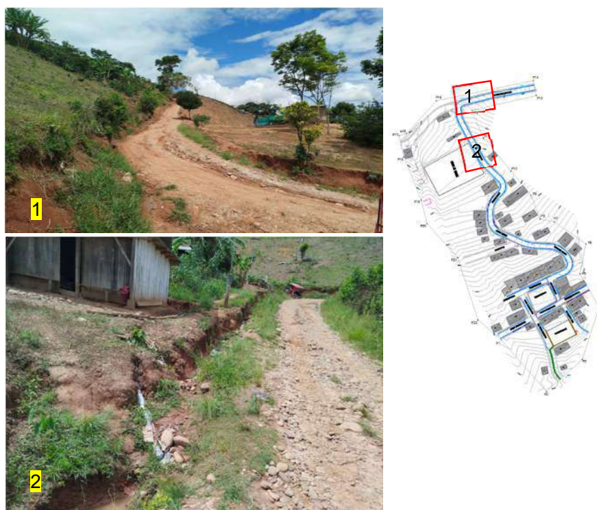
Figura N°15: Vista del sistema de drenaje existente – Zona de ingreso
