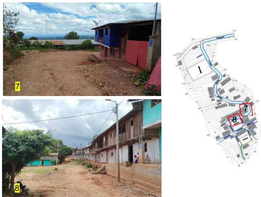
Figura N°18: Vista del sistema de drenaje existente – zona baja
