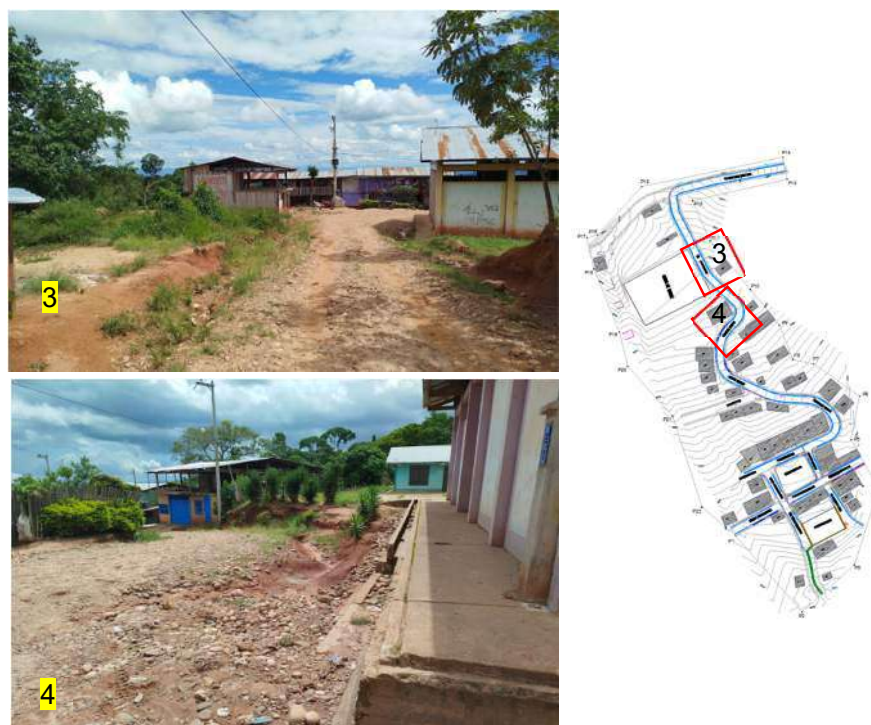
Figura N°16: Vista del sistema de drenaje existente – Jr. Principal C-01
