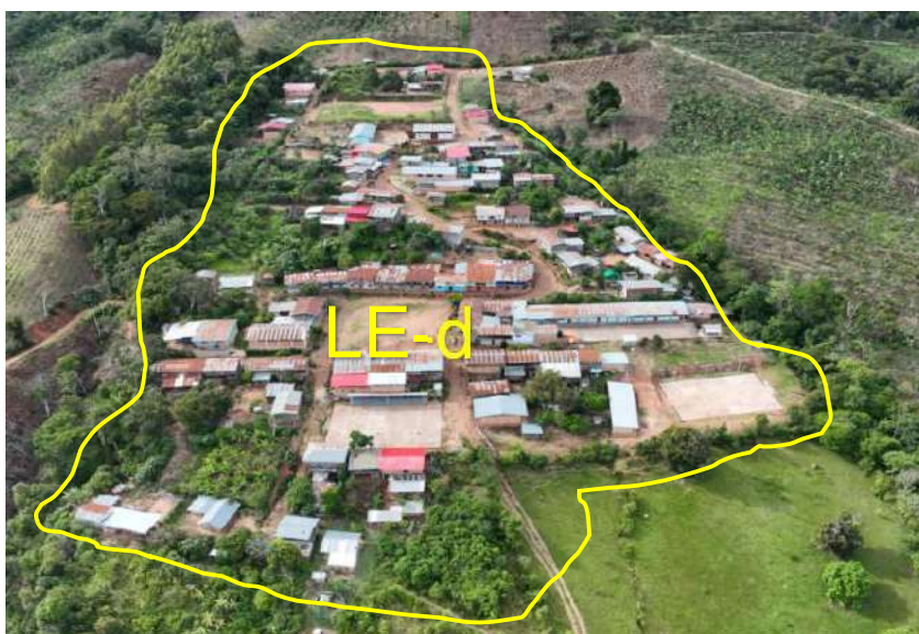
Figura N°8: Zona de ladera ocupada por la acción humana
