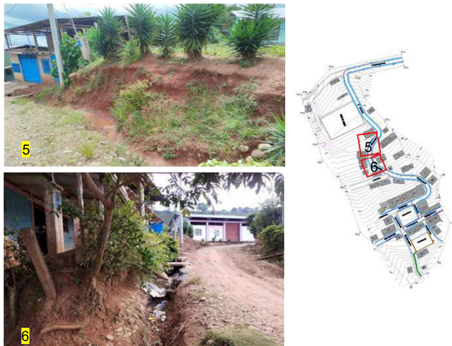
Figura N°17: Vista del sistema de drenaje existente – Jr. Principal C-02
