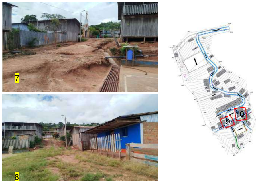
Figura N°19: Vista del sistema de drenaje existente – zona baja
