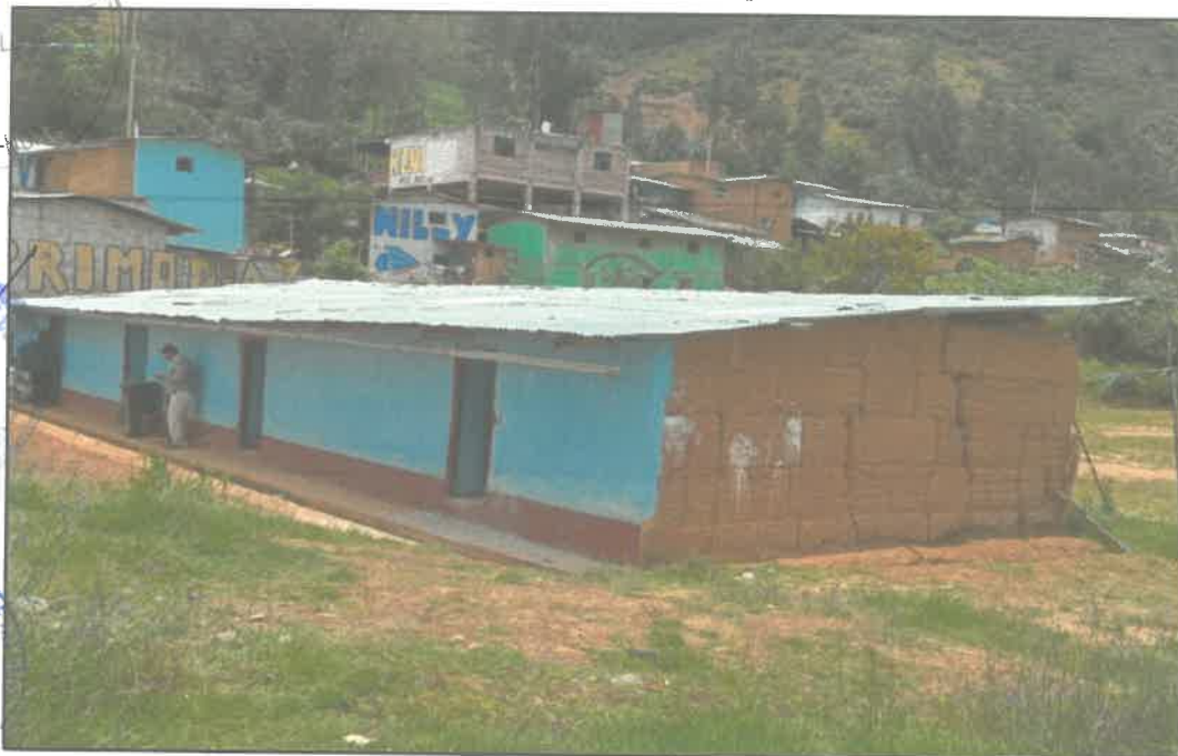
Vista N° 15: Se observa que las viviendas colindantes se encuentran expuestas al peligro de deslizamientos; la información ha sido registrada en la Ficha Técnica N°-12.
