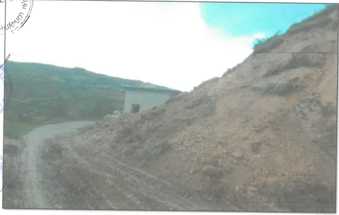
Vista N° 13: Se observa que las viviendas y vías vecinales se encuentran expuestas al peligro de deslizamientos; la información ha sido registrada en la Ficha Técnica N°-10.
