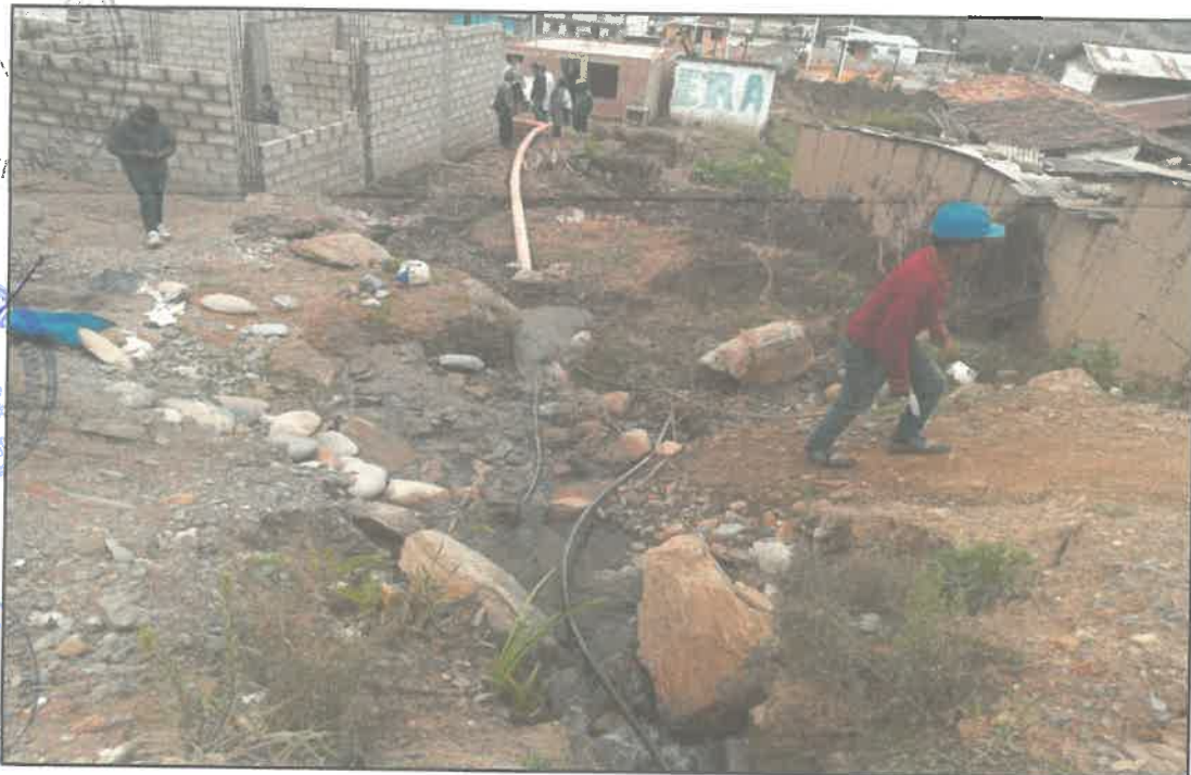
Vista N° 09: Se observa punto crítico ante inundación por incremento de flujo en los canales de riego y en el riachuelo afectando a varias viviendas, la información ha sido registrada en la Ficha Técnica N°-06.
