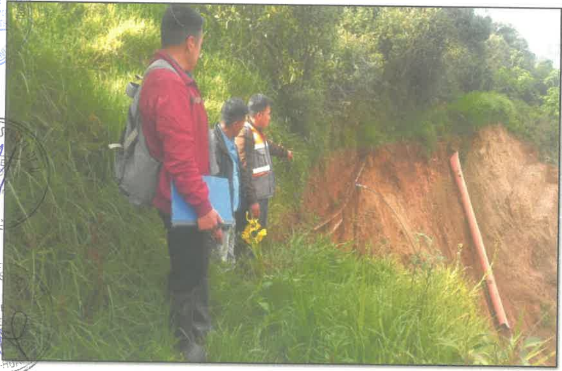
Vista N° 14: Se observa que las viviendas colindantes se encuentran expuestas al peligro de deslizamientos; la información ha sido registrada en la Ficha Técnica N°-11.
