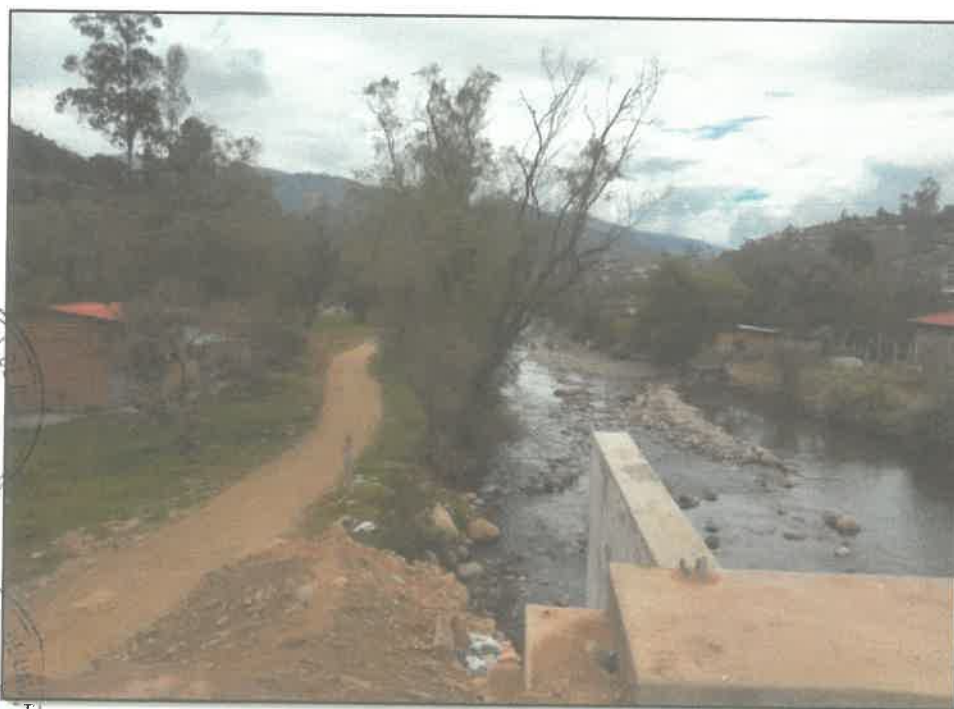
Vista N° 08: Se observa el punto crítico por inundación por lluvias intensas por la creciente del río al encontrarse las viviendas en zona de baja pendiente; la información ha sido registrada en la Ficha Técnica N°-05.
