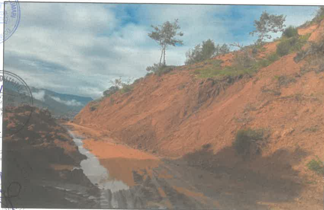
Vista N° 10: Se observa que las vías vecinales son afectadas por el deslizamiento productos de peligro de deslizamientos; la información ha sido registrada en la Ficha Técnica N°-07.
