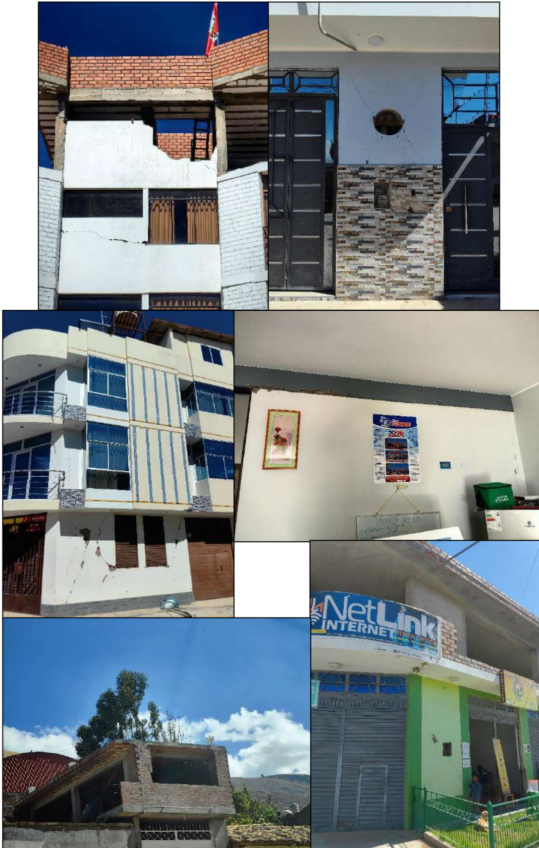
Figura 49.- Daños en algunas edificaciones de albañilería con más 1 nivel
