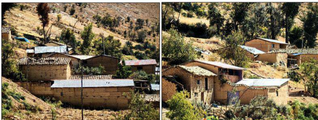
Figura 34.- Viviendas de adobe cerca al sector inferior de Pumpunya sin daños graves
