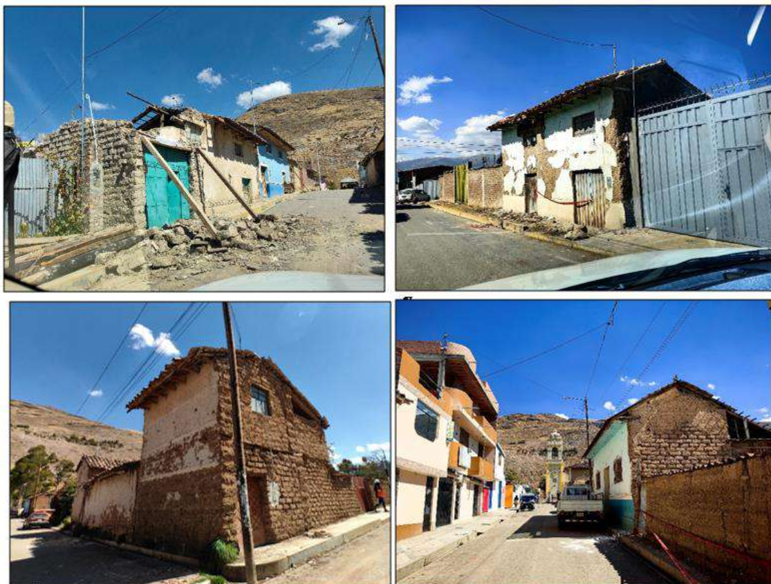
Figura 48.- Daños leves y aislados en algunas edificaciones en el núcleo urbano de Chongos Bajo, y otros a pesar de tener vulnerabilidad alta, no presentan daños
