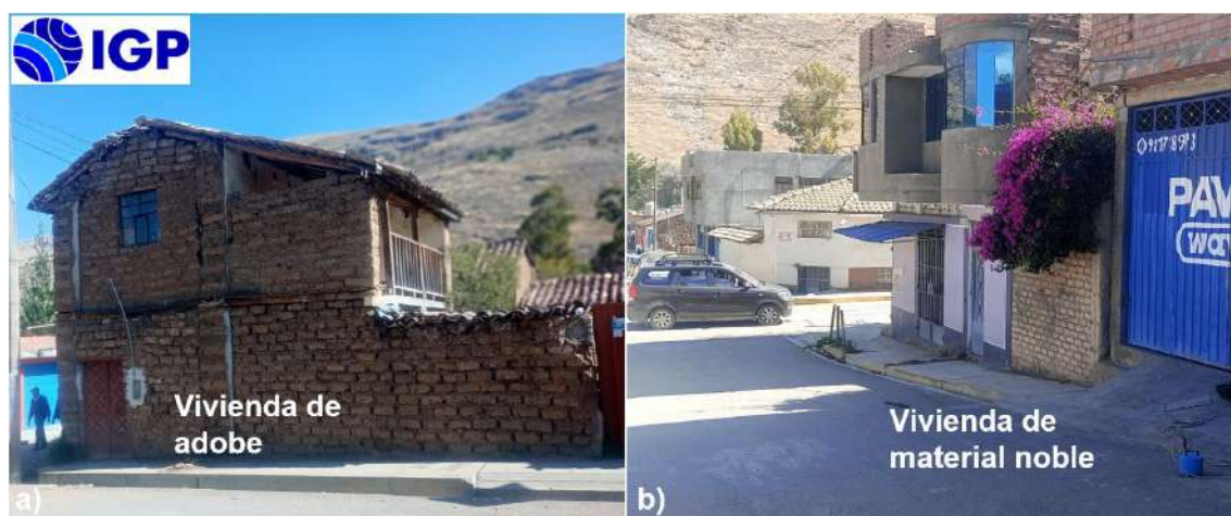
Figura 52.-. Viviendas de dos pisos con diferente material de construcción, de adobe (a) y de material noble (b)
