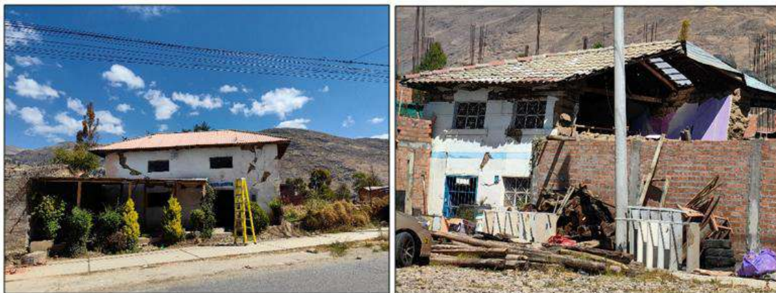
Figura 45.- Viviendas de adobe con daños moderados y graves en el sector Barrio Saños
