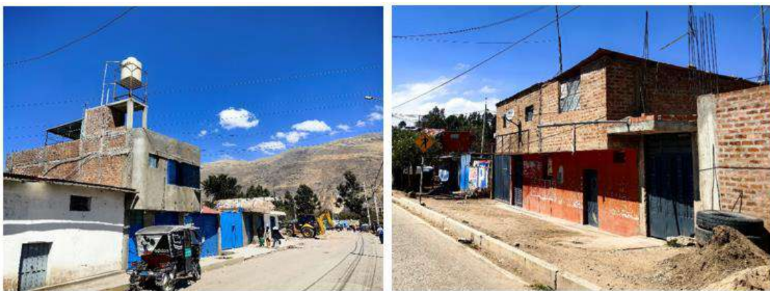
Figura 38.- Izquierda: Edificaciones de múltiples niveles (1 y 2 pisos) y distintos materiales sin daños observables. Derecha: Vivienda altamente vulnerable de 2 niveles sin daños aparentes.
