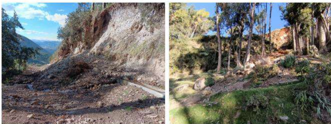
Figura 21.- Eventos de movimientos en masa producto del sismo de 18 de julio de 2026 en el distrito de Chupaca. Izquierda: Pumpunya y derecha: Sector Estrellita
