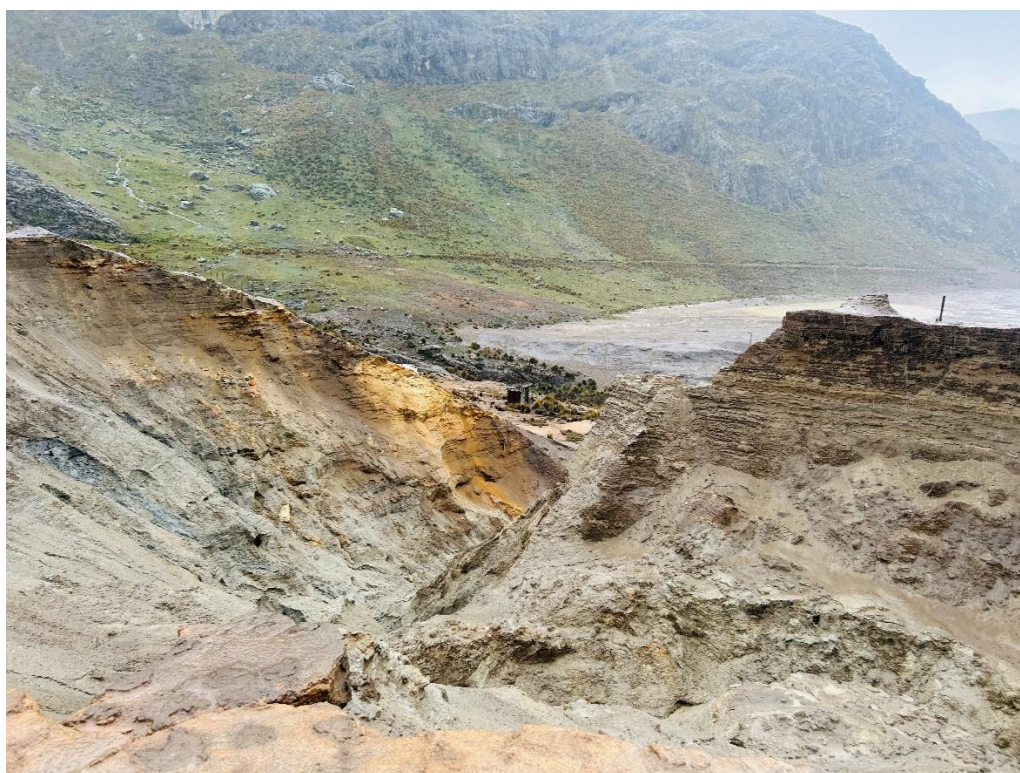
Fotografía 4. Procesos de erosión de laderas (cárcavas) que afectan el depósito de relave (ID 13063). Coordenadas WGS 84, 18L, X: 342684 m E; Y: 8720272 m S.
