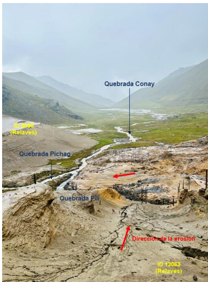
Figura 6. Vista de los procesos de erosión de laderas y el material de remoción, generado por la erosión, el cual se canaliza por las quebradas Pili y Pichag. Vista desde las coordenadas WGS 84, 18L, X: 342617 m E; Y: 8720264 m S.
