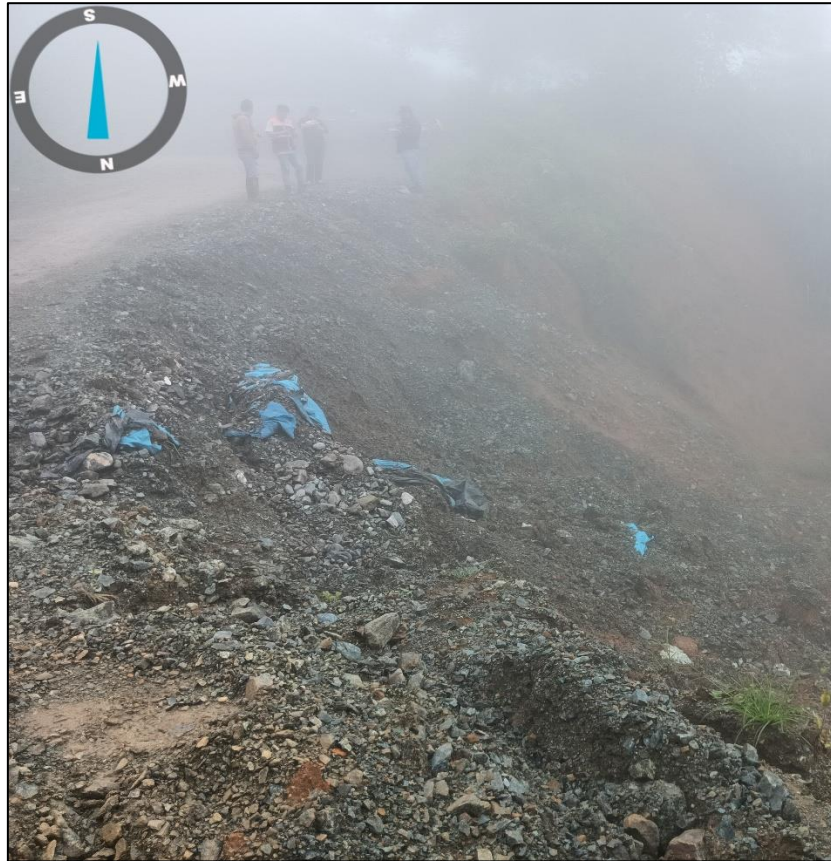
Figura 7. Depósito proluvial, compuesto por material angulosos a subanguloso. Conformados por cantos (5%), gravas (50%), arenas (20%), limos (15%) y arcillas (10%). Coordenadas: E: 652837 /N: 9400383 / C: 1179.
