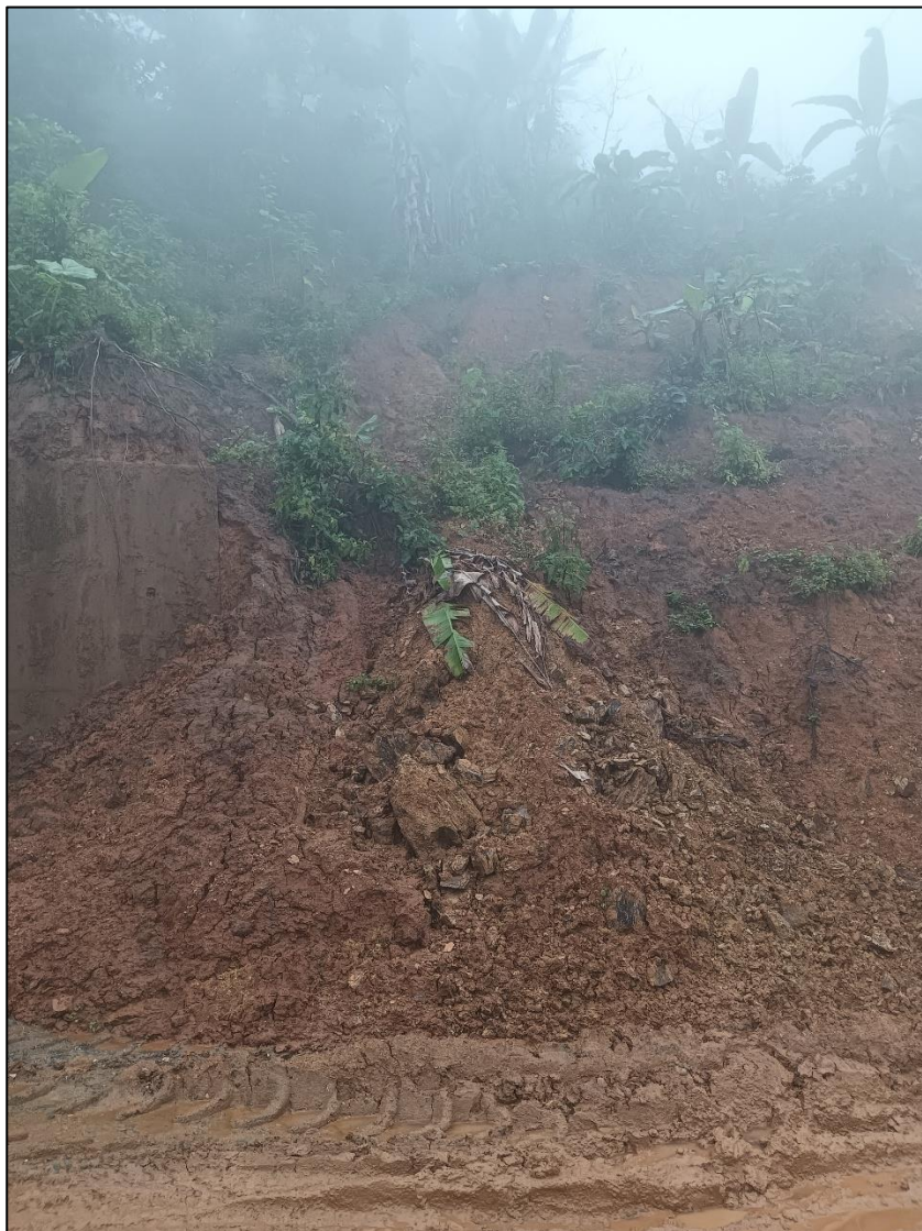
Figura 6. Depósito coluvio deluvial conformado por acumulaciones de gravas (10%), arenas (15%), limos (30%) y arcillas (40%). Coordenadas: E: 655485 /N: 99395970 / C: 1271.
