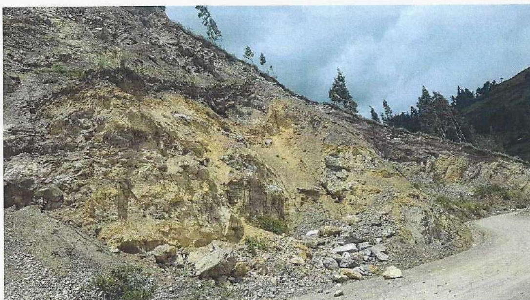
Figura N° 6. Estratos geológicos típicos en taludes de carretera del distrito de Talavera
