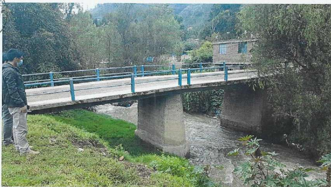
Fotografía N° 6: Verificación de sectores críticos ante inundaciones y elementos expuesto en localidad de Santa Rosa, distrito Talavera.
