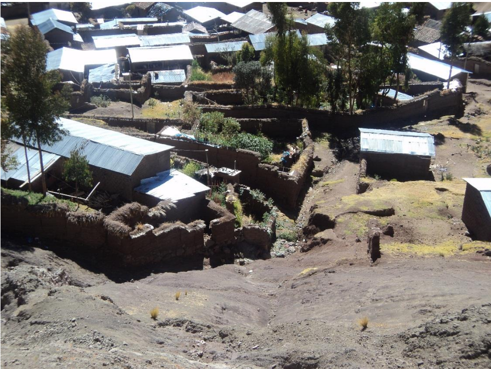
Fotografía N° 02: Vista de quebradas donde se ubica muy cerca a las viviendas
