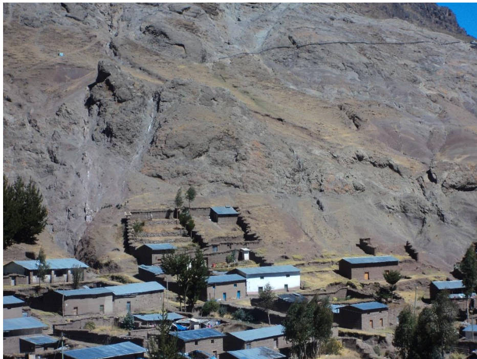
Fotografía N° 06: Viviendas ubicadas cerca de ladera del cerro conformado por cárcavas y deslizamiento de tierras.
